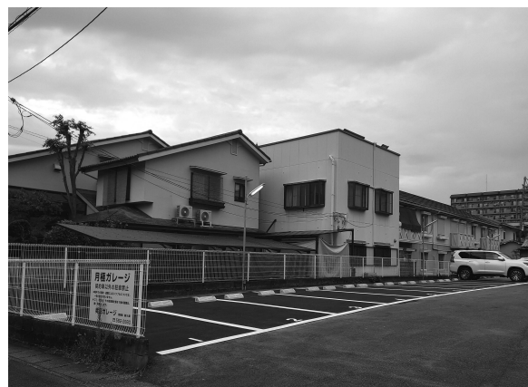
図30 27次 復旧完了風景（南東から）
