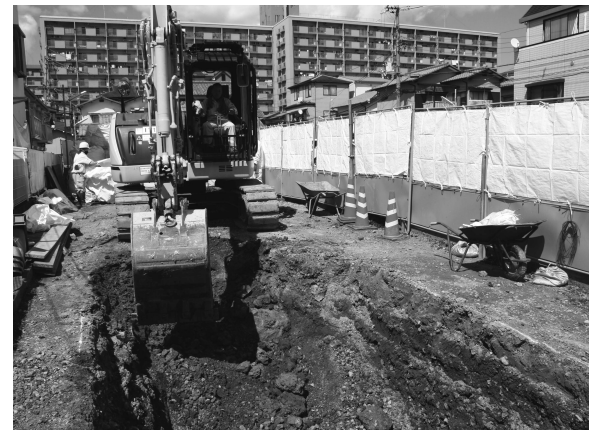
図20 27次 重機掘削風景（南から）
