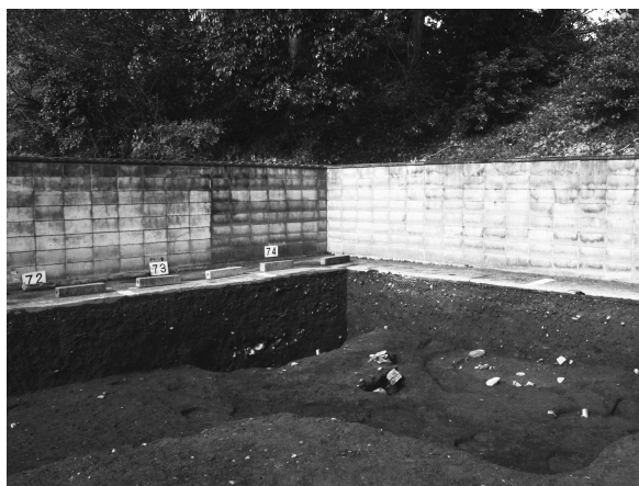
図4 23次 調査地と土塁の関係(南東から)
