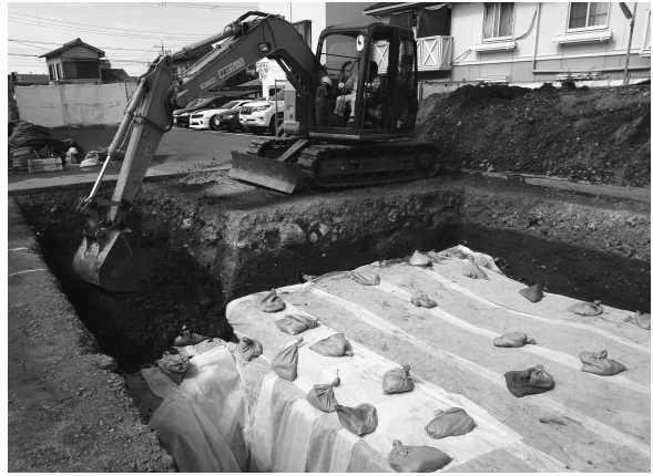
図18 25次 埋め戻し風景（北東から）
