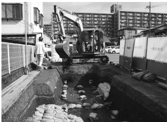
図29 27次 埋め戻し風景（南から）
