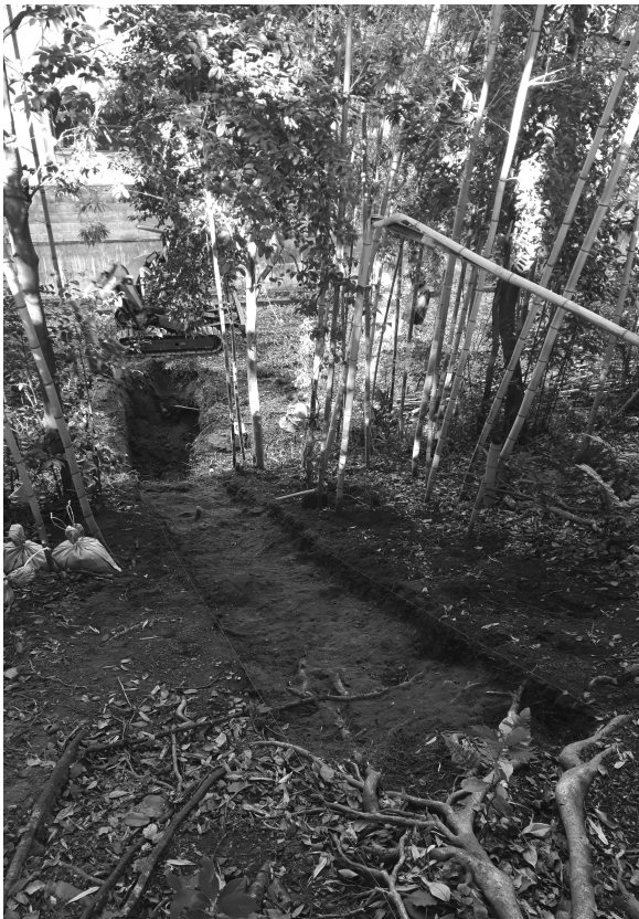
図9 24次 重機掘削風景（南西から）
