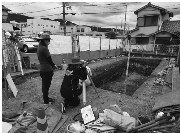
図25 27次 ボランティア受入風景（北西から）
