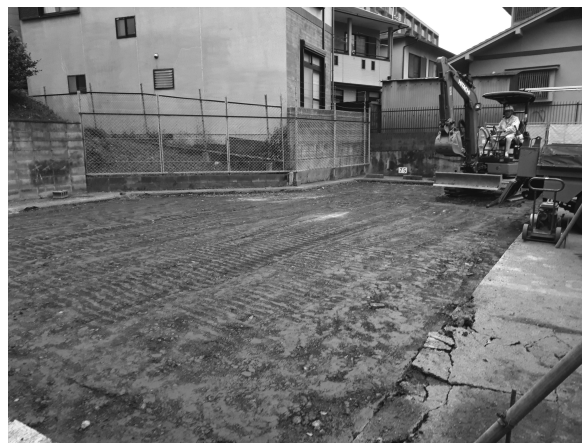
図7 23次 埋め戻し風景(南西から)
