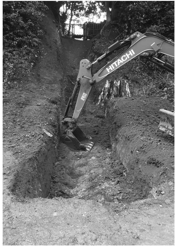
図10 24次 埋め戻し風景（北から）
