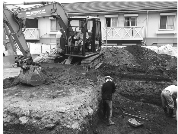
図14 25次 重機掘削風景（東から）
