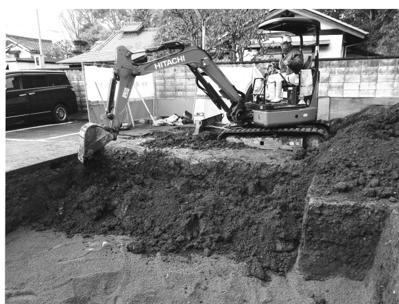
図6 23次 埋め戻し風景(北東から)
