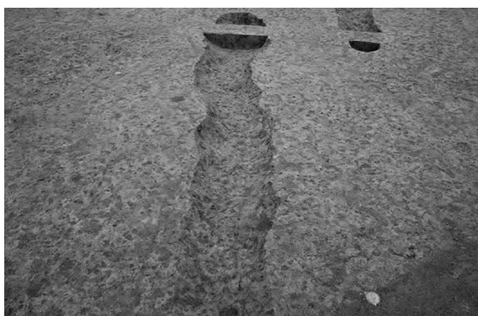
SN504 断面 (南東から)
