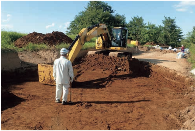
重機による掘り下げ 平成30年8月22日
