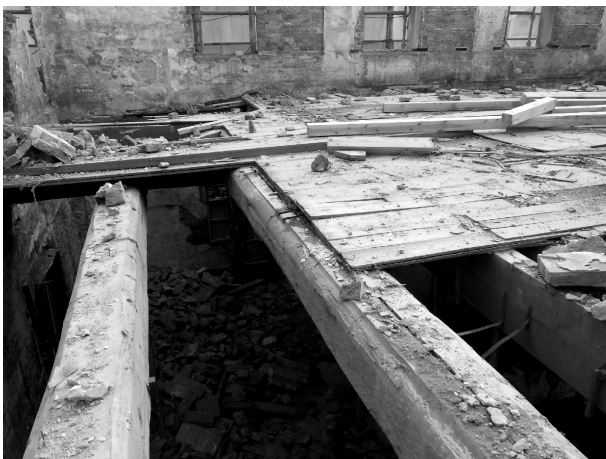
写真 2-6 2階床組解体状況（東側・北から）
