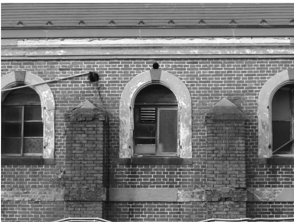
写真 3-9 擬蛇腹石（外壁南面の洞蛇腹）
