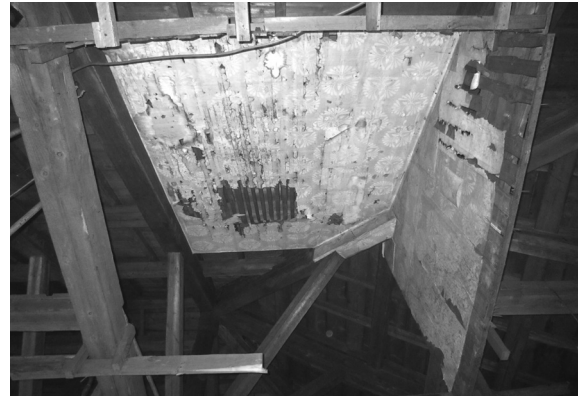
解体工事 28 小屋裏の内装（南東部・南から）
