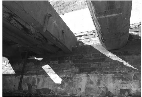
解体工事 20 2階床梁・北壁の接続（東側・南から）
