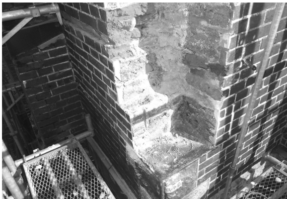
解体工事 15 隅石取外し (南西隅)
