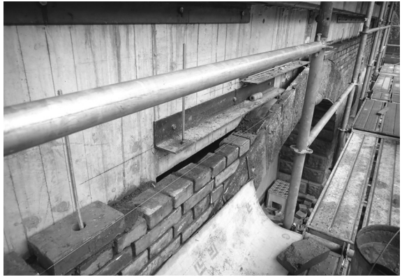
レンガ添え積み工事 2（東面 1 階・南東から）
