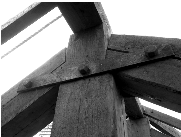
写真 3-16 緊結部の加工ボルト
