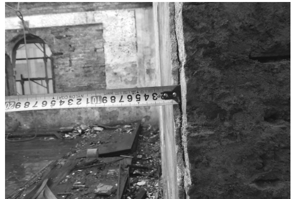
解体工事 46 同（西面2階・北から）
