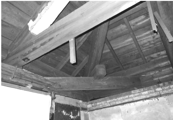
解体工事 27 小屋組・火打ち梁（南西隅）
