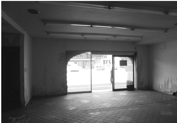
移築前 3 内部 (1階中央アーチ・南西から)
