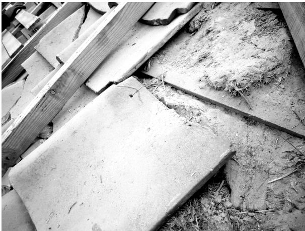
写真 3-18 瓦葺きの状況（西面・南西から）
