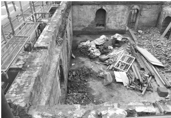
解体工事 13 2階床梁解体後 (東から)
