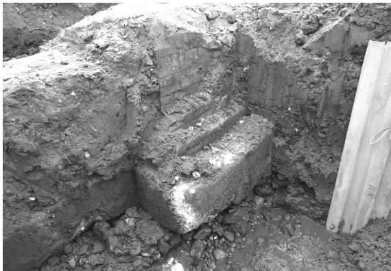
解体工事 5 同 (西面中央パツス外側・北西から)
