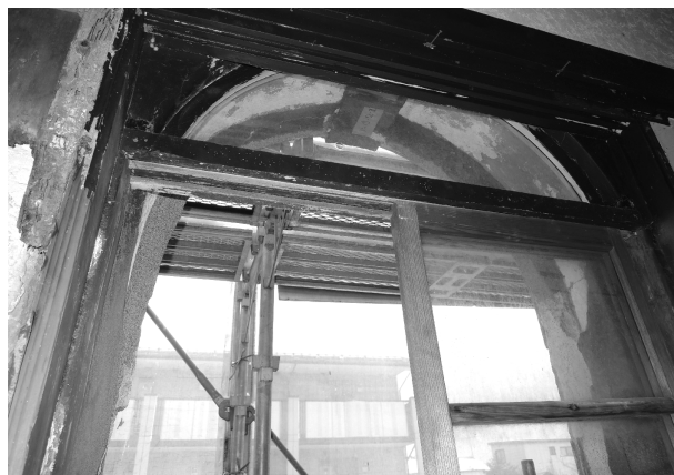
写真 3-27 当初と見られる窓枠（南面 2階・西側）
