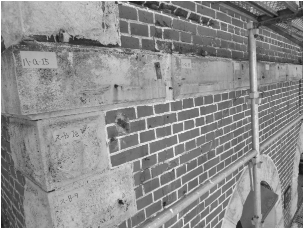
写真 3-8 洞蛇腹設置状況（外壁北面・北東から）
