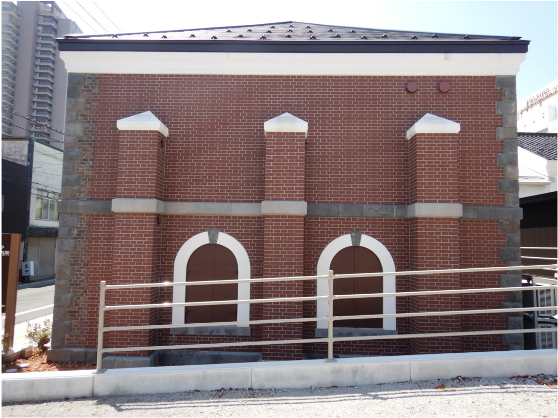
3 竣工 側面（北面）
