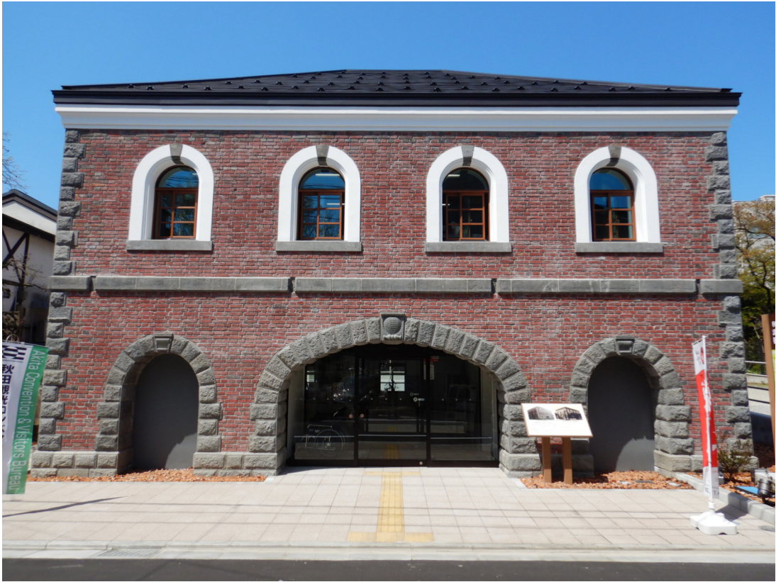
1 竣工 正面（東面）
