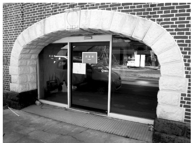
写真 3-10 正面1階中央アーチ（外壁北面）
