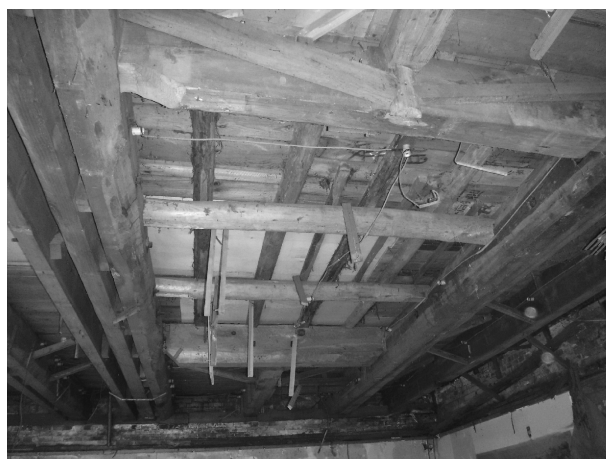
写真 3-15 後年の改造跡（西側・北から）
