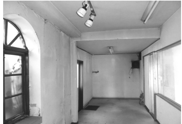
移築前 4 内部 (1階東側・北から)
