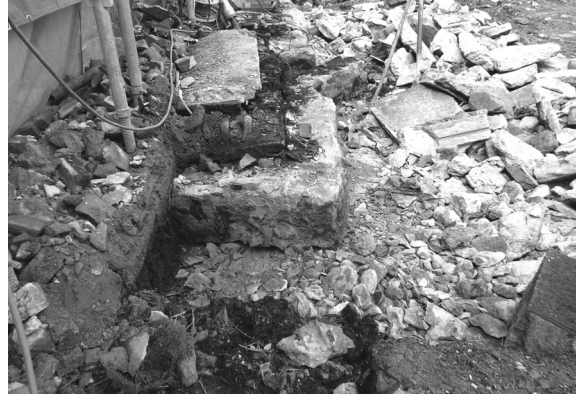
解体工事 2 同 (南面中央・東から)
