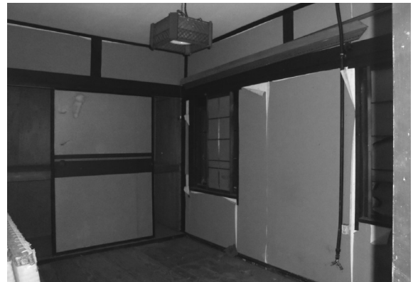
移築前 6 内部 (2階北西側・南東から)
