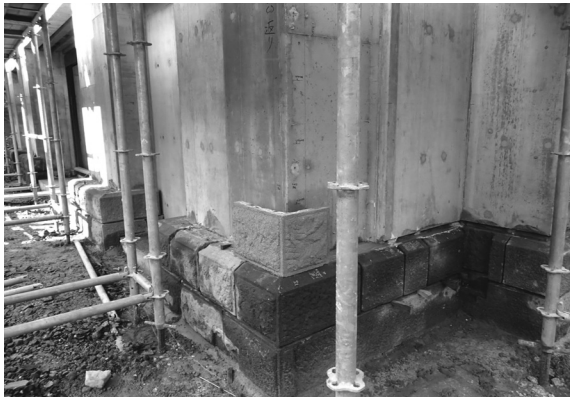
石工事 1 基礎・隅石（北東から）
