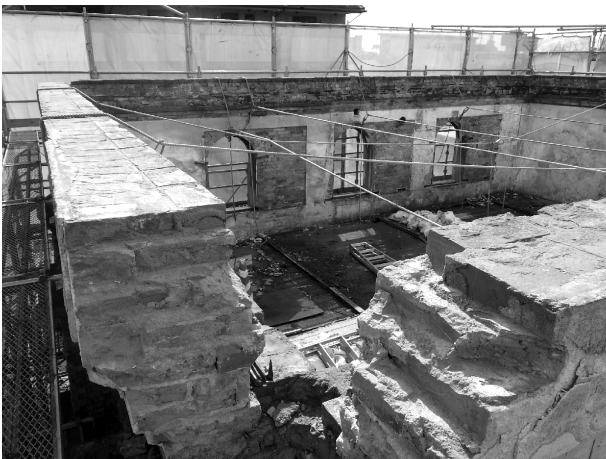
写真 3-3 躯体レンガ（外壁東面2階・北から）
