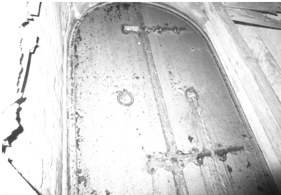
解体工事 37 鉄扉内側（西面1階・北側）
