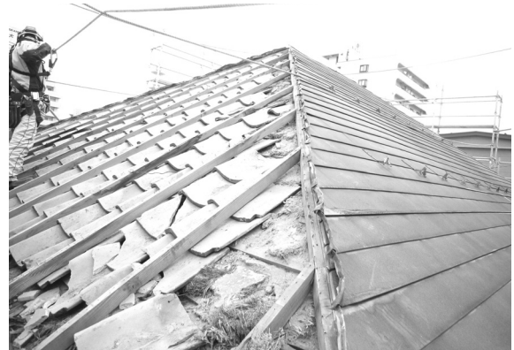
解体工事 30 同（西面・南西から）
