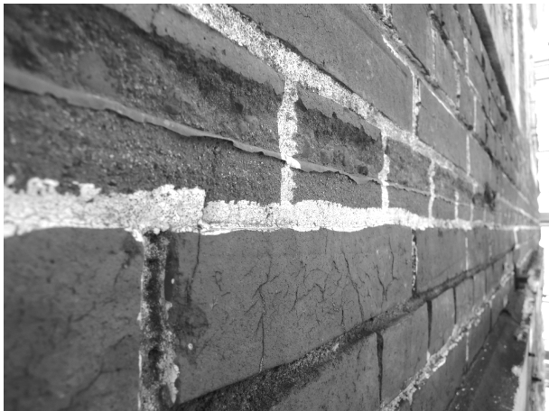
写真 3-20 埋め込まれた鉄板(外壁北面・東から)
