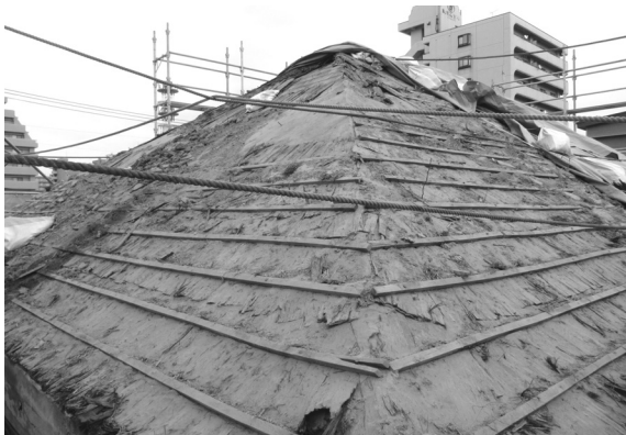
解体工事 31 棧瓦下の土葺き（南西から）
