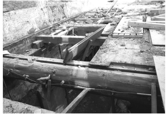
解体工事 22 2階床組（西側・西から）
