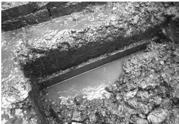
解体工事 7 同コンクリート底盤の型枠 (北東隅)
