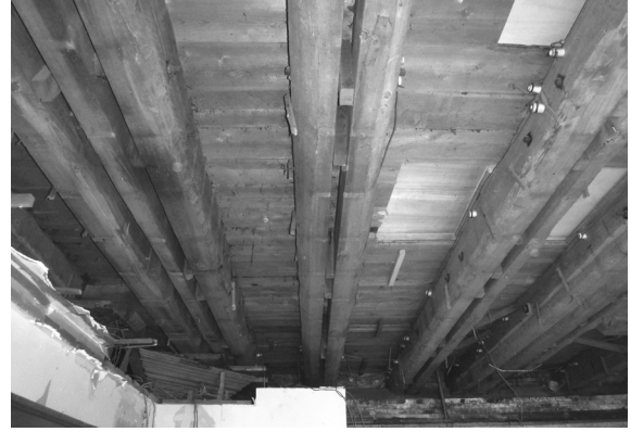
解体工事 18 同（中央・北から）
