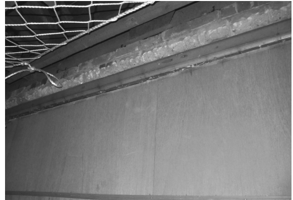
解体工事 44 天井廻り縁（西面2階・北東から）
