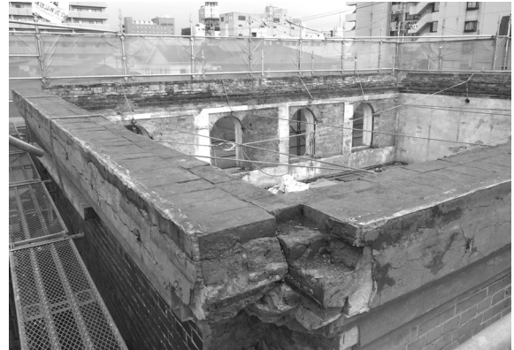
解体工事 12 小屋組解体後 (南西から)
