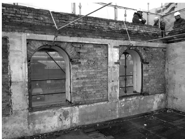
写真 3-13 内部壁面（北面2階・東側）
