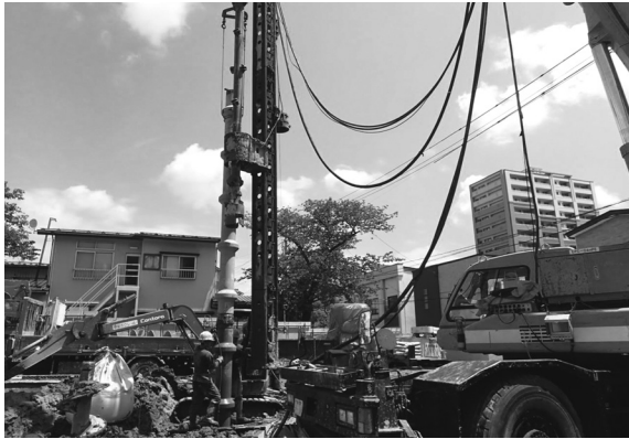
杭工事 1 (南から)
