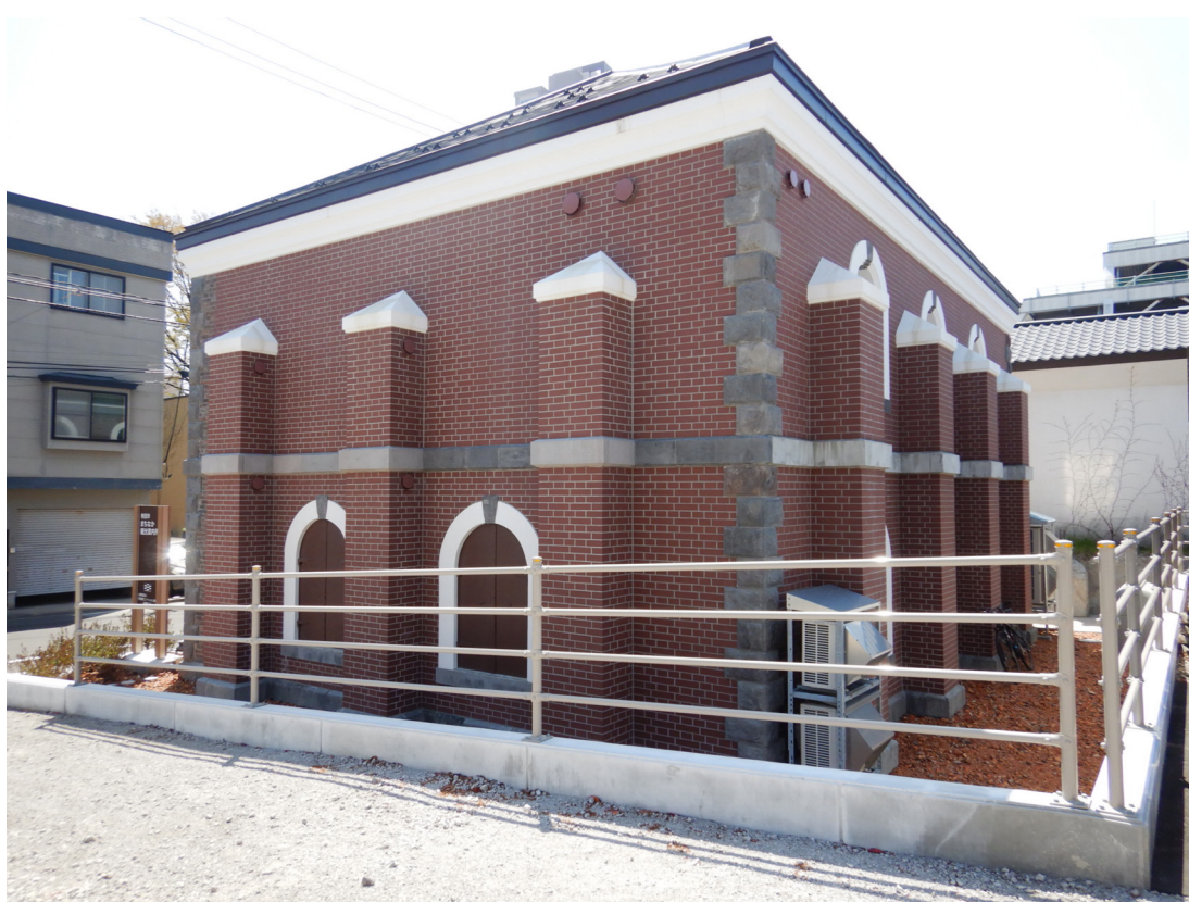
4 竣工 側背面（北西面）
