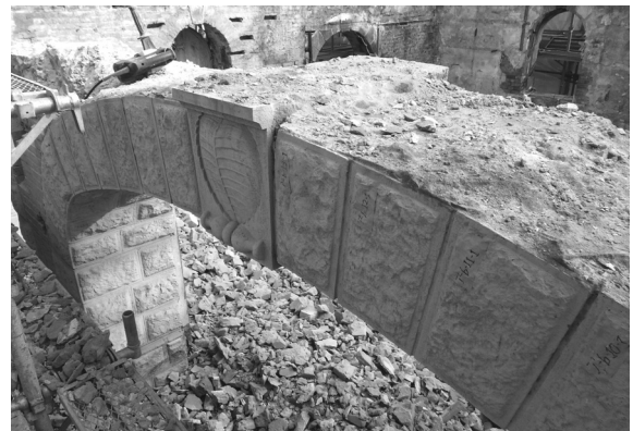
解体工事 16 中央アーチ (北面1階・北西から)
