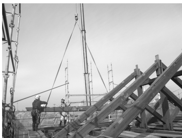
写真 2-4 小屋組解体状況（西桁・東から）
