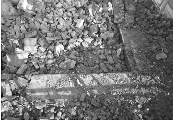
解体工事 1 地上部の土台石 (南西隅)
