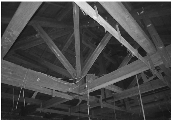
解体工事 23 小屋組トラス（南西から）
