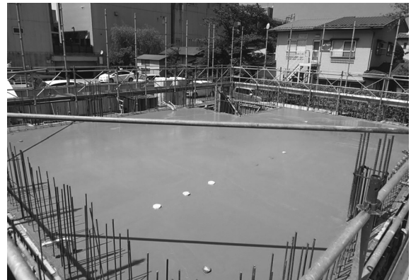
コンクリート工事 1 2階床梁 (南東から)
