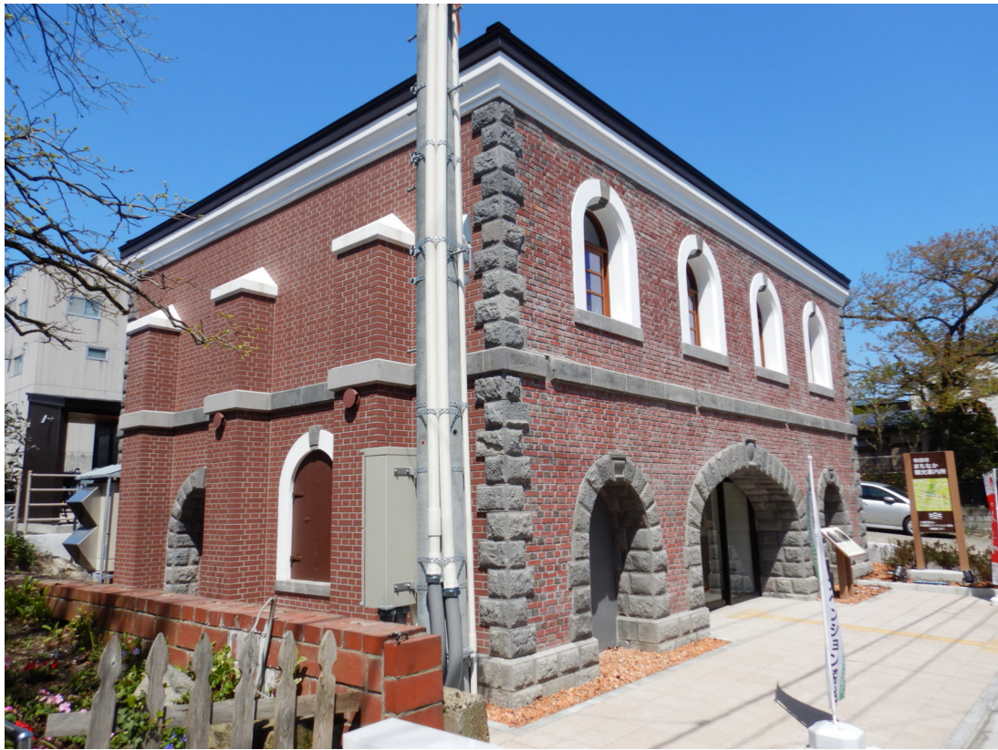
2 竣工 正側面（南東面）
