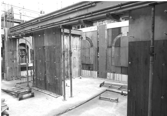
型枠工事 1 1階内部 (南東から)
