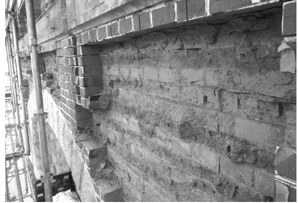
解体工事 10 同 (北面2階・北西から)
