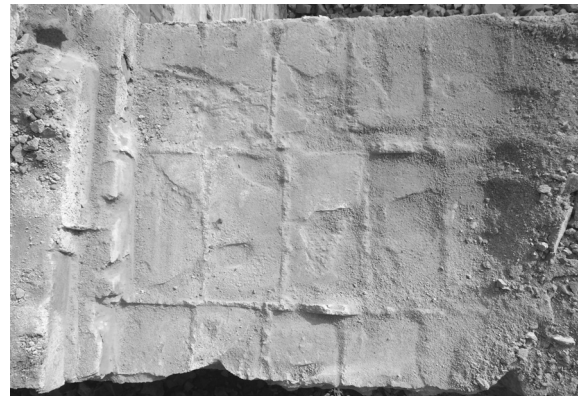
解体工事 14 躯体レガ 長手1枚取外後 (北面1階)
