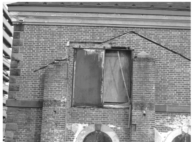
写真 3-4 後年の開口部（外壁西面2階）
