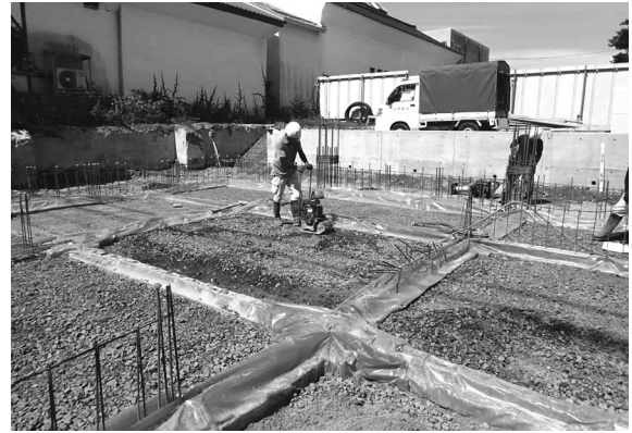
土工事 1 (北東から)
