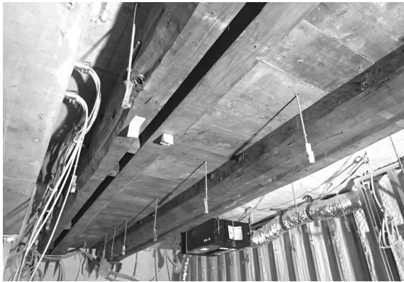
2階床梁・床板再現 1（1階南側・北西から）
