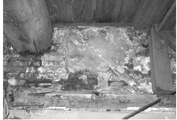
解体工事 42 階段（右）と旧ササ跡（1階東壁・南東）
