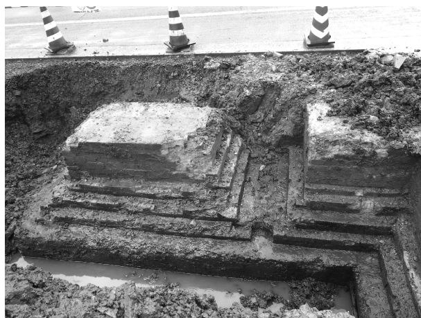
写真 3-2 地中の独立基礎（北面東側・南から）
