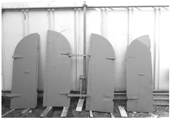
鉄扉設置工事 1 ケレン掛け・錆止め・塗装後
