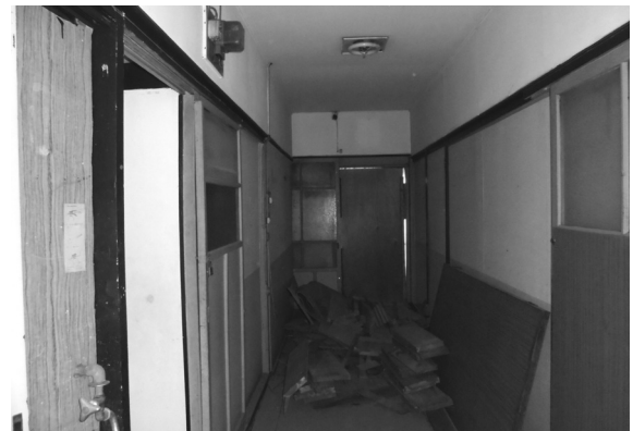
移築前 8 内部 (2階中央部・東から)
