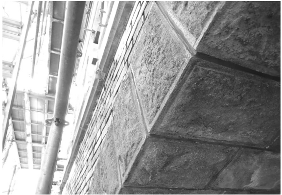
石工事 2 正面中央アーチ上部（東面 1 階）
