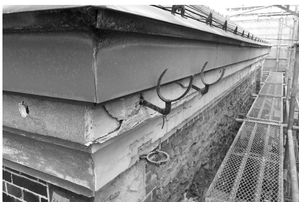
写真 3-22 雨樋の受け金具（外壁東面・南から）
