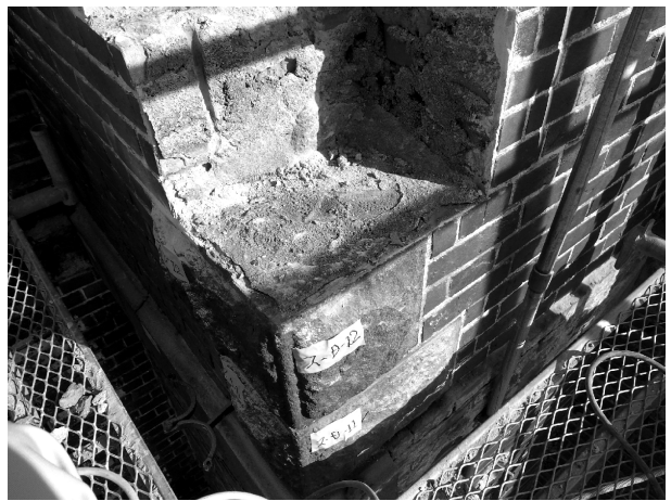
写真 3-7 隅石設置状況（外壁南西隅）
