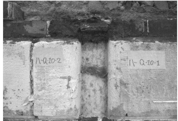
解体工事 36 同（北面・東から2つ目）
