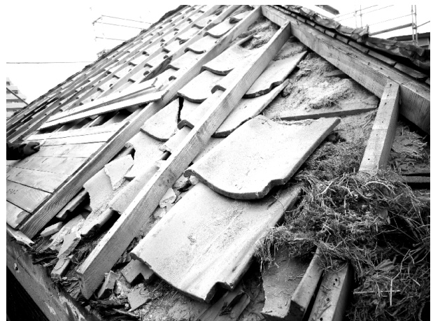
写真 2-1 鉄板葺き下の瓦葺き（西面・南西から）
