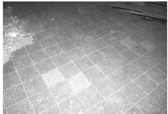
解体工事 48 1階タイル張りの床
