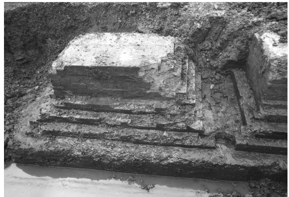
解体工事 6 同 (北面東側・南から)
