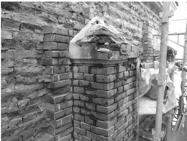
写真 3-6 バットレス（外壁東面中央・南東から）
