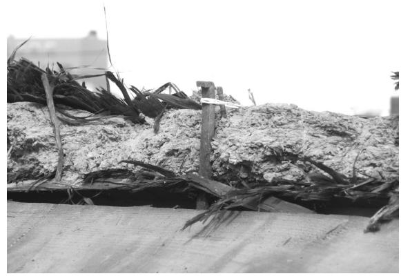
解体工事 34 棟頂部の鉤状金具（南から）
