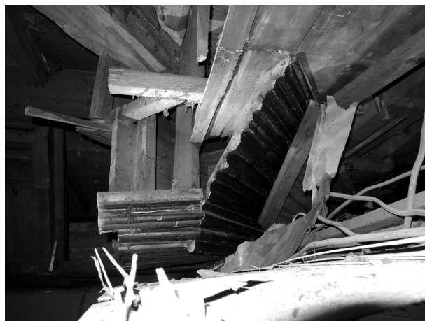
写真 3-25 天井蛇腹(1階南東部・北東から)
