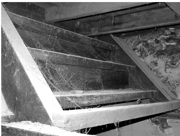
写真 3-23 残存した階段(1階南東部・南西から)
