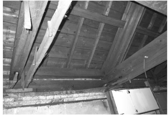
解体工事 26 小屋組端部（西壁・南東から）
