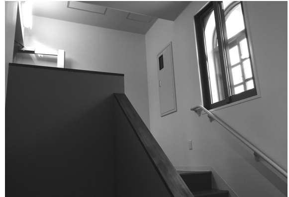
竣工 4 内部 (1階階段・北から)
