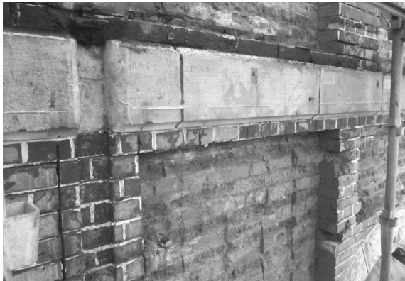
解体工事 35 バルコニー跡・金物（北面・西から2つ目）
