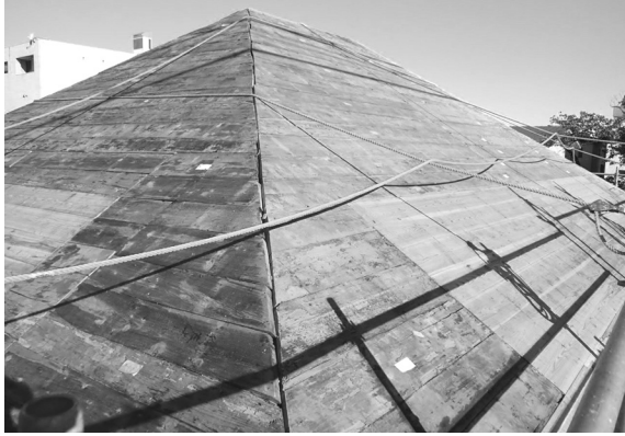
屋根工事 1 野地板（北西から）
