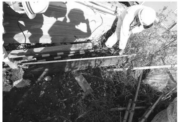
解体工事 8 地中コンクリート基礎下の杭木
