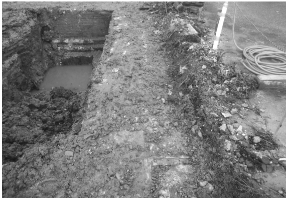
解体工事 3 地中のレンガ積・コンクリート基礎 (南東隅)
