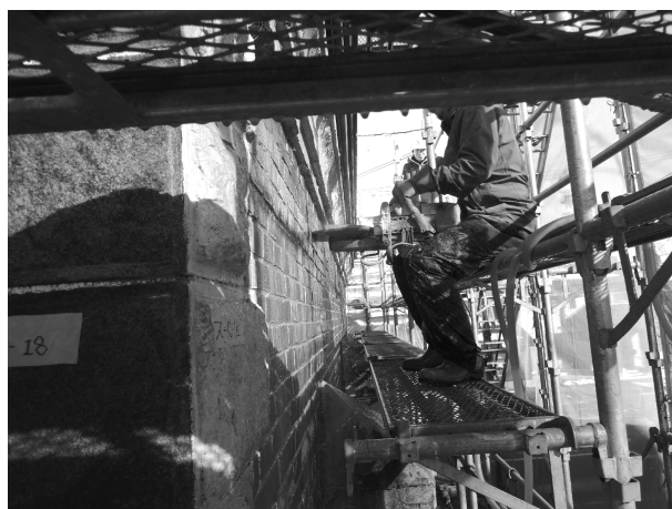
写真 2-2 レンガ解体状況（外壁東面・南から）
