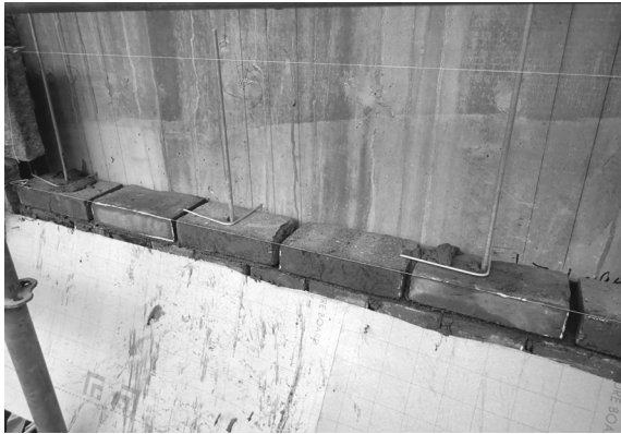
レンガ添え積み工事 1（東面 1 階・東から）
