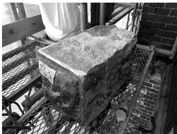
写真 2-3 石材解体状況（外壁南西の隅石）
