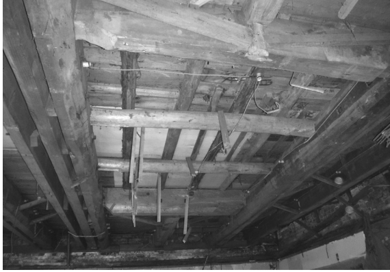
解体工事 17 2階の床梁・床板（西側・北から）
