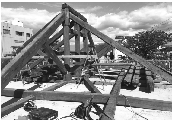
小屋組設置工事 1 (南東から)
