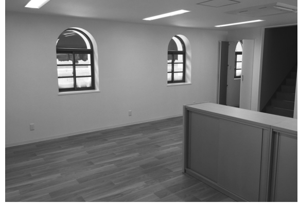
竣工 2 内部 (1階・南東から)
