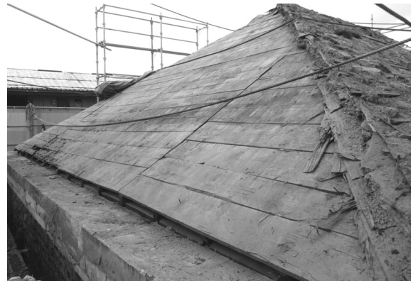
解体工事 32 棧瓦下の土葺き・野地板（北東から）
