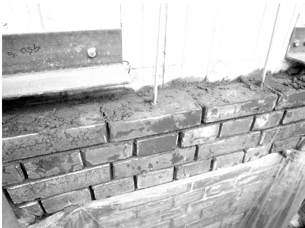
写真 2-8 既存レンガ添え積み状況（外壁東面）
