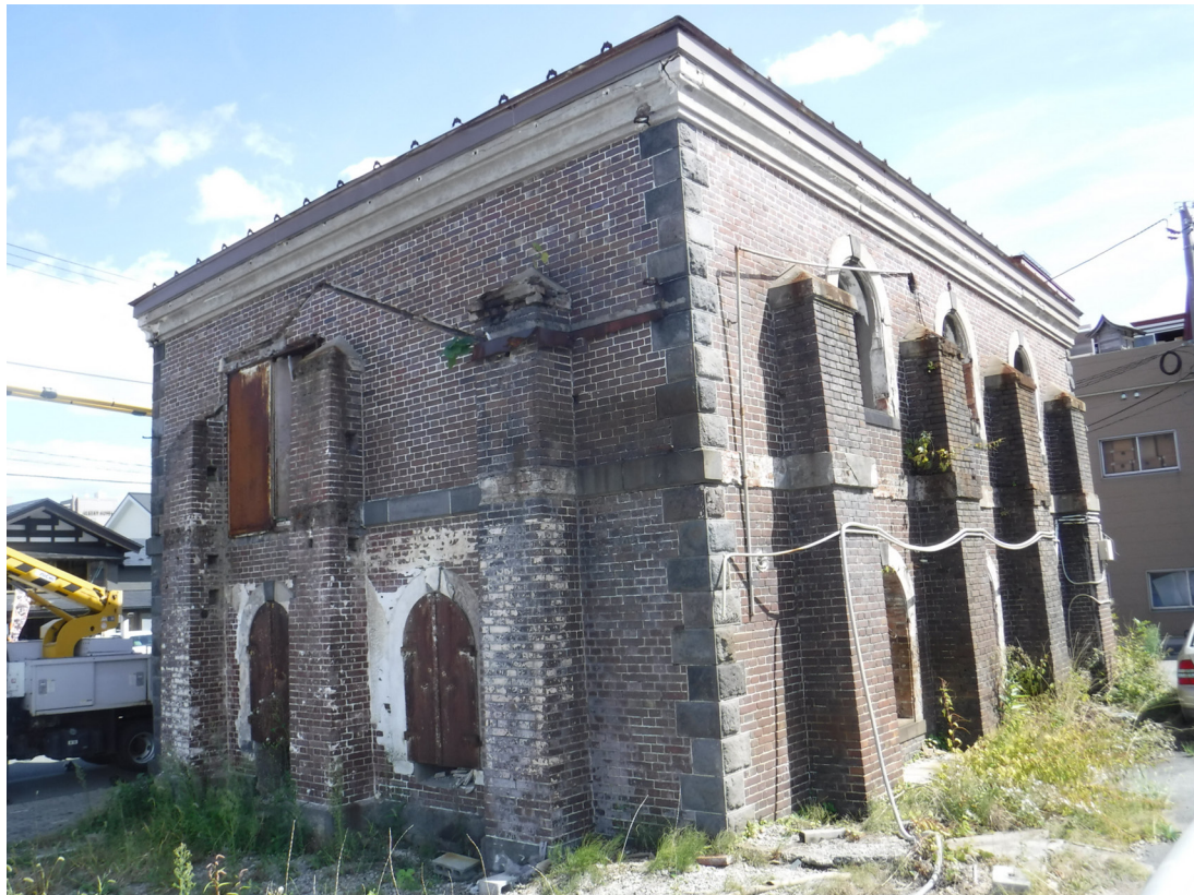
8 移築前 側背面（南西面）
