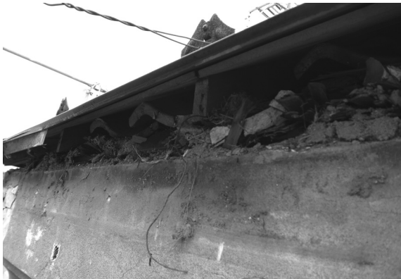
解体工事 29 鉄板葺き下の瓦（南面・南東から）
