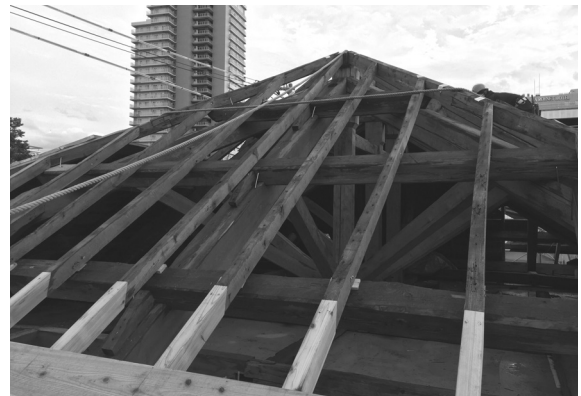
小屋組設置工事 2 (北西から)
