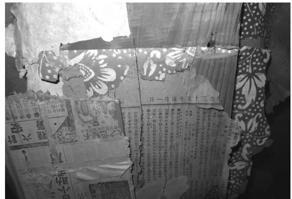
解体工事 40 旧天井の裏張り新聞（明治35年）
