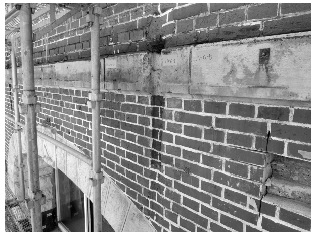
写真 3-19 バルコニーの痕跡 （外壁北面・西から2つ目）
