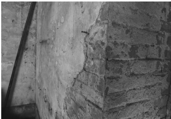
解体工事 47 同（西面1階・北から）
