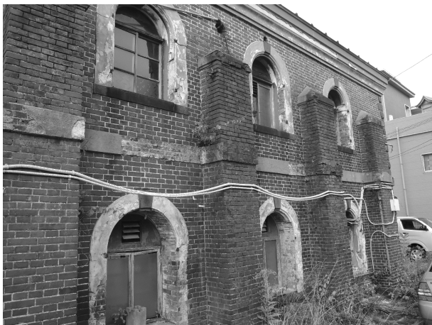
写真 3-28 躯体レンガ（外壁南面・南西から）
