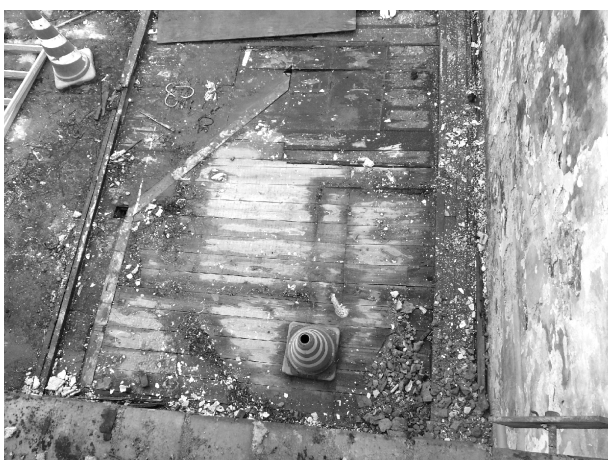
写真 3-24 階段の開口部跡(2階床面・南東部)
