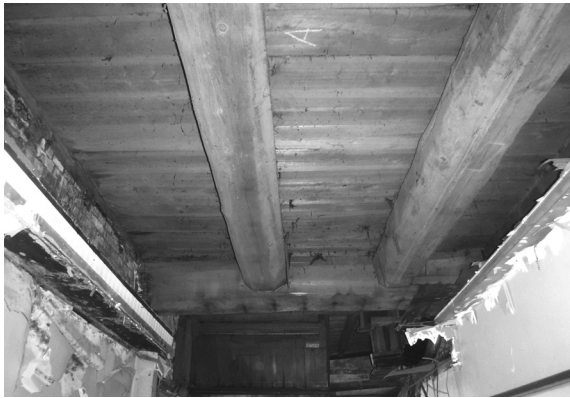
解体工事 19 同（東側・北から）
