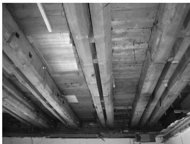
写真 3-14 2階床梁の構造（中央・南から）
