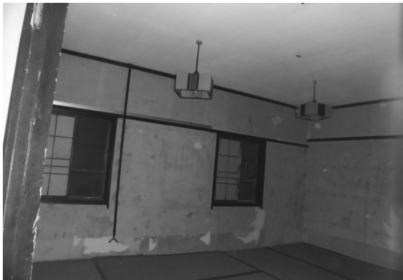
移築前 5 内部 (2階北東側・南西から)
