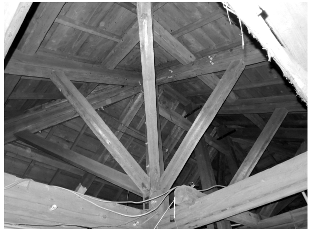
写真 3-17 木造洋式トラス組（西側・南西から）
