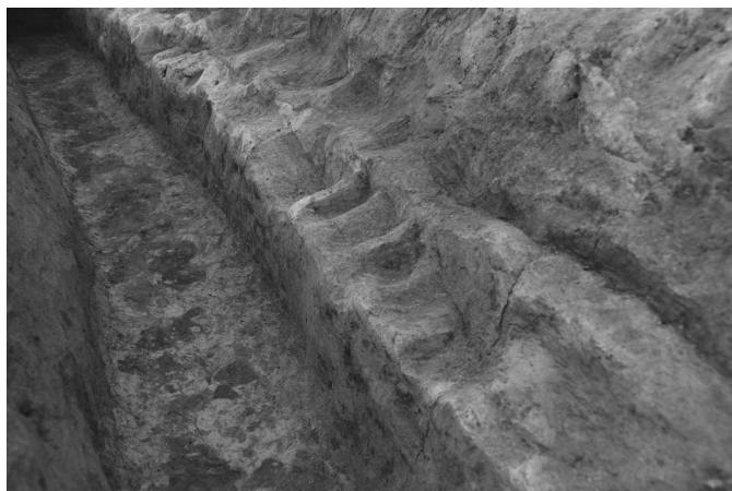
33 A区 SD01 LP-LR間 工具痕検出 (南東から)
