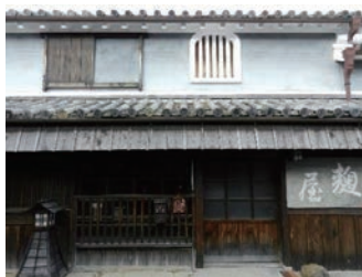
本瓦葺きの屋根と虫籠窓、幕板、手摺状の格子などが特徴的な町家
