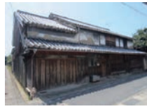
8 戸津井家（戸津井醤油醸造場）
