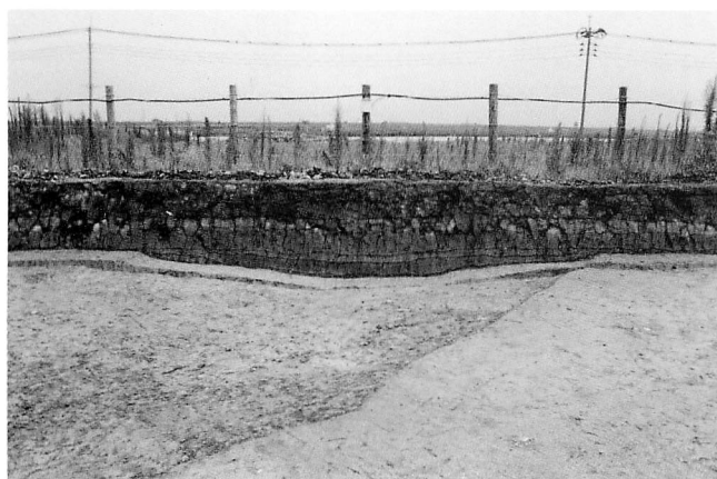
3区 河96 土層断面 (南西→北東)
