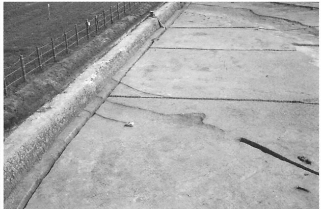
3区 SD138. 133. 134 完掘状況 (北西→南東)
