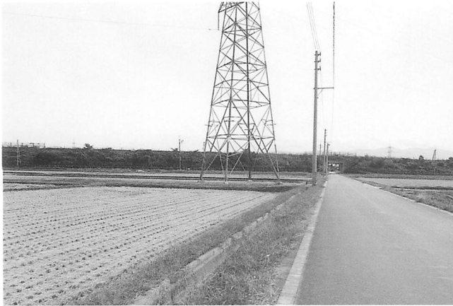
調査前状況 (西→東)
