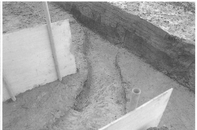
SD1完掘状況（北→南）
