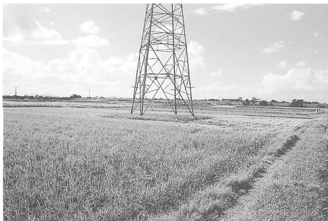
調査前状況 (北→南)
