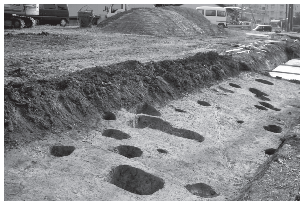
中央擁壁設置箇所(西から)
