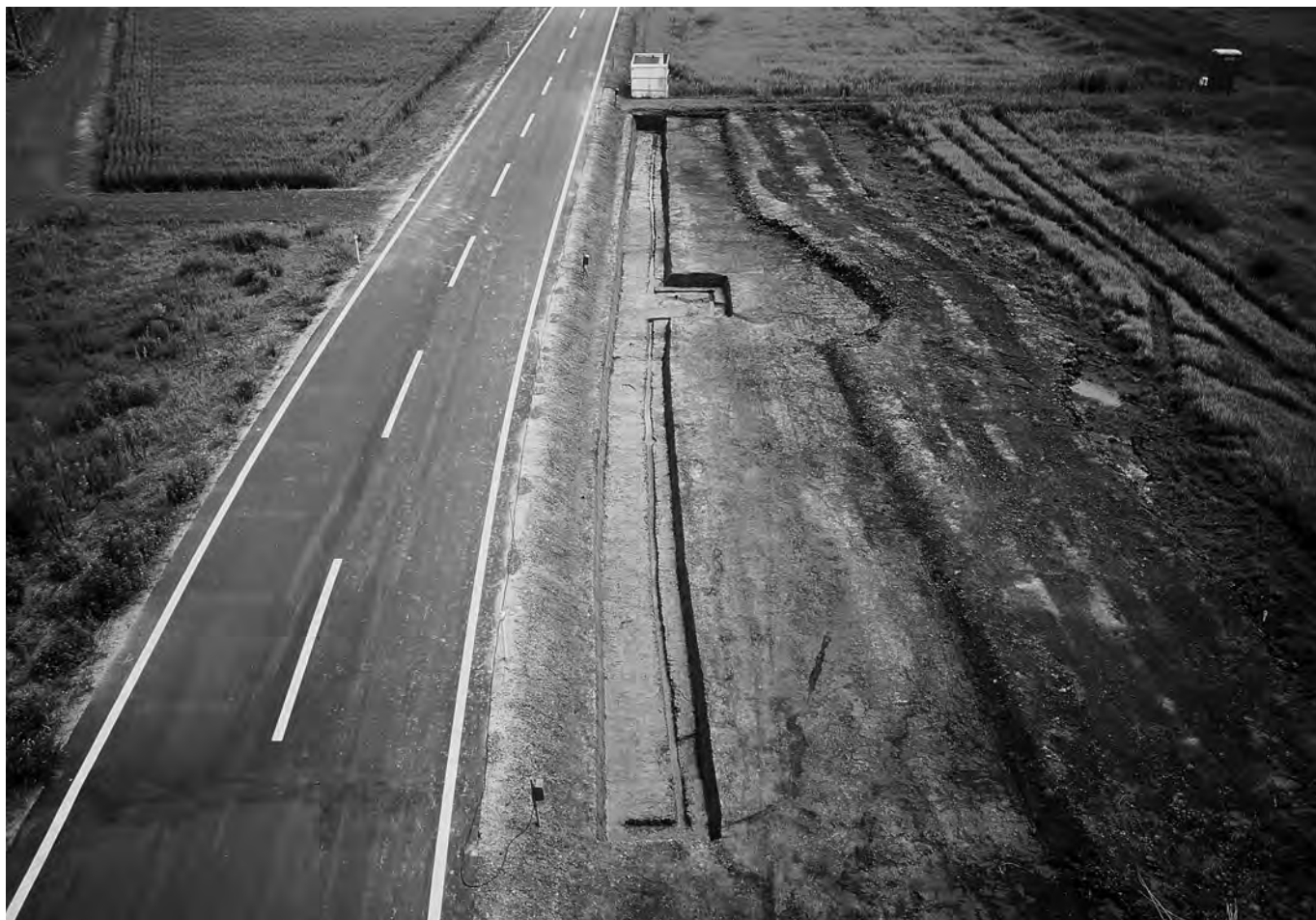
3区 完掘状況（北→南）
