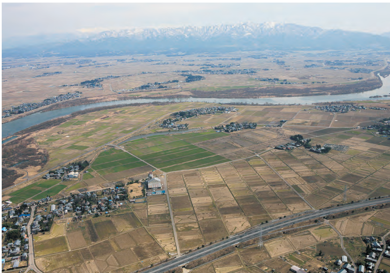
調査前空中写真（西から五頭山を望む） 2008年3月撮影
