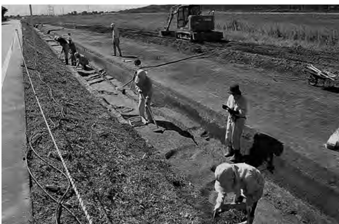
2区 調査風景 (北東→南西)
