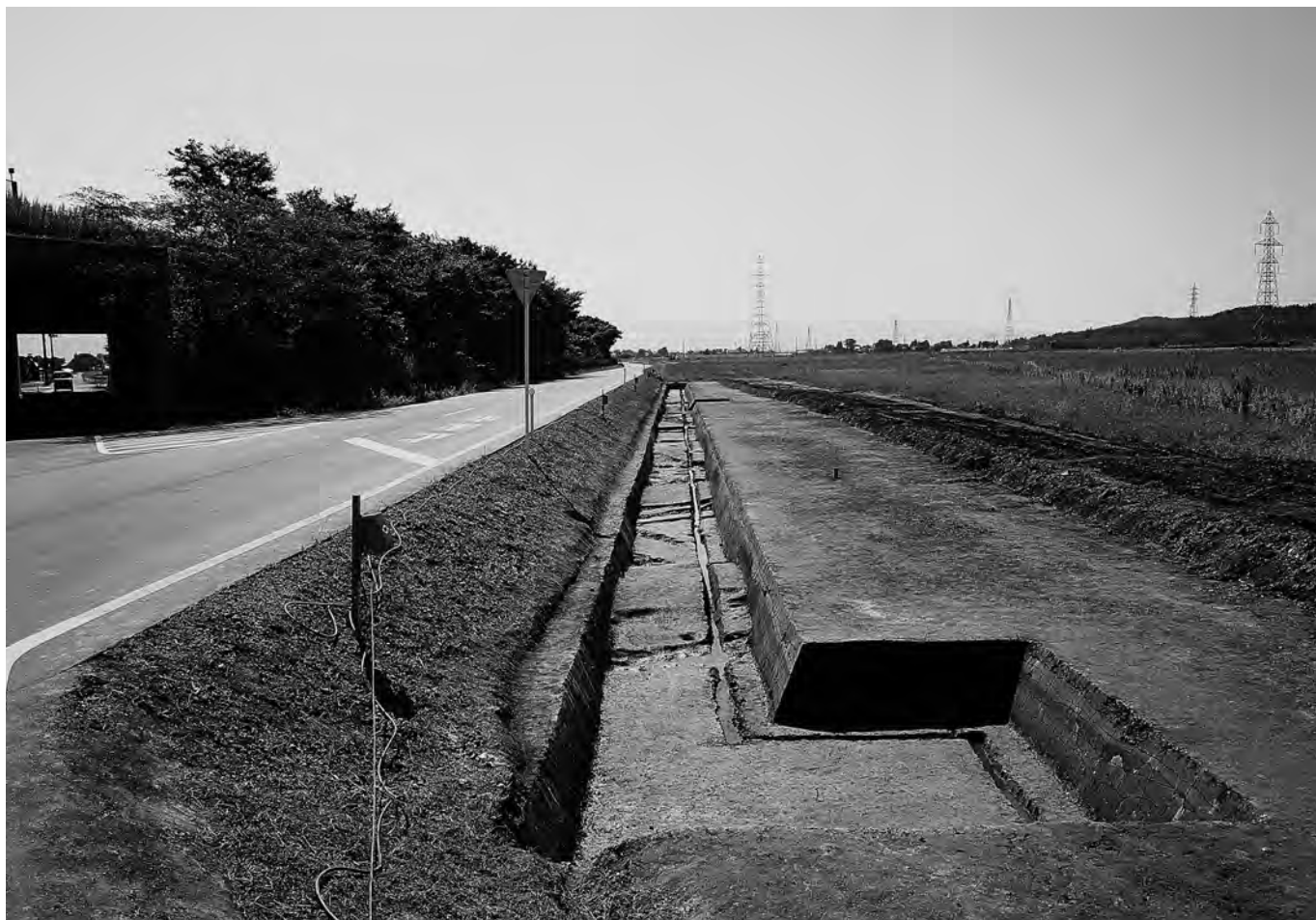
2区 完掘状況（北→南）
