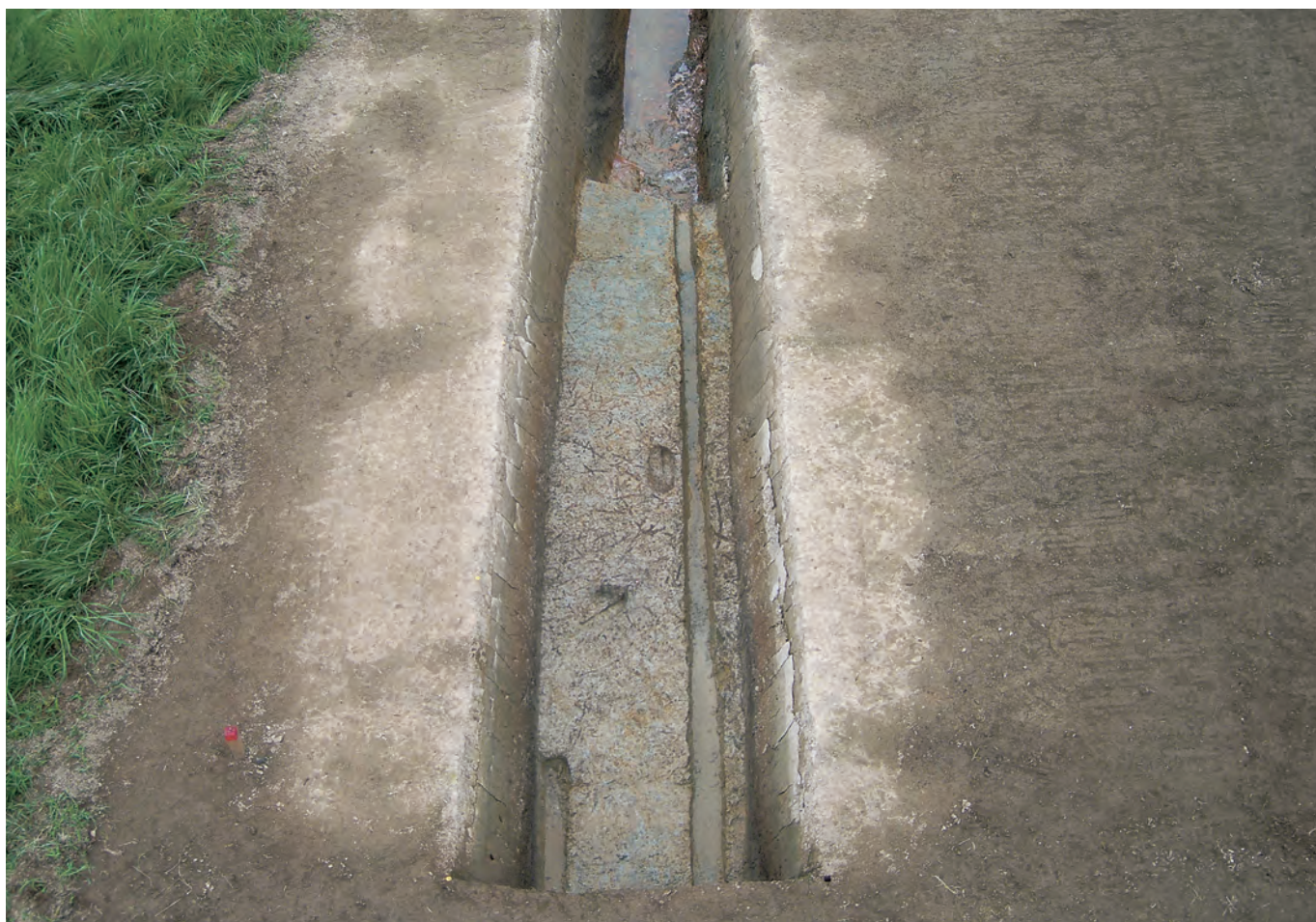
2区 Pit1・Pit2 完掘状況（南→北）
