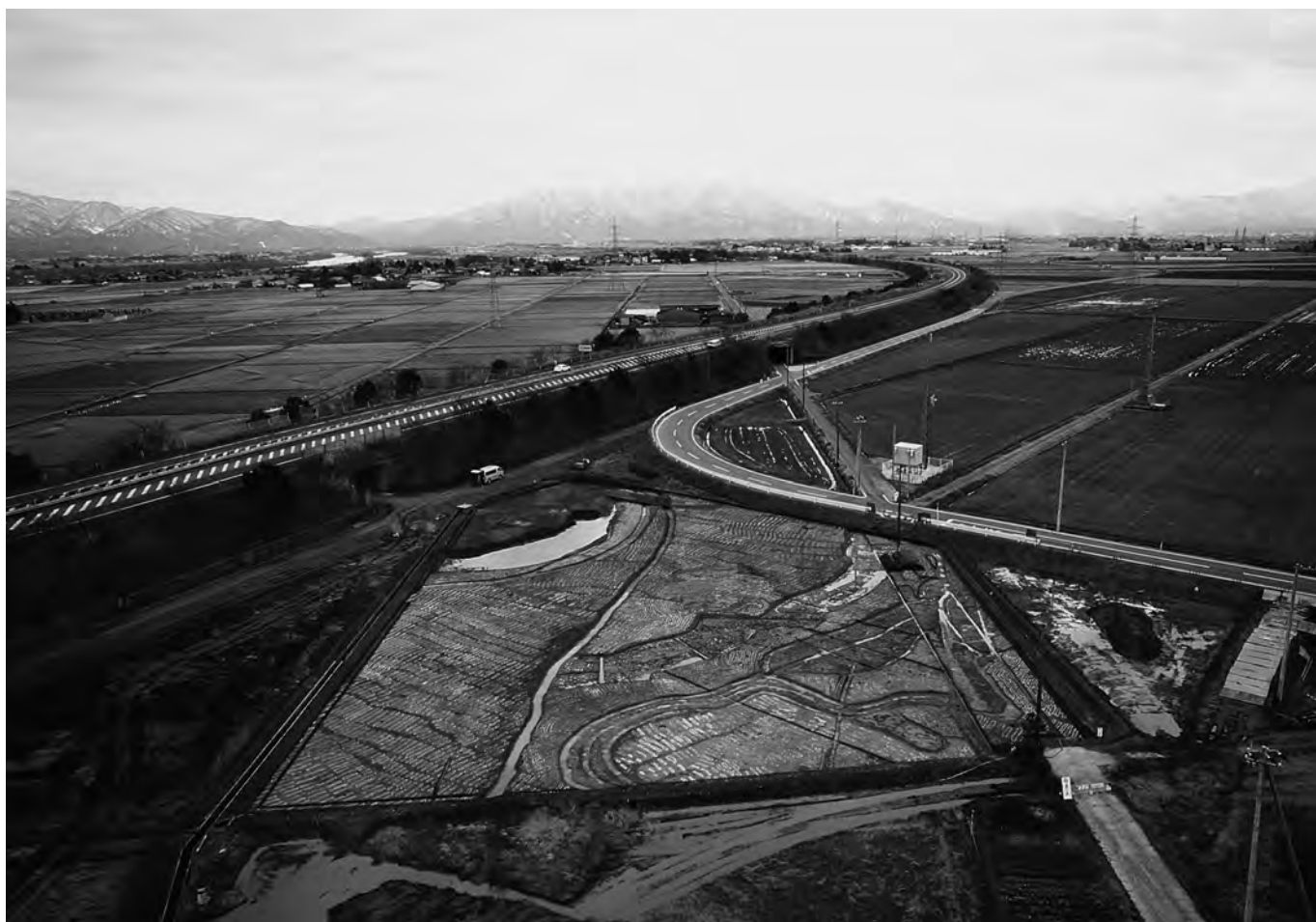
1区 全景空中写真(北西→南東)
