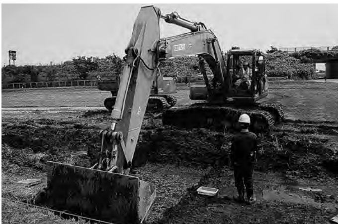
1区 表土掘削 (西→東)
