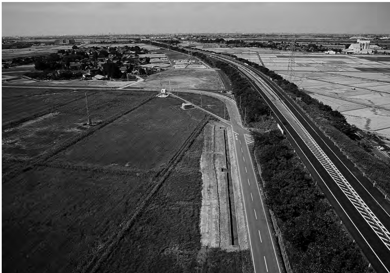
2区 全景空中写真（南→北）
