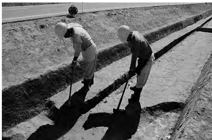
1区 作業風景 (東→西)
