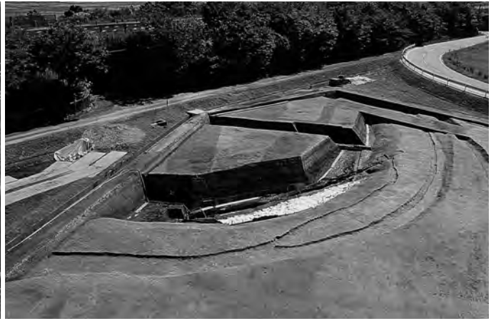
1区 旧河道 1007 全景 (北→南)
