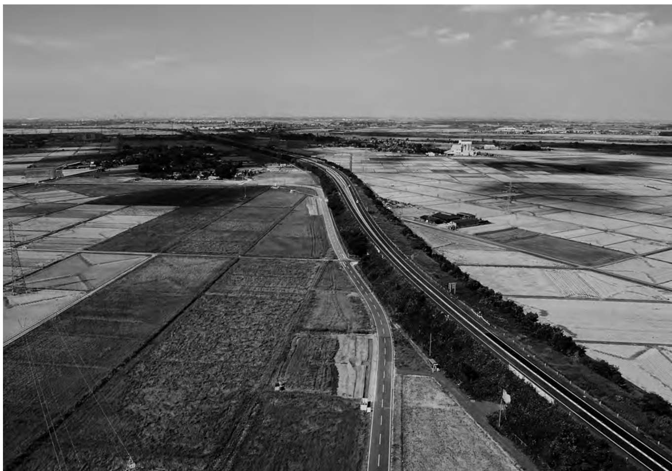
2区・3区 全景空中写真(南→北)
