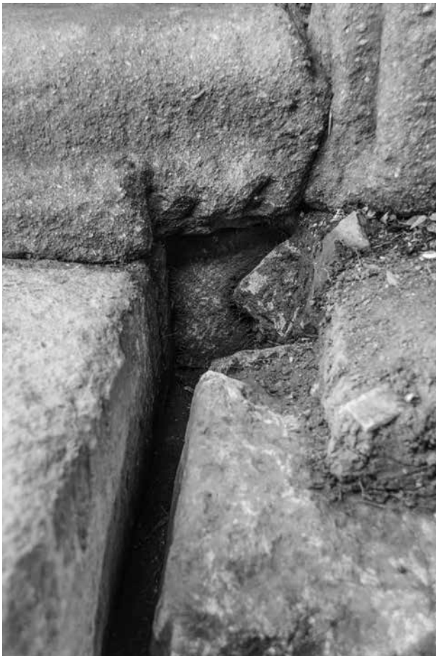
4 トレンチ 山代原古墳前室西側床石と玄室前壁 玄室床石の施工状況（南から）
