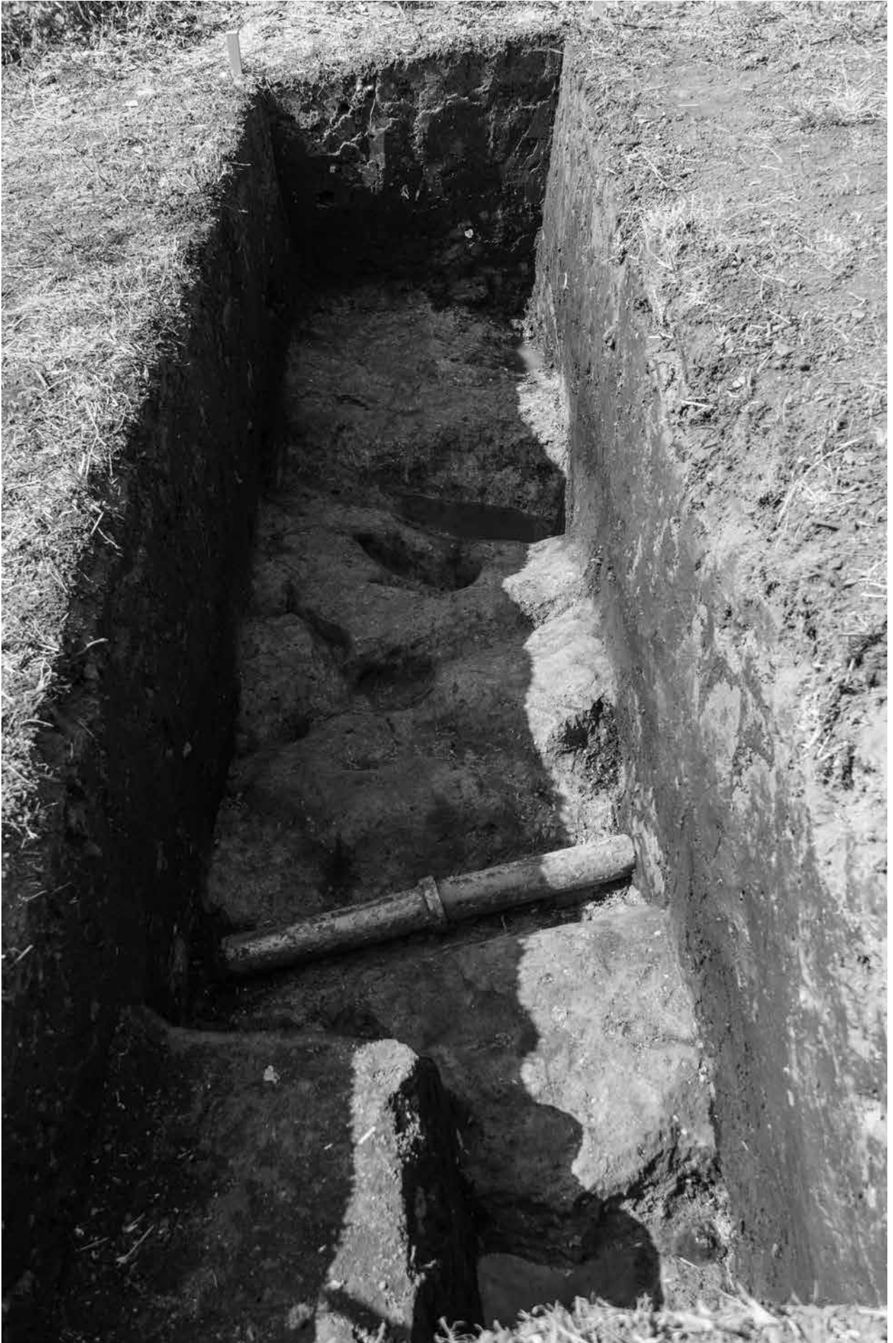
7トレンチ 完掘状況 (南から)
