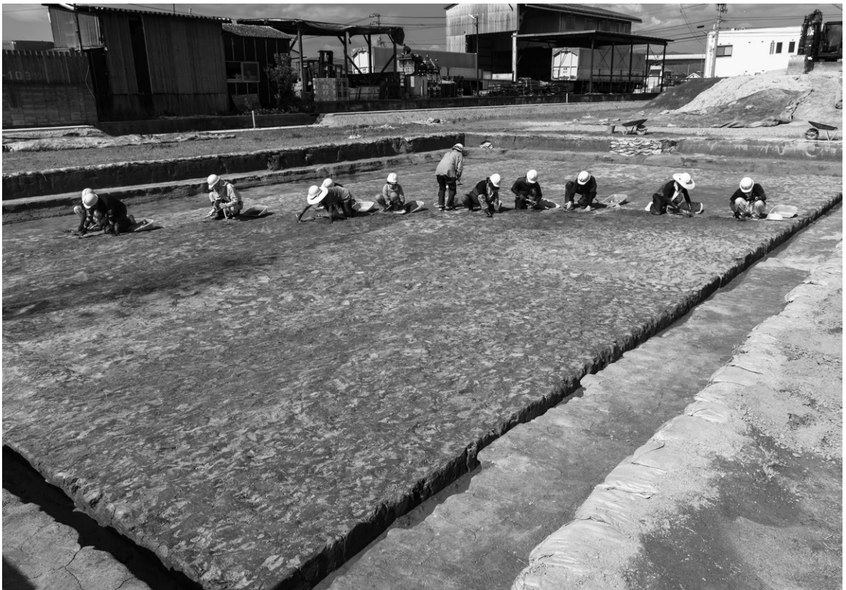
2. 4区作業風景（南西より）
