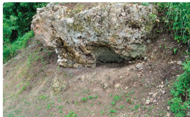
写真106 岩盤凹み (古墓?) 北西から
