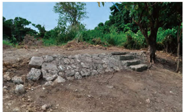
写真 84 石段と石張法面 東から
