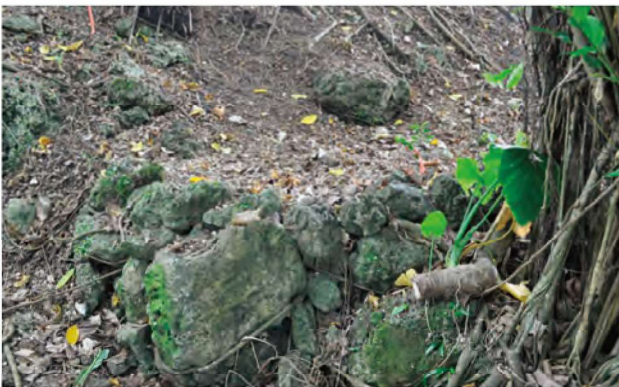
写真 135 石積の状況 北東から
