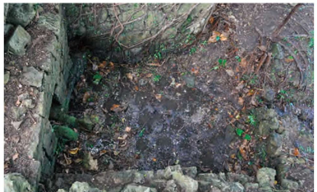
写真124 溜池の状況 東から
