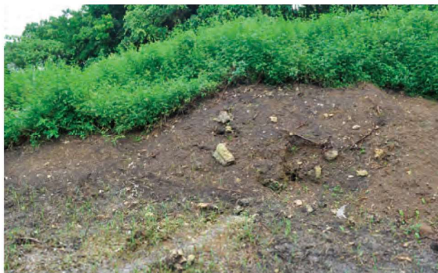
写真 118 湧出口周辺の状況 西から
