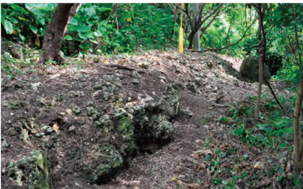
写真 91 土留石積 北東から
