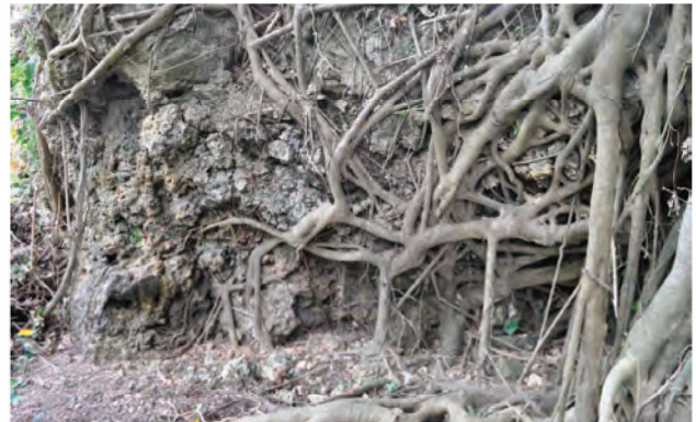
写真152 正面左側の岩壁 北から
