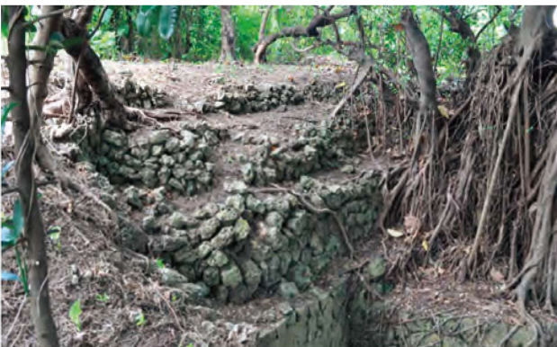
写真123 湧出口上の石積 北東から
