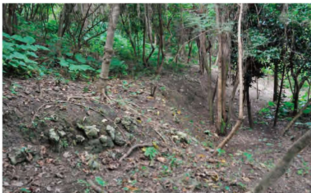
写真 127 土留石積 東から
