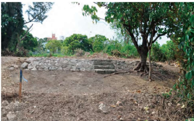
写真 83 石段と石張法面 北から
