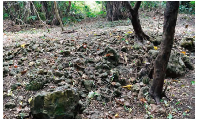
写真 132 同区間の谷側法面 西から
