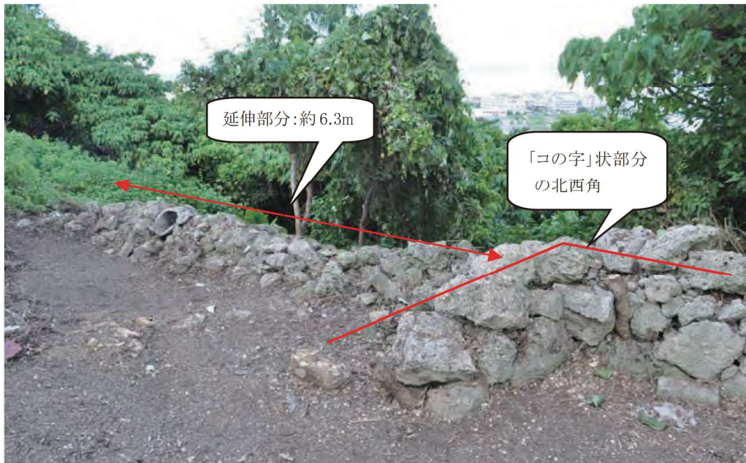
写真 145 石積の「北西角」から西へ続く部分 南東から
