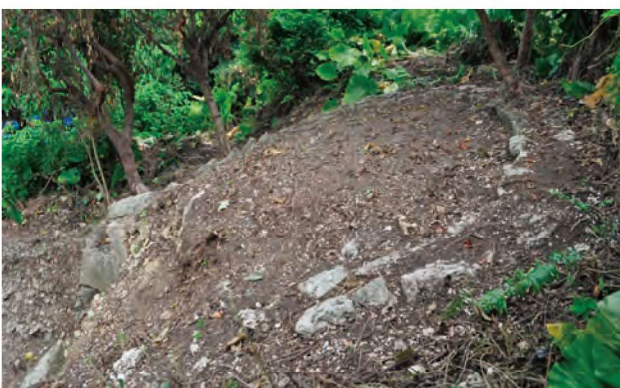
写真113 屋根の状況 西から
