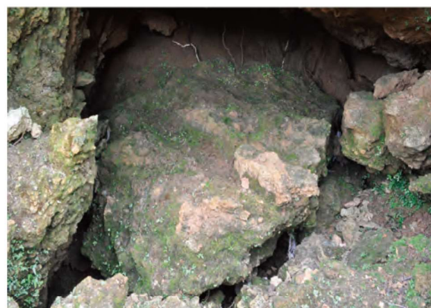
写真8 002. 洞穴(?) 内部の状況
