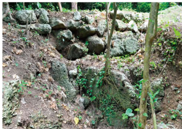
写真16 下流側から見た埋立部
