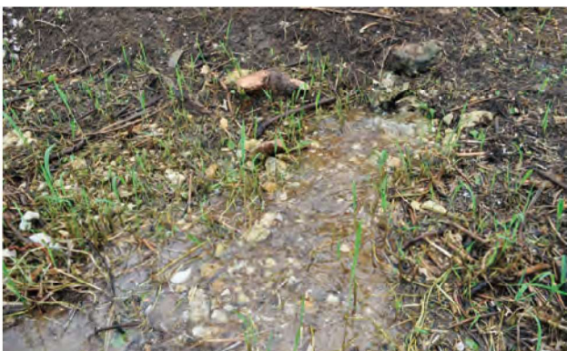
写真 119 湧出口 北西から
