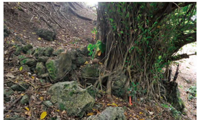
写真 134 石積の状況 北東から
