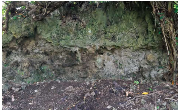
写真 94 古墓 (?) 近景 北から
