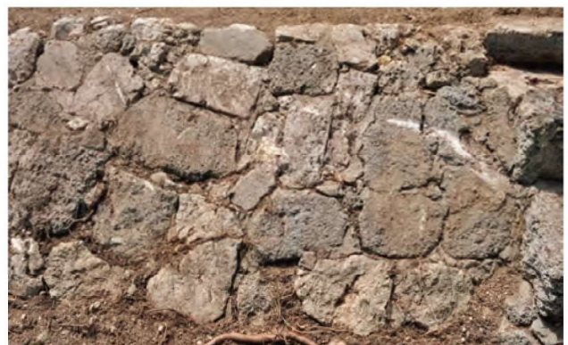
写真 86 石張法面 北から
