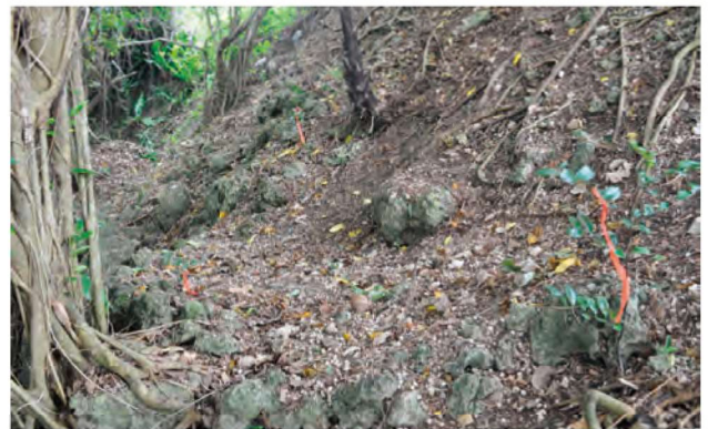
写真 136 石積の状況 西から
