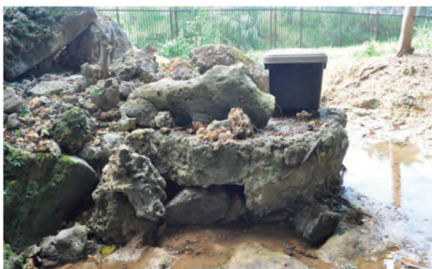
写真 71 鉄筋コンクリートの吸い込み口
