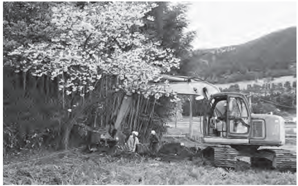
1区の表土掘削
