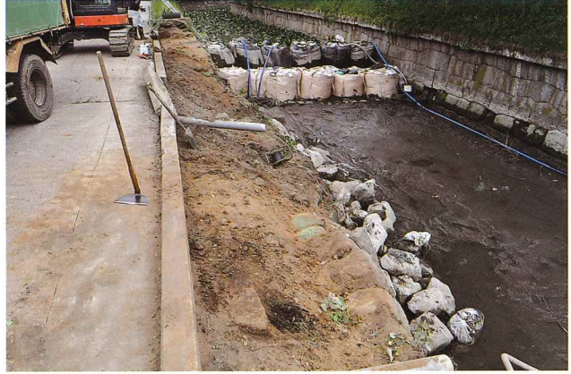
②植生土嚢撤去 (北から)
