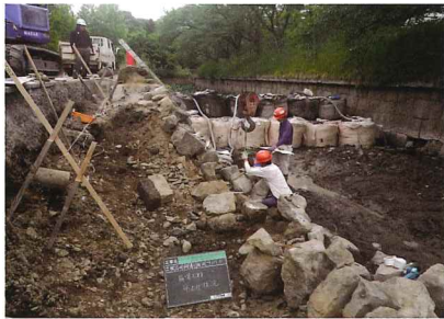
崩壊築石撤去工
