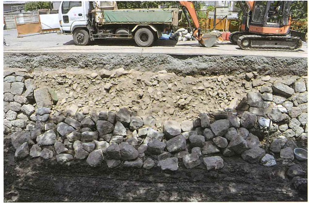
④崩壊土と植生土嚢除去後 (西から)
