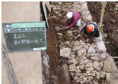
栗石の並べ状況裏込め工
