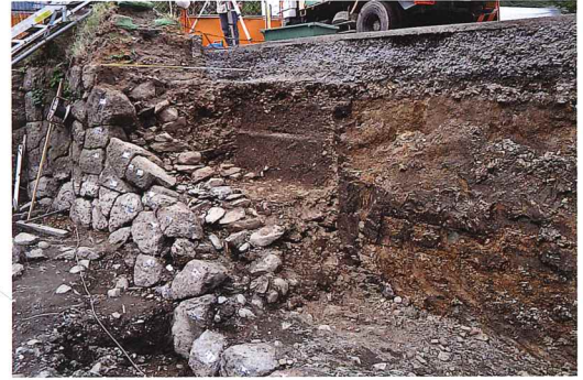
G・H列石垣と裏込 (南西から)
