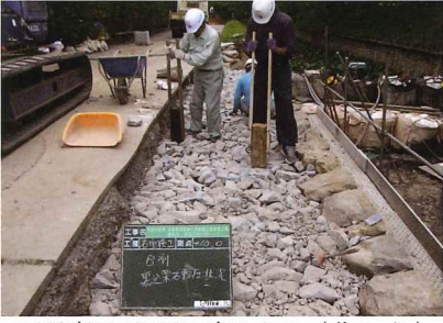
B列裏込め栗石転圧工 (北から)
