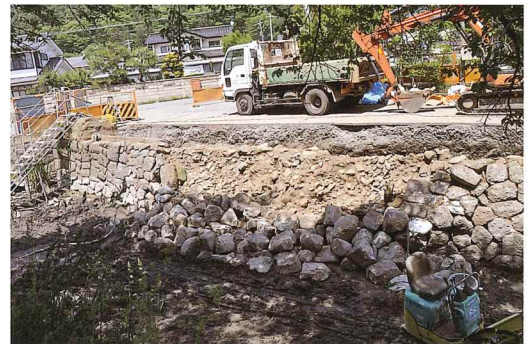
崩壊部裏込め検出（下部に崩壊築石、南西より）
