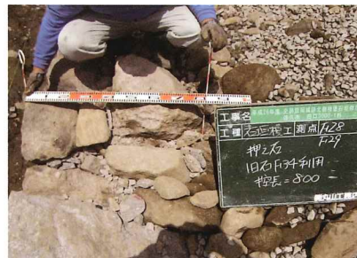
押え石旧F34石利用裏込め工
