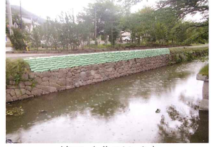
竣工 (北西から)
