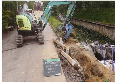
無筋コンクリート撤去工
