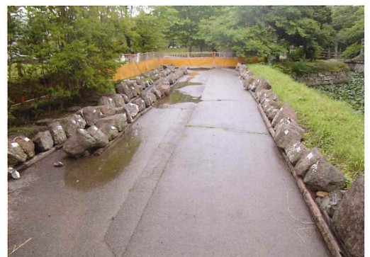
解体築石管理状況
