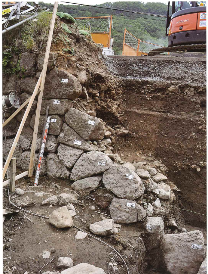
外側1-1-1石垣 今回修理範囲の北端
