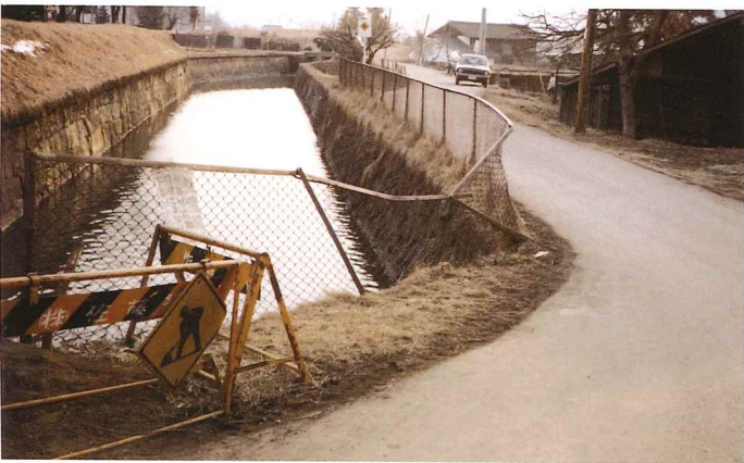
③外側5-3石垣 新フェンス設置前 (東より)
