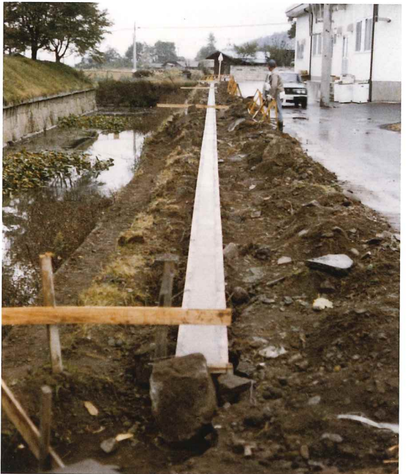
⑥道路縁石コンクリート壁設置 (南より)
