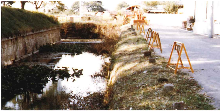
昭和54年度の土嚢設置工事前の外側1-1地点土盛
