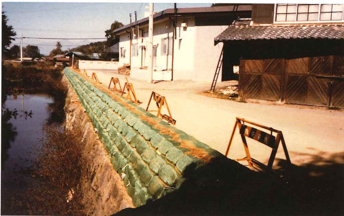
②外側1-1石垣 植生土嚢設置後 (南より)
