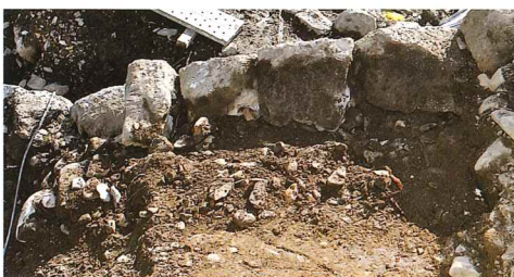
E列石垣 (裏込め除去後 東から)
