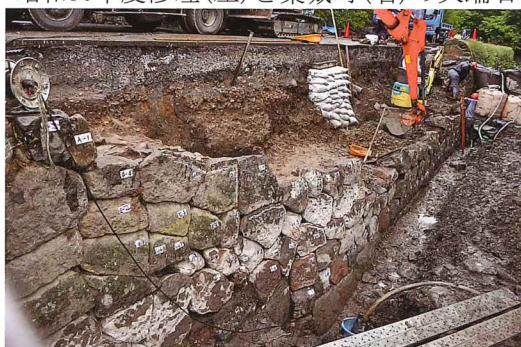
石垣解体作業
