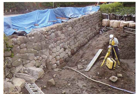
解体修理後石垣の測量
