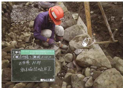
H列木っ端石詰め込み工
