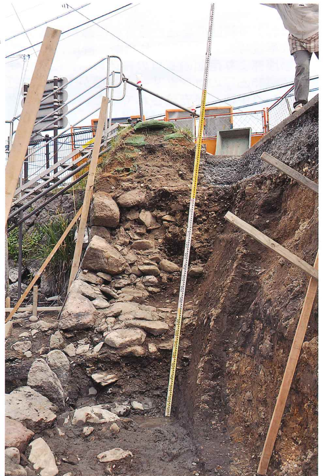
外側 1-1-1 石垣北端 築城時の築石と裏込
