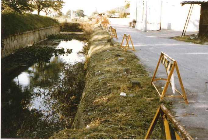
①植生土嚢設置前 (南より)
