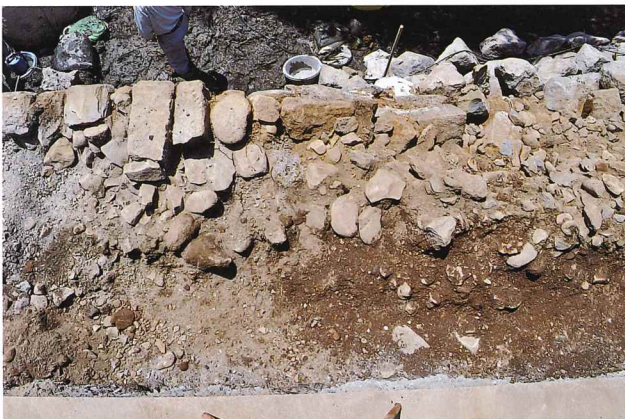
⑤崩壊部から南の石垣天端、裏込めにクラシャーランが入る (東から)
