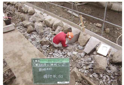
新補材据え付け状況
