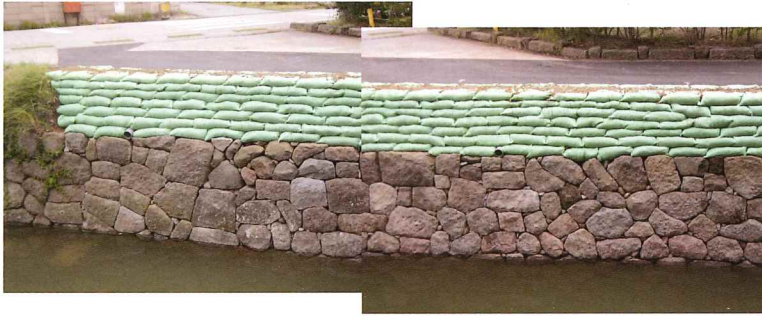
北側竣工 (西から)
