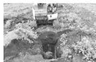
①掘削状況
