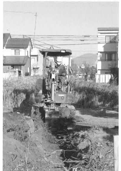
1月調査部分掘削状況
