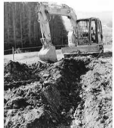
平賀城跡6 掘削状況
