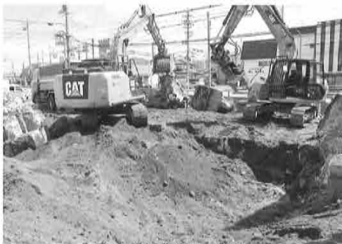
既存建物解体状況
