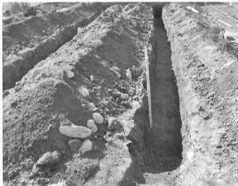
トレンチ掘削状況
