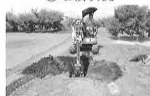
②掘削状況
