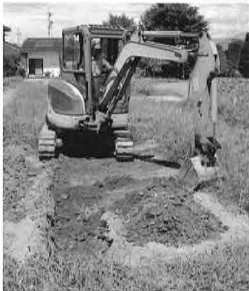
8月調査部分掘削状況
