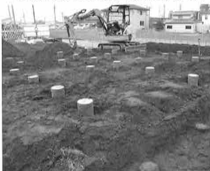
工事立会箇所施工状況
