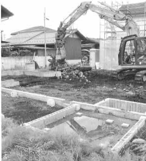
既存建物解体状況
