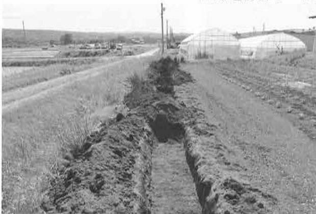
6月調査箇所 掘削状況
