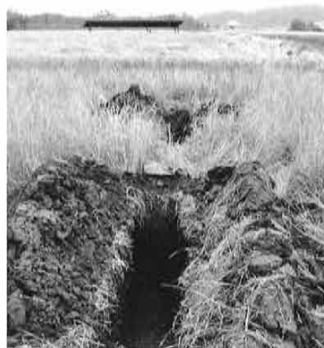
芝添遺跡1 掘削状況
