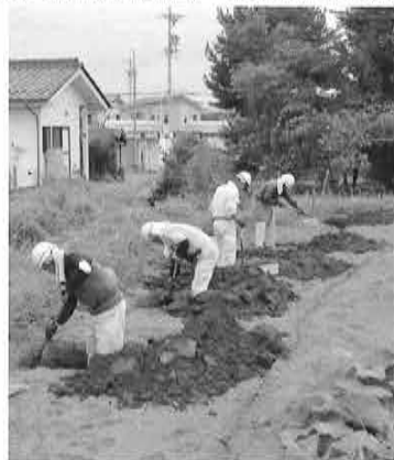
8月調査部分掘削状況
