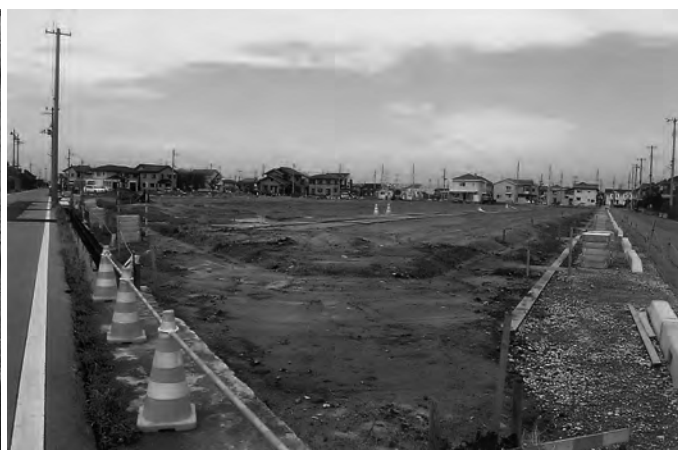
調査着手前状況 (北東から)
