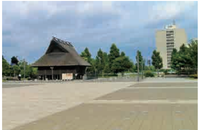
図48 西部ブロック整備状況(西より)
