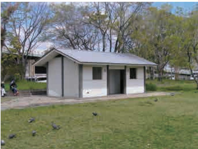
図40 南部ブロックに設置された便所
