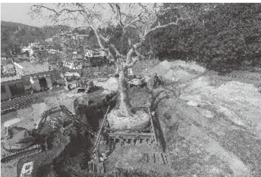
C5 グリッド 地山検出（南東から）
