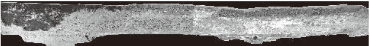
石積み撤去後（南から）
