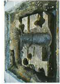
調査3区 南側から
