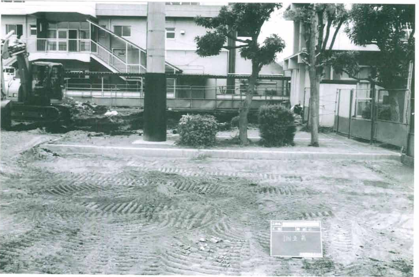
1. 調査区 発掘着手時状況（南から）
