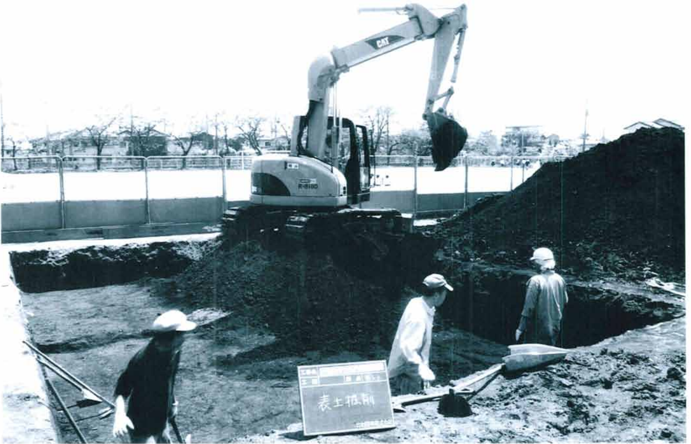
1. 表土掘削作業風景（西から）
