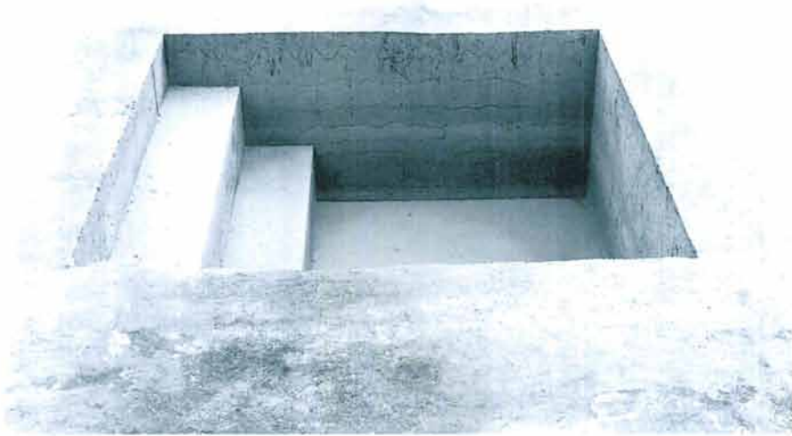
1. 調査坑Y全景（北から）
