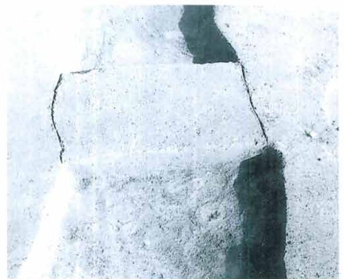
6. SD325溝F-F' 土層断面 (東から)
