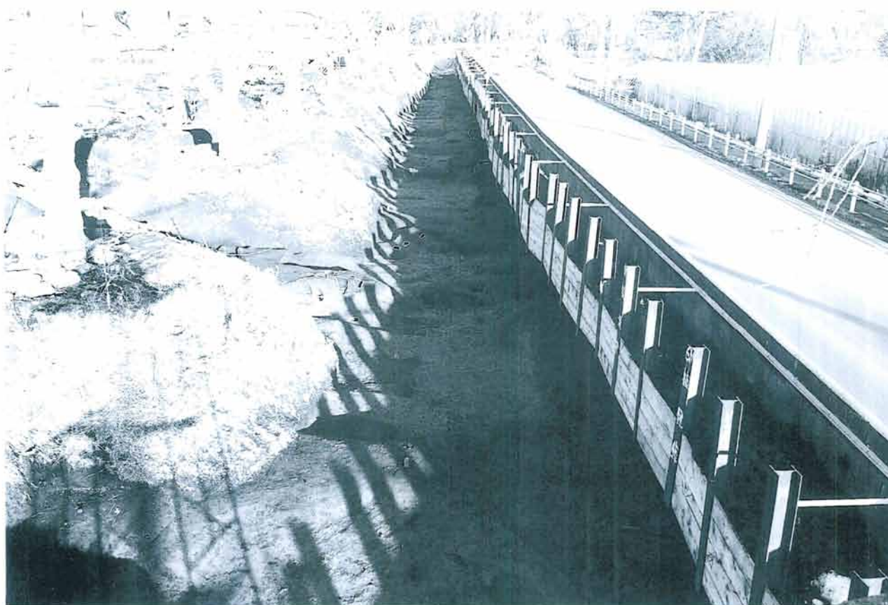
1. 西側調査区全景（西から）
