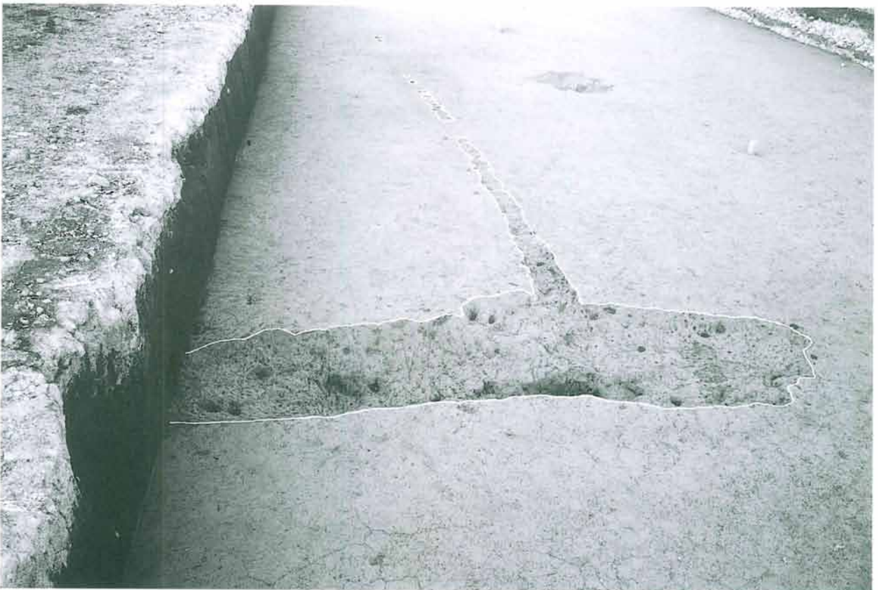
2. SD170・324溝全景 (南から)
