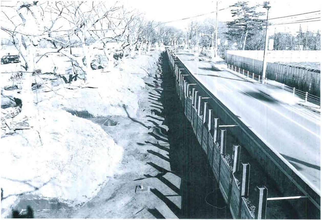
1. 西側調査区全景（西から）
