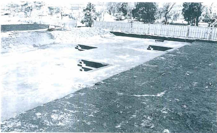
2. 調査坑配置状況（西から）
