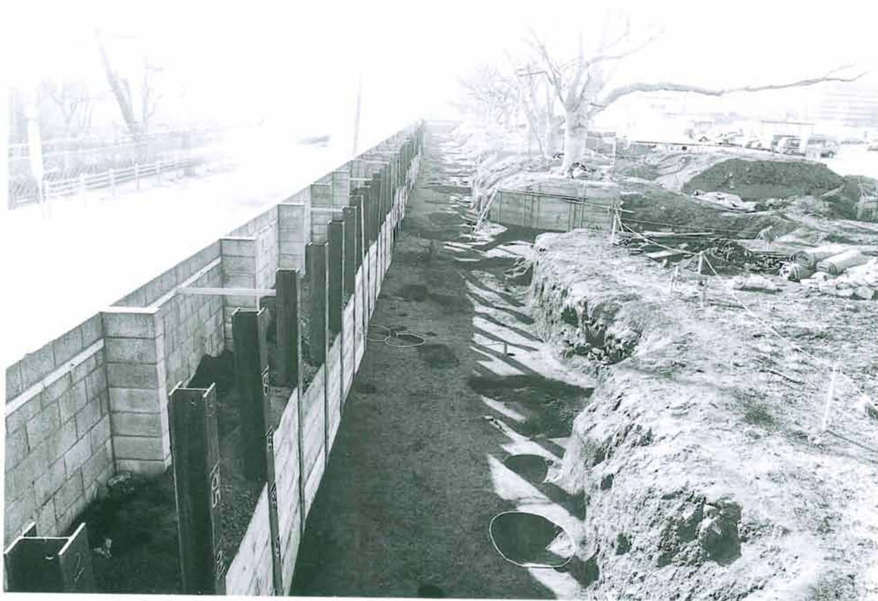
2. 西側調査区全景（東から）
