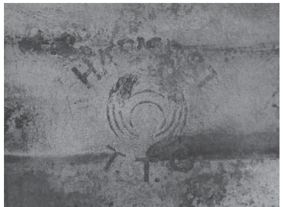
写真 3-53 亜鉛鉄板裏の刻印
