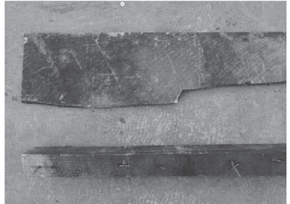
写真 3-33 野地板（上）、垂木に残る釘
