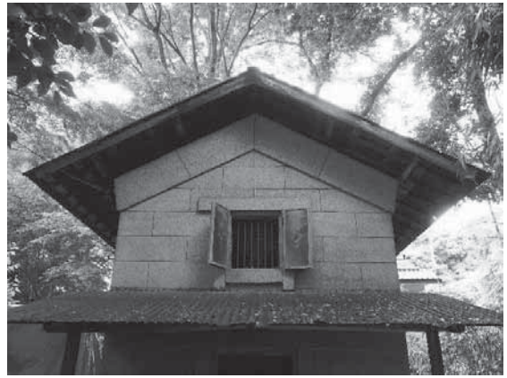
写真4-105 解体前の屋根
