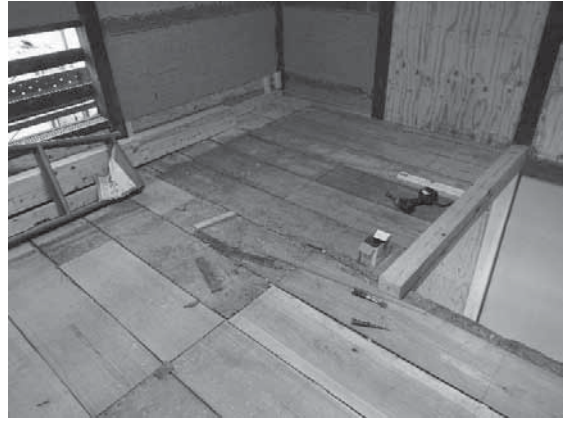
写真 4-48 二階床板の修理
