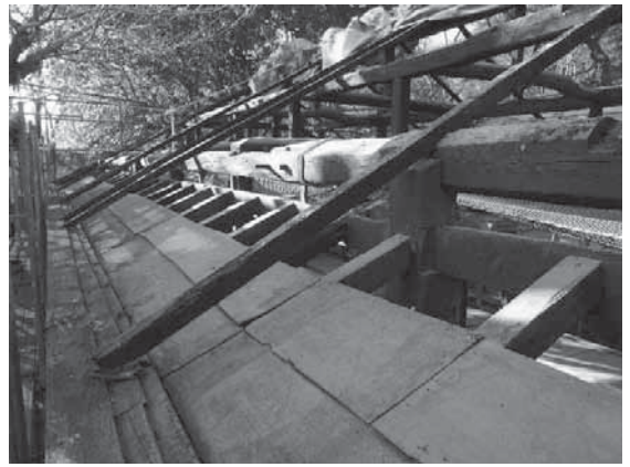
写真 3-50 屋根下地、上屋南面
