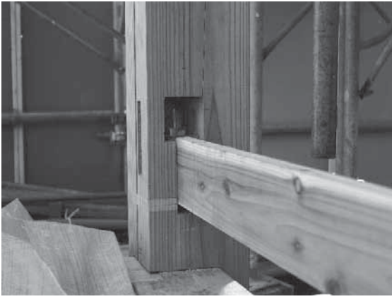
写真 4-74 基礎と柱の緊結
