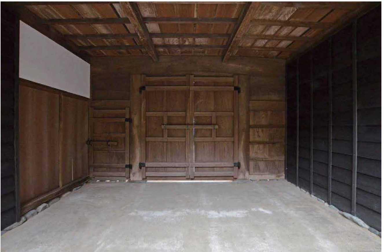
6. 【長屋門】修理後 通路
