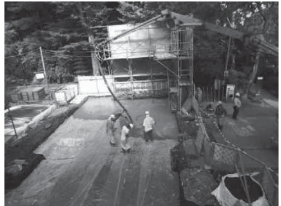
写真 4-32 捨コンクリート打設
