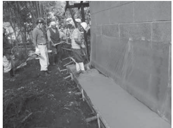
写真 4-113 犬走り、コンクリート打設
