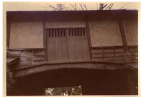
写真 5-8 長屋門 北面通路上
