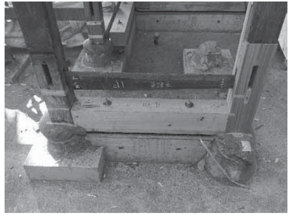
写真 4-75 基礎と土台の緊結
