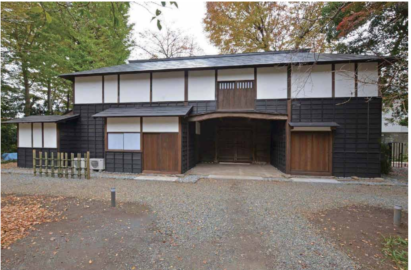
4 【長屋門】修理後 北面
