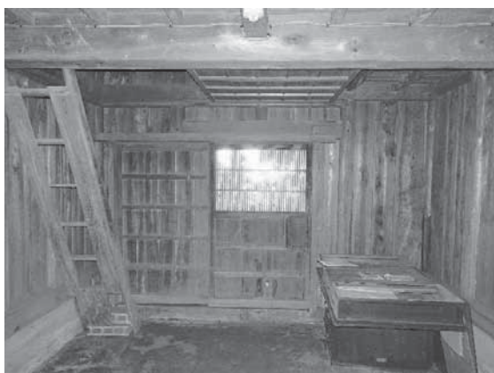
写真 3-68 一階出入口扉
