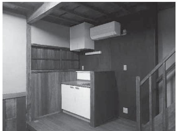
写真 4-101 給排水設備、一階管理スペースの流し台
