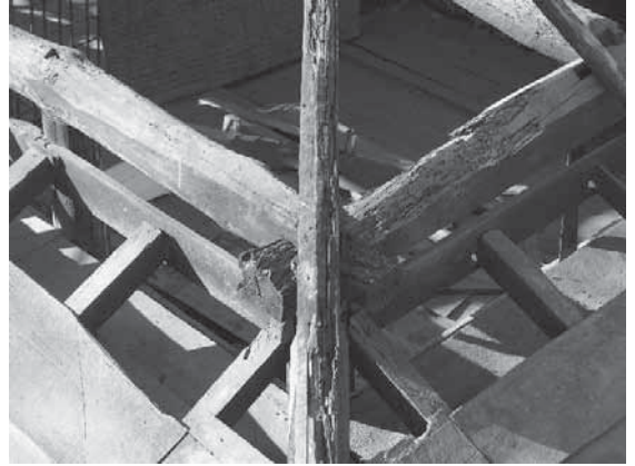
写真3-6 小屋組：隅木、軒桁（へー十五通）
