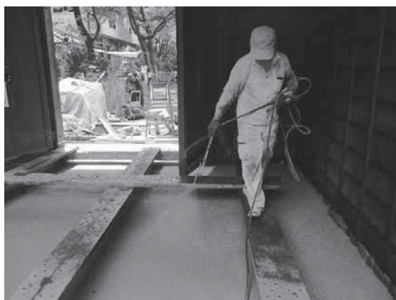
写真 4-87 土系舗装、散水
