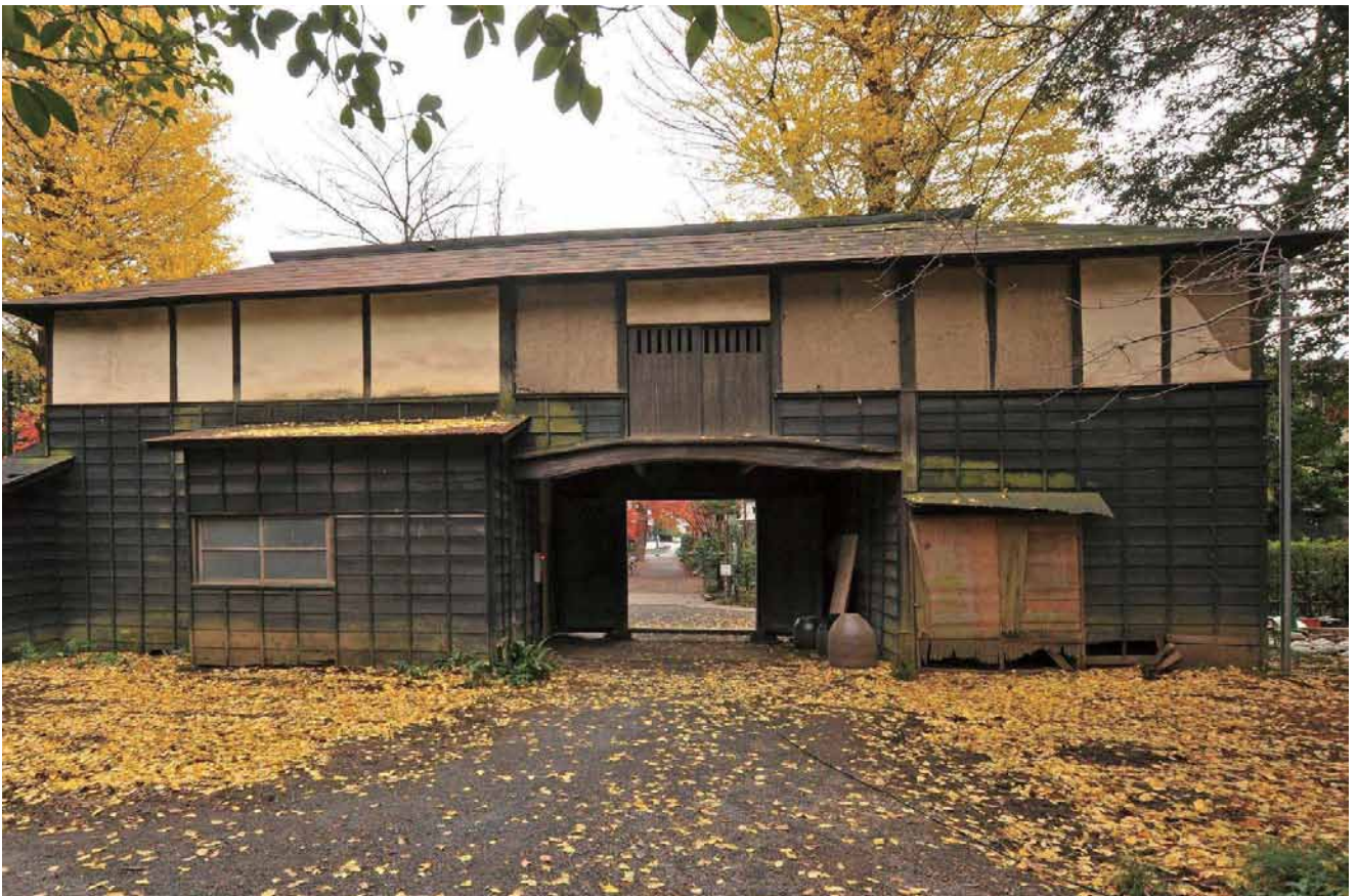
16. 【長屋門】修理前 北面
