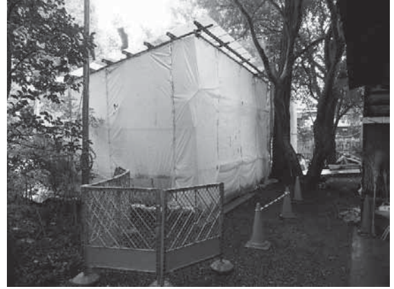
写真 4-8 保存小屋兼作業小屋（増設）
