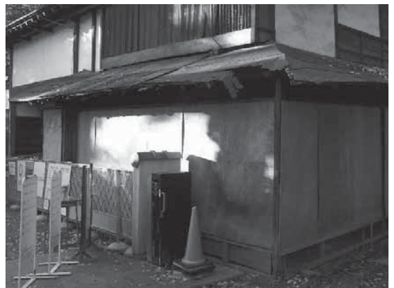
写真3-8 屋根：金属板、下地（下屋屋根）
