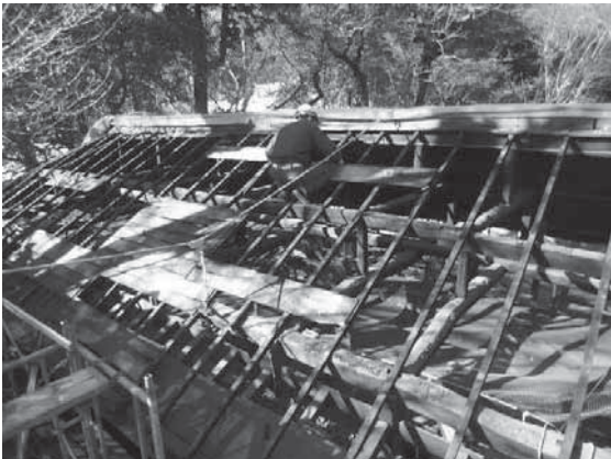
写真4-15 野地板撤去
