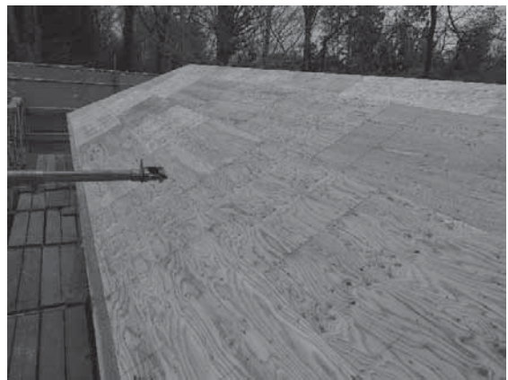
写真4-53 構造用合板下張（上屋）
