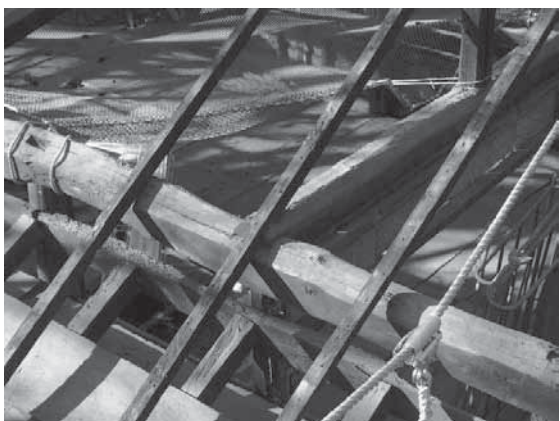
写真3-19 当初材の軒桁、小屋梁
