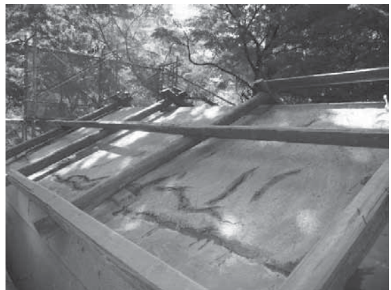
写真4-107 置き屋根、下地解体
