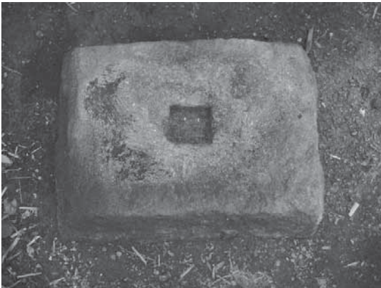
写真3-40 鏡柱の礎石（切石安山岩）
