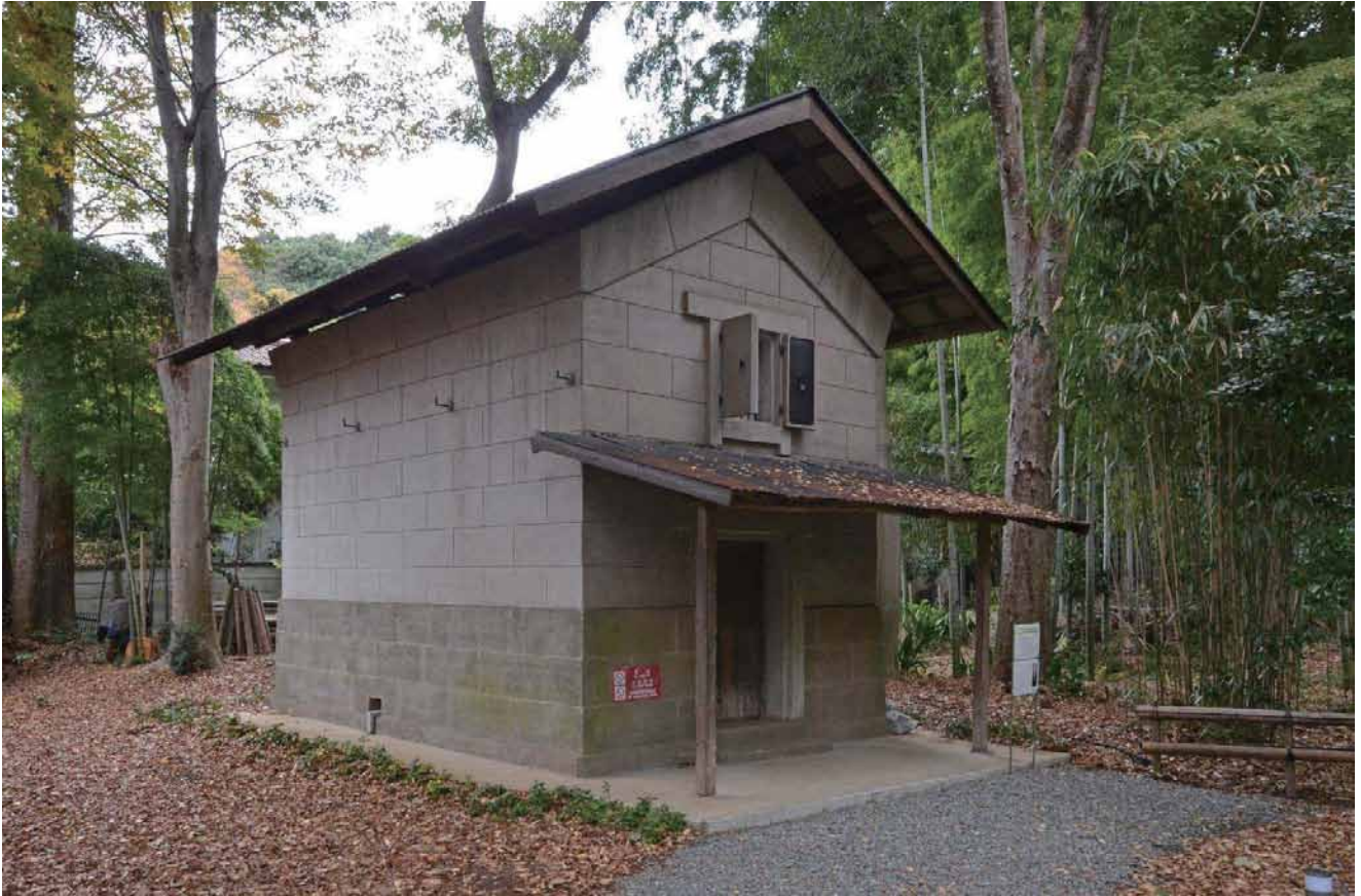
25. 【 倉 】 修理後 外観
