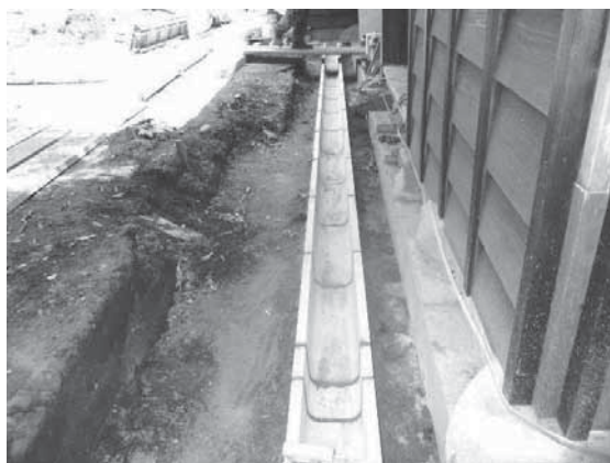
写真 4-88 雨落ち、U字溝
