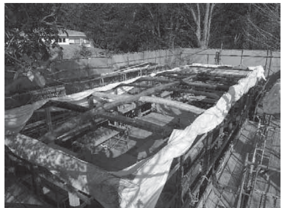
写真 4-44 軸部の組立完了
