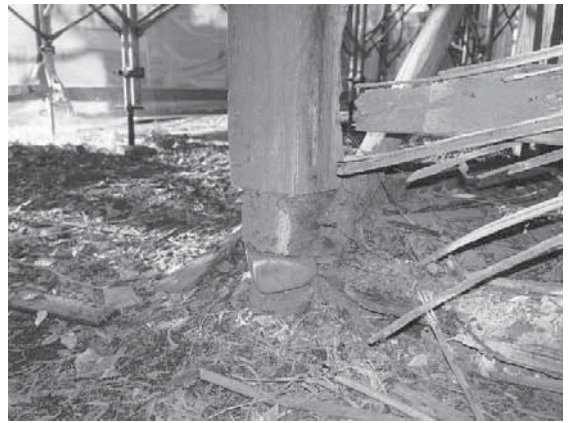
写真3-2 軸部：土台、柱脚（へー一通り）
