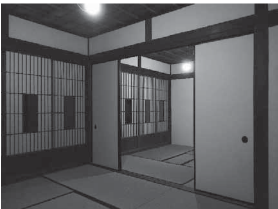
写真 4-72 襖、障子の吊り込み (一階座敷)
