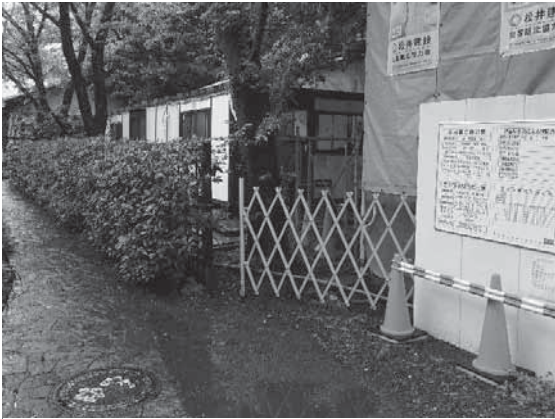
写真 4-5 工事用出入口（長屋門正面西）
