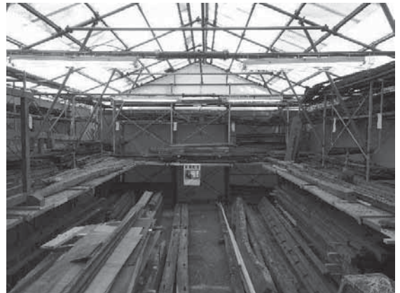
写真 4-28 解体部材格納（保存小屋）
