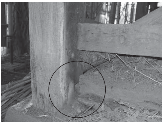
写真3-45 柱と土台の仕口、柄差し（へー八通り）
