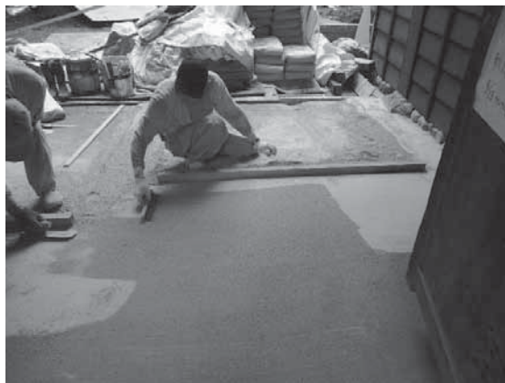
写真 4-86 土系舗装、敷均し・表面調整
