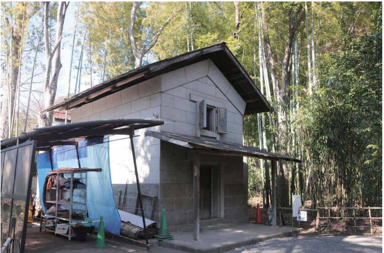
26. 【 倉 】 修理前 外観
