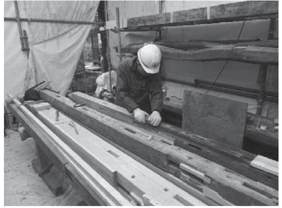
写真 4-38 継ぎ作業
