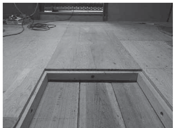
写真 4-81 二階床補強（下地+構造用合板 t24）
