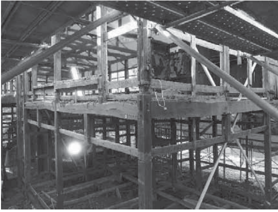
写真 4-21 板壁、造作材撤去
