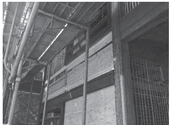
写真 4-79 補強壁（土壁を置換）、構造用合板張り
