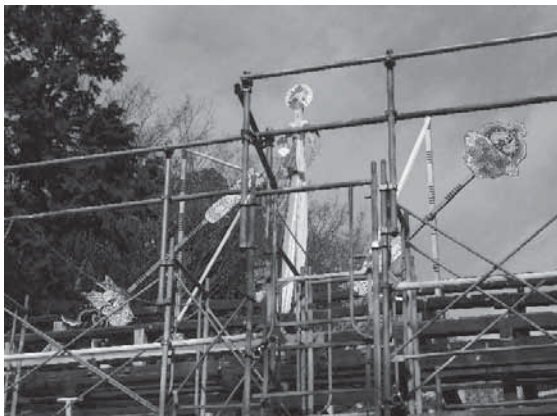
写真 4-121 棟木の飾り(幣串、破魔矢)
