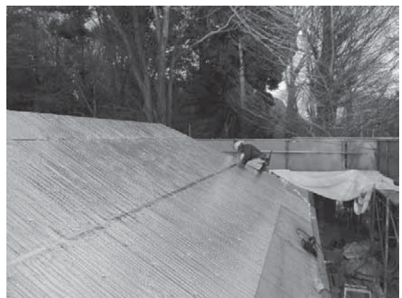
写真4-54 遮熱材 t8 張り
