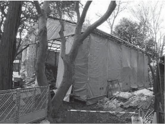
写真 4-7 保存小屋兼作業小屋
