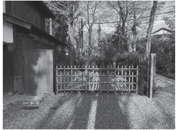
写真 4-93 管理用通用口、門扉・板塀
