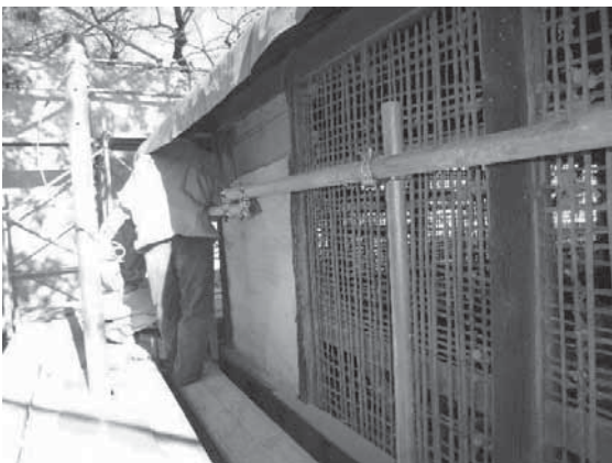
写真4-17 壁土撤去
