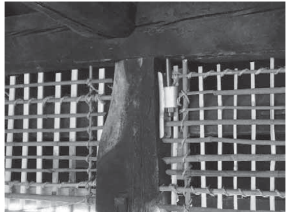
写真 4-77 柱と軒桁の緊結
