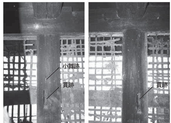
写真 3-31 二階物置、間仕切り跡
