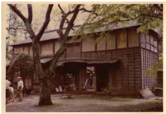
写真 5-7 長屋門 北面全景
