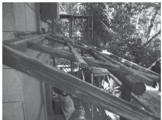
写真4-108 下屋屋根、波板撤去後
