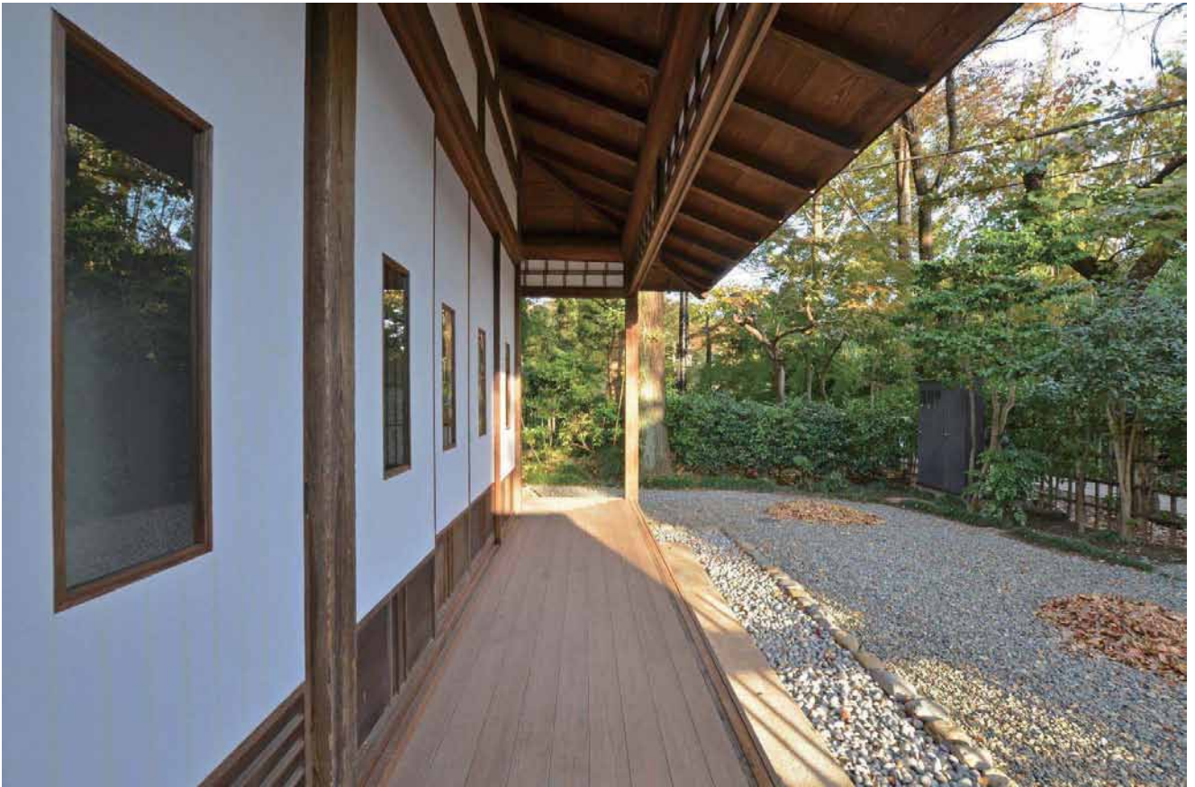
9. 【長屋門】修理後 縁側
