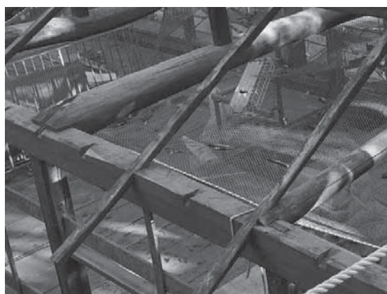
写真3-20 後補材の軒桁、小屋梁
