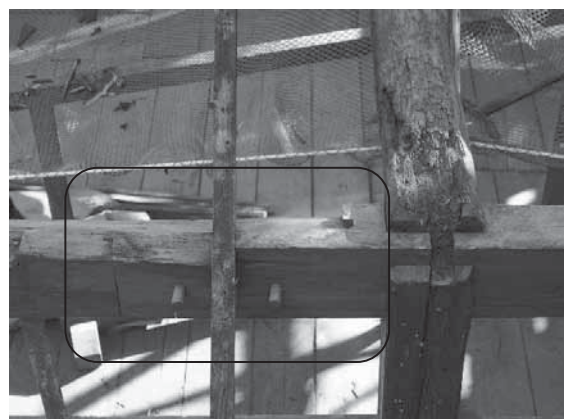
写真3-49 軒桁の継手「腰かけかま継ぎ」
