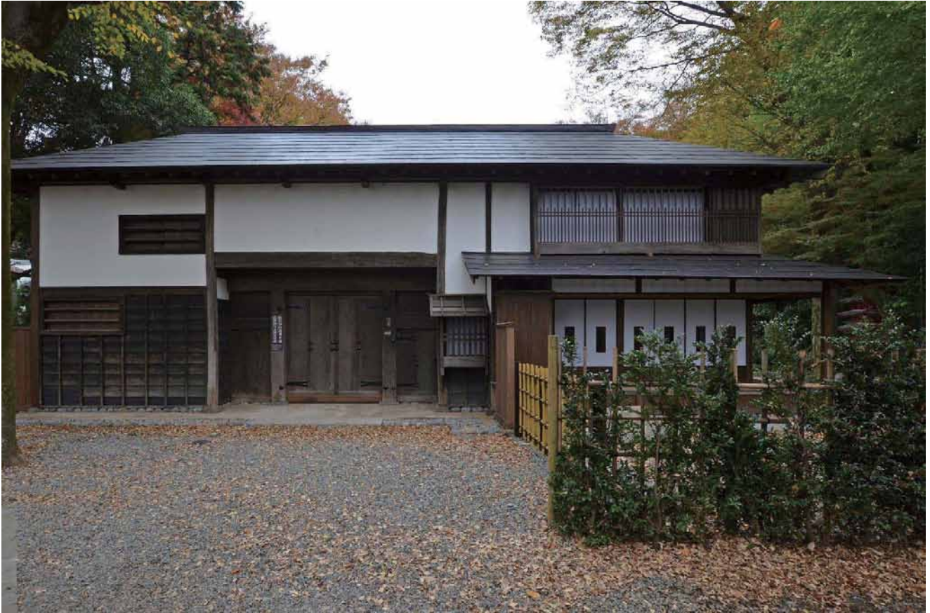
1. 【長屋門】修理後 南面
