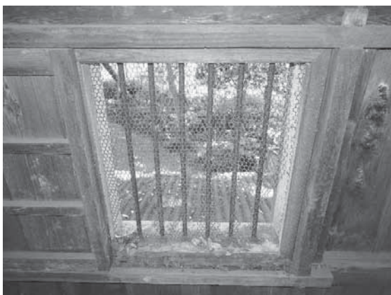
写真 3-66 正面二階の窓（内側）
