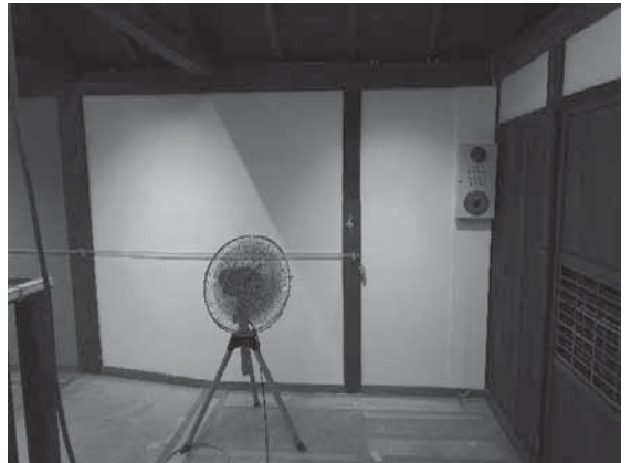
写真 4-65 漆喰仕上げ(乾燥)
