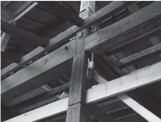
写真 4-76 階層間の柱補強
