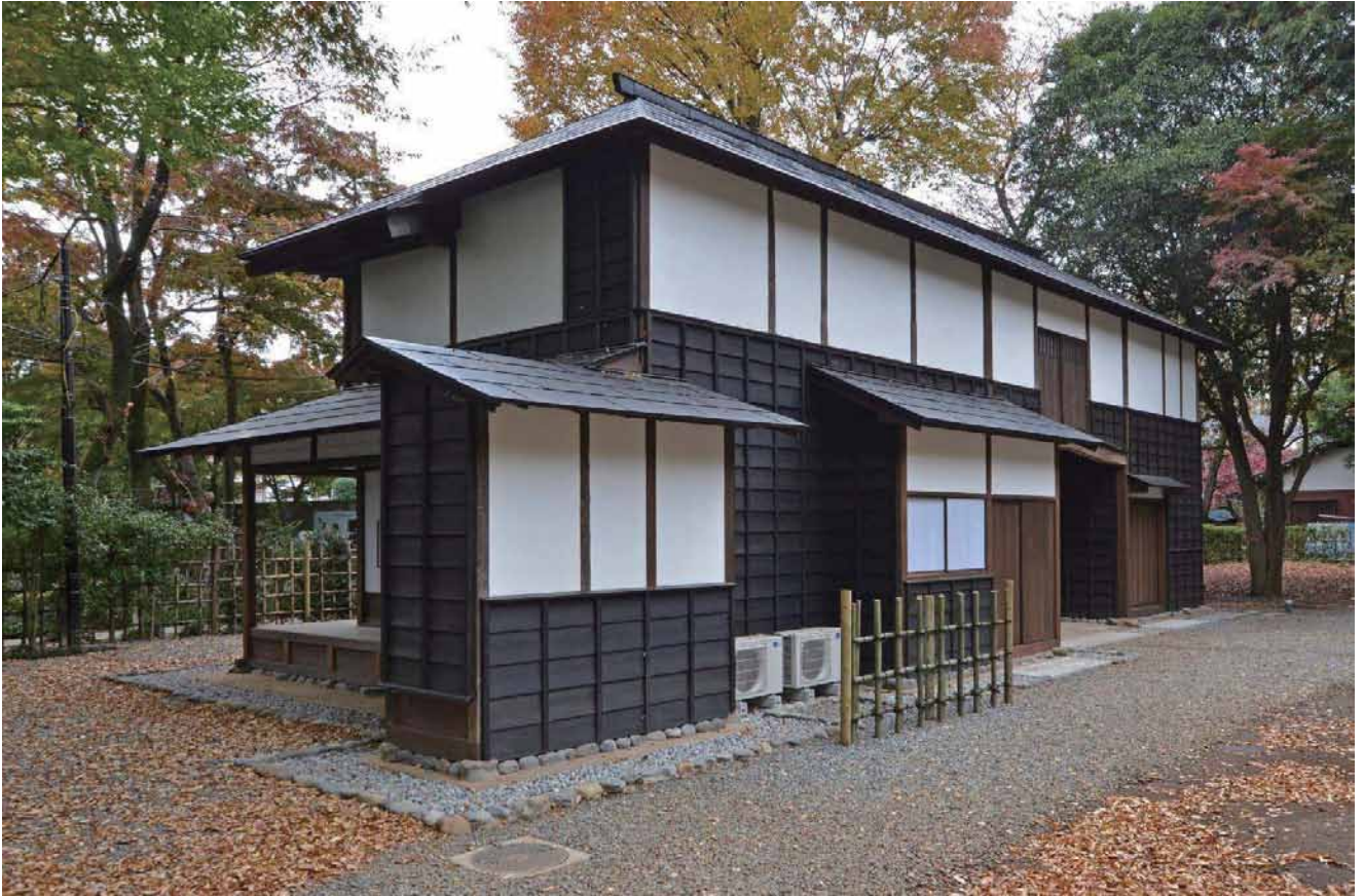
3. 【長屋門】修理後 北東面
