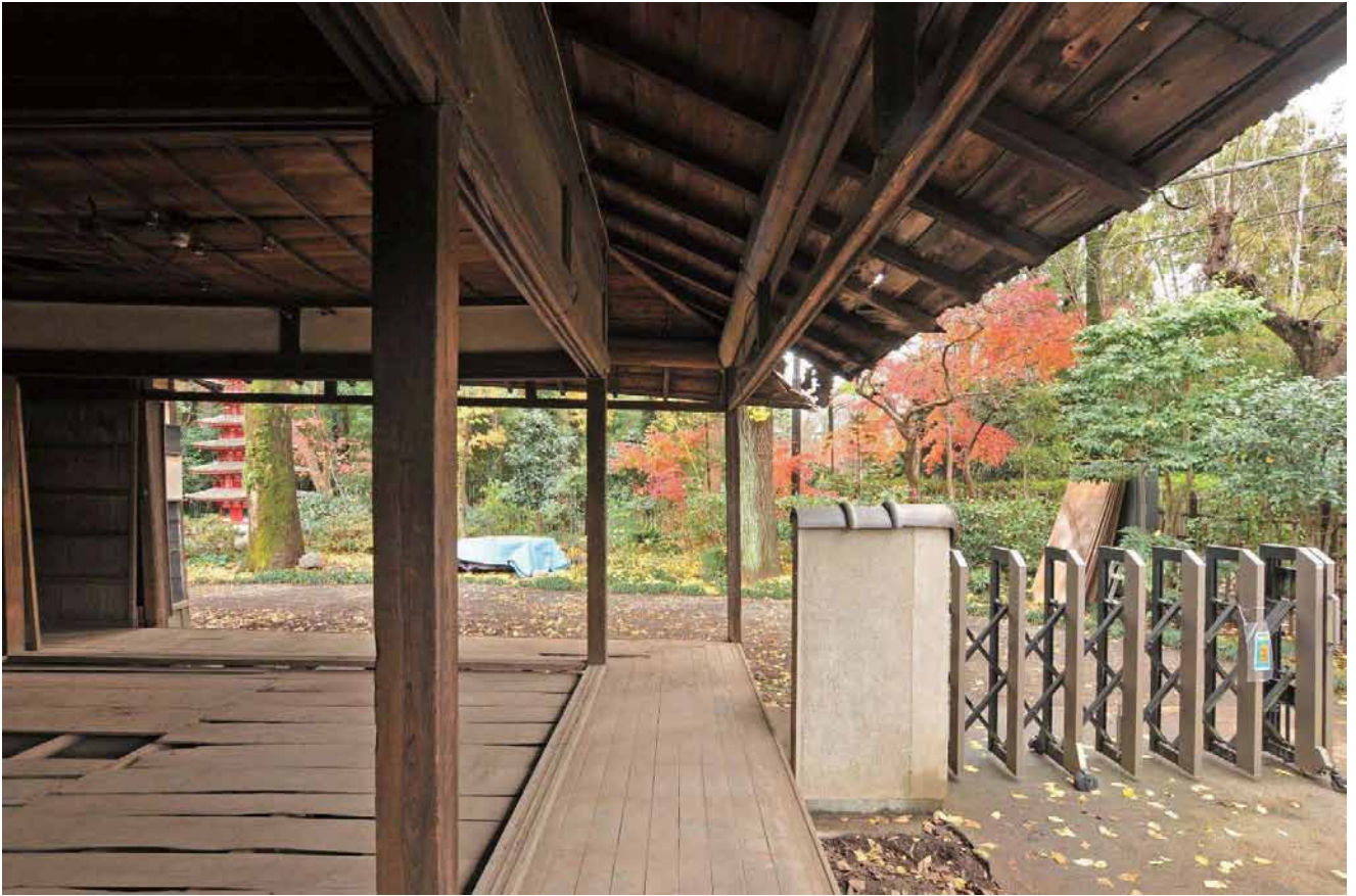
21. 【長屋門】修理前 縁側
