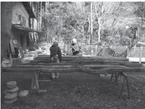
写真 4-27 解体部材の整理
