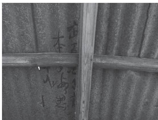
写真 3-69 下屋屋根裏の墨書
