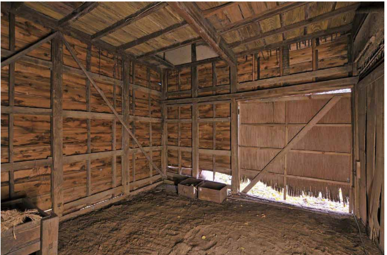
22. 【長屋門】修理前 一階土間物置
