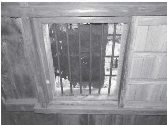
写真 3-67 背面二階の窓（内側）
