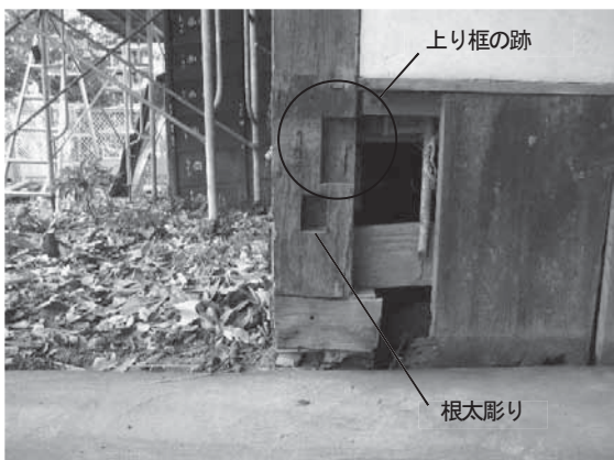
写真 3-26 「いー十二通り」柱の西面
