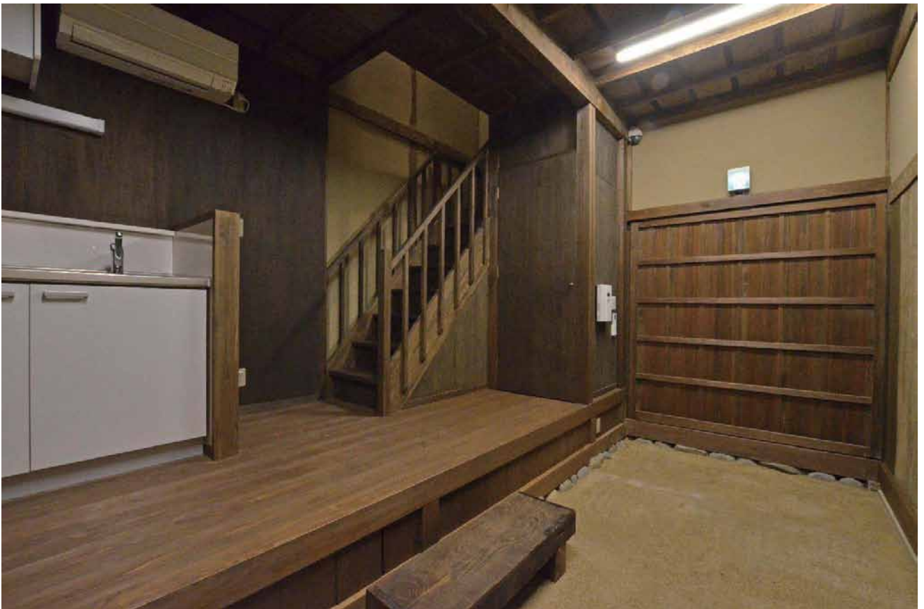
10. 【長屋門】修理後 一階管理スペース
