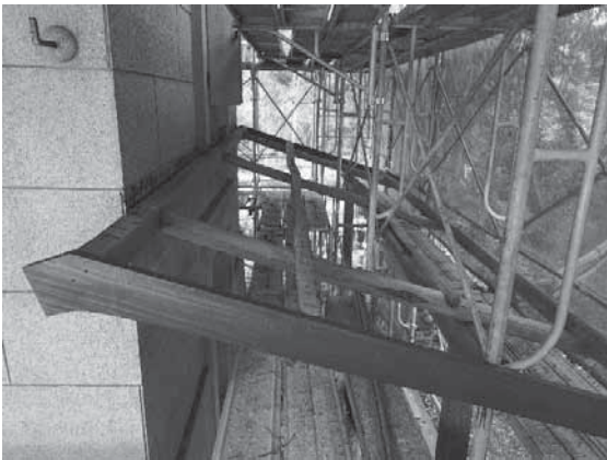
写真 4-111 下屋屋根、下地修理後
