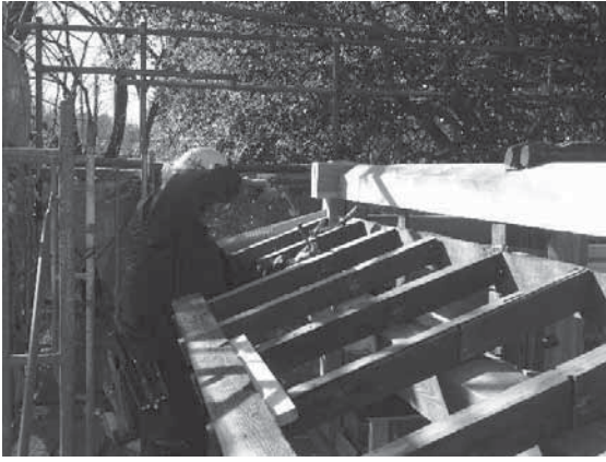
写真 4-45 出し桁、南面西側隅（復原部分）
