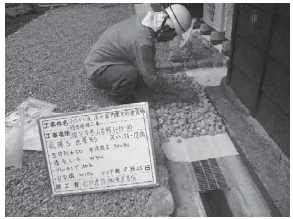
写真 4-91 雨落ち、玉砂利敷き
