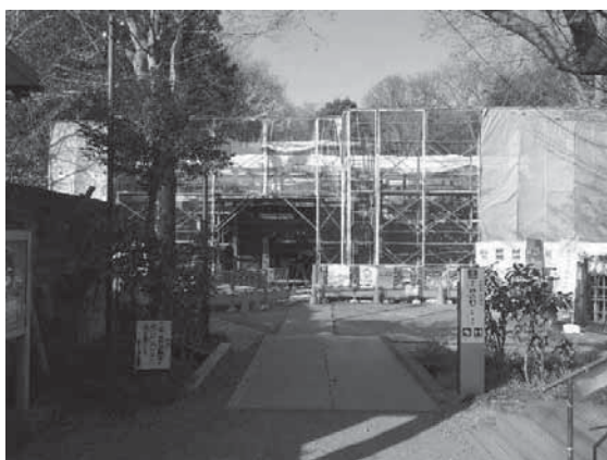
写真4-11 外部足場（壁養生の一部に透明シートを使用）
