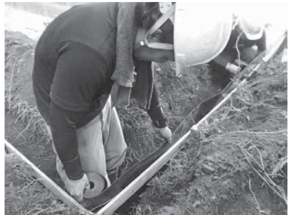
写真 4-114 防竹シート埋設
