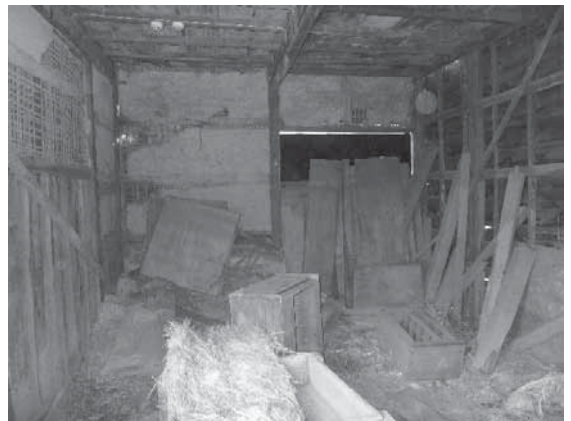
写真3-14 内装：壁（一階物置）
