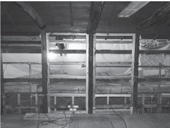
写真 4-78 補強壁（土壁を置換）、木下地
