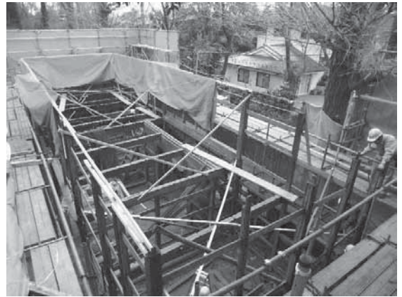
写真 4-24 軸部の解体
