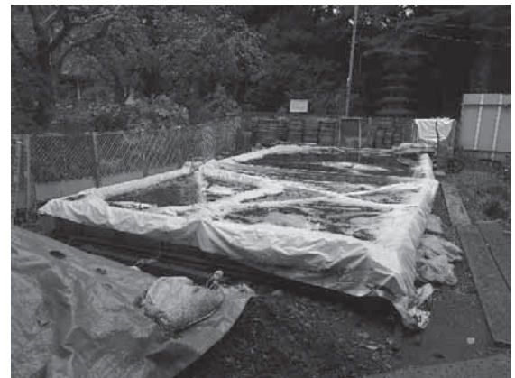
写真 4-10 長屋門北側（壁土練場）
