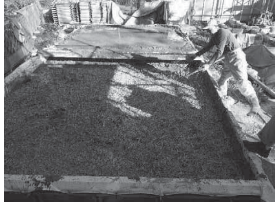
写真 4-59 土に藁スサを混ぜる
