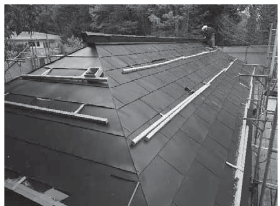
写真4-56 棟部金属板葺き
