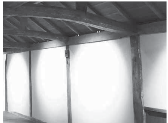
写真4-84 ピクチャーレール（軒桁上部）
