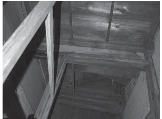
写真3-16 内装：天井（便所）
