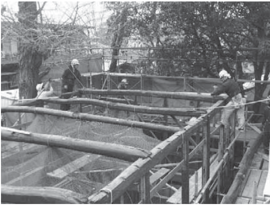
写真 4-23 小屋組の解体
