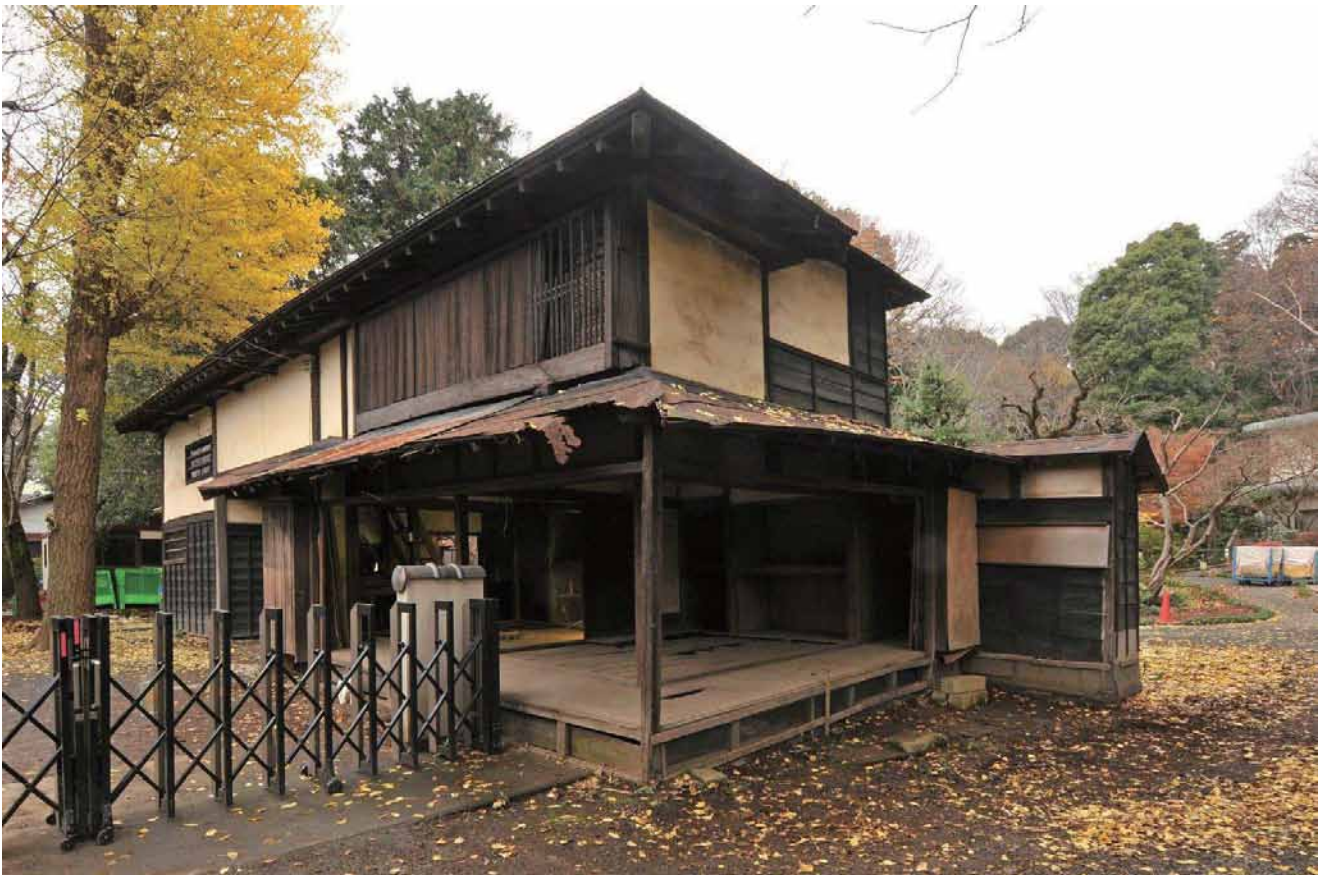
14. 【長屋門】修理前 南東面
