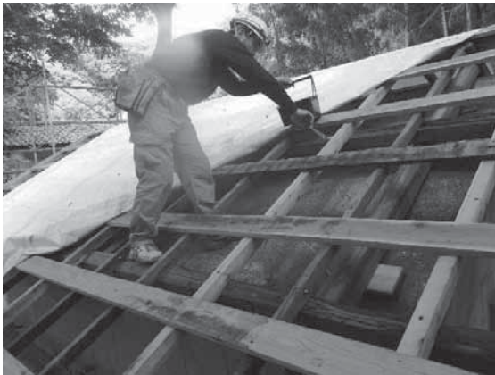
写真 4-110 置き屋根、防腐剤塗布
