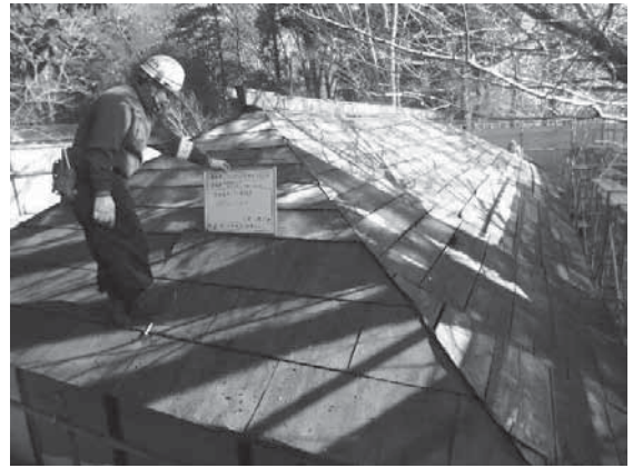
写真4-14 屋根葺材（亜鉛鉄板）撤去
