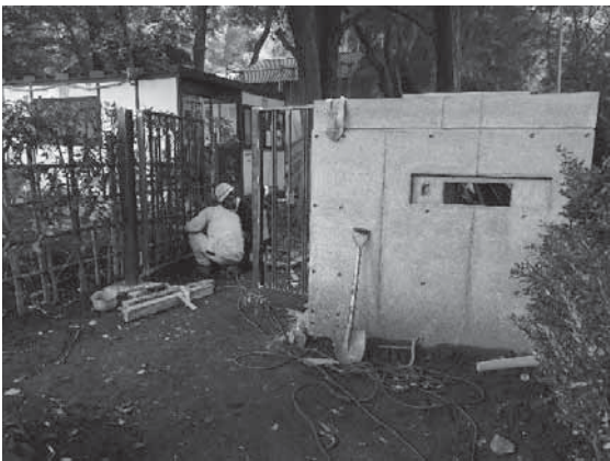
写真 4-94 職員用通用口、門扉取付
