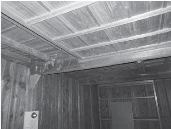
写真 3-71 二階床見上げ
