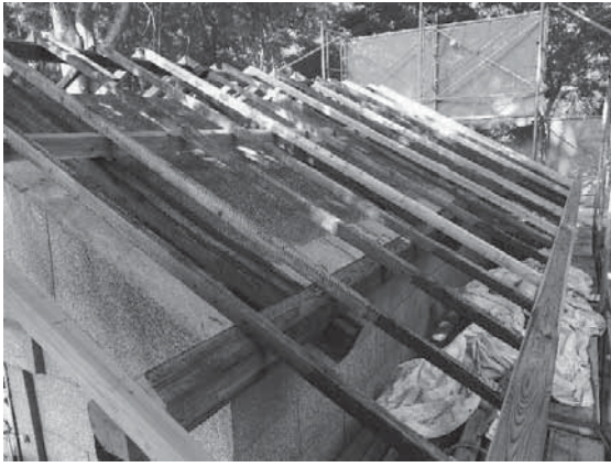
写真 4-109 置き屋根、下地修理後
