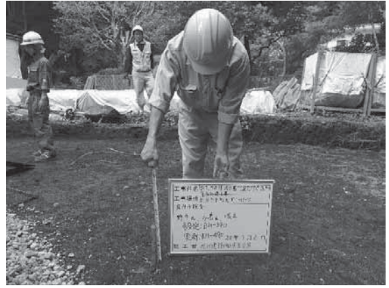
写真 4-30 根切り底の確認
