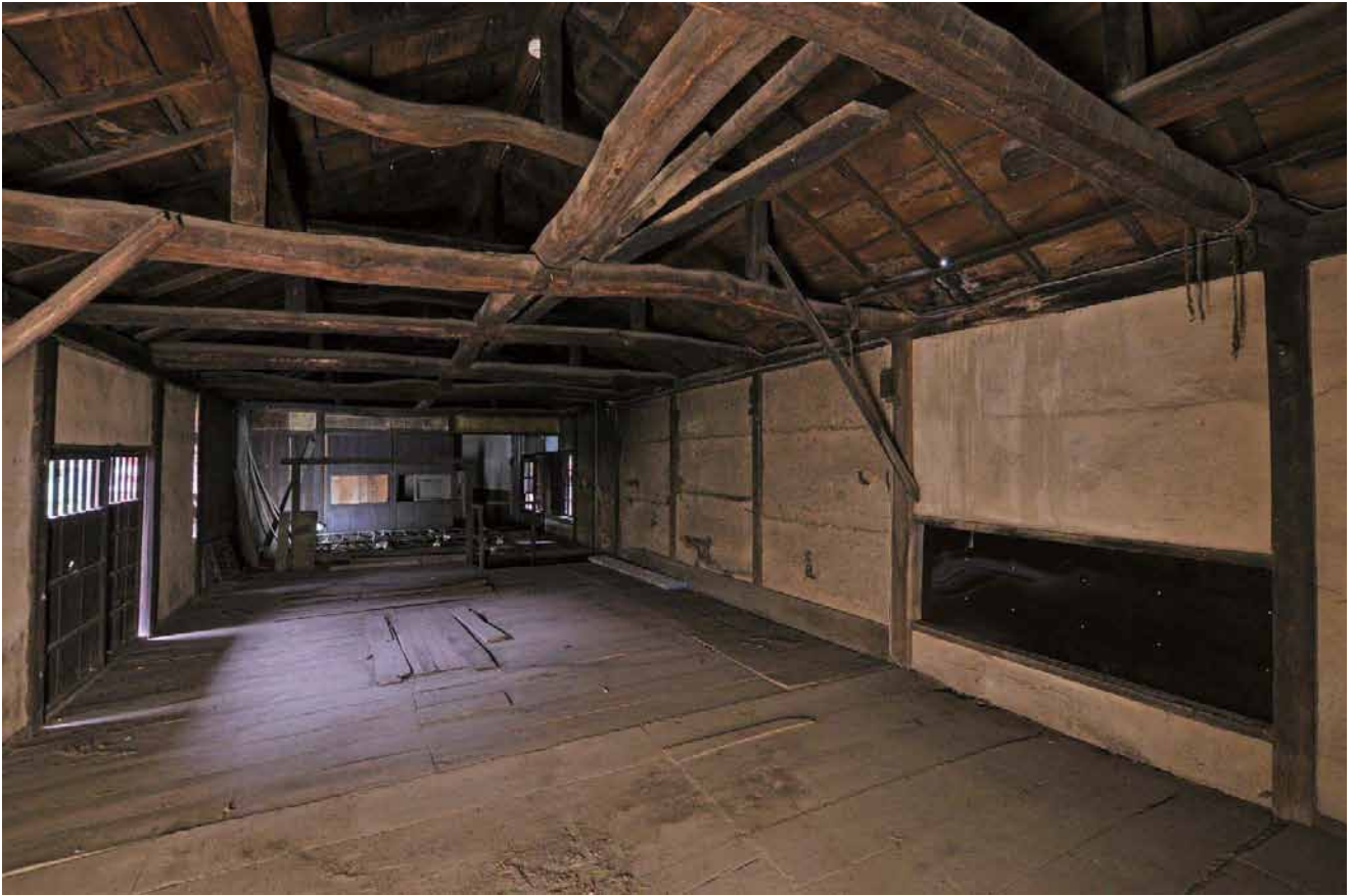
23. 【長屋門】修理前 二階板間
