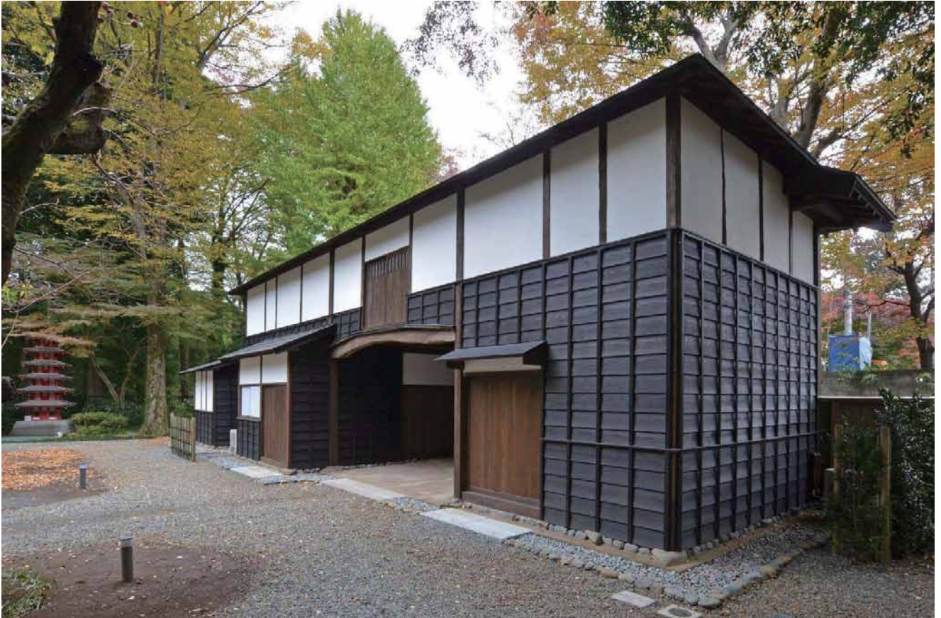
5. 【長屋門】修理後 北西面
