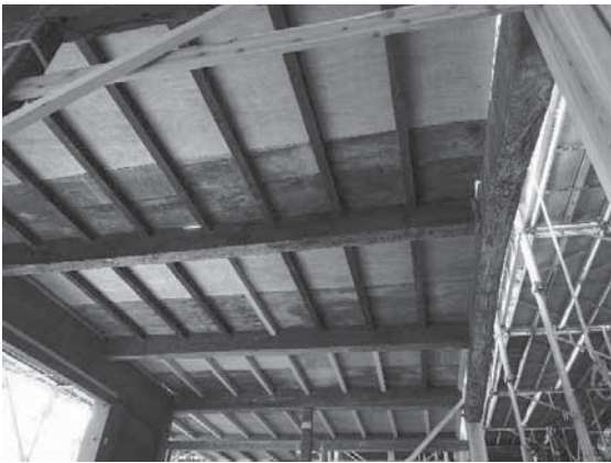
写真 4-47 二階根太組み
