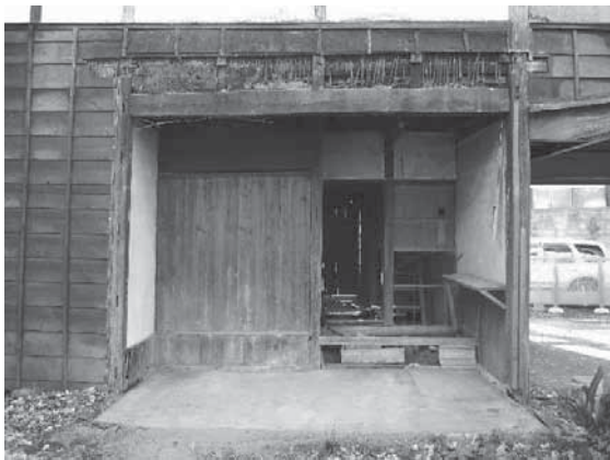
写真 3-24 コンクリート土間部分の上屋解体
