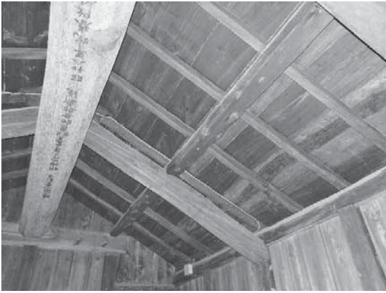
写真 3-70 後補材と思われる牛梁と登梁
