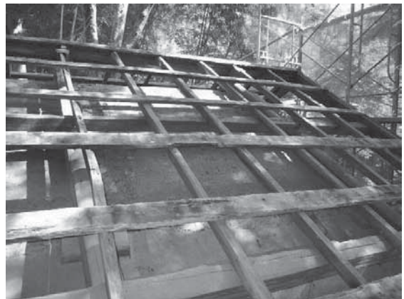
写真4-106 置き屋根、波板撤去後
