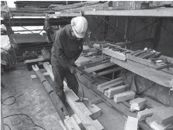
写真 4-39 補足材の仕上作業
