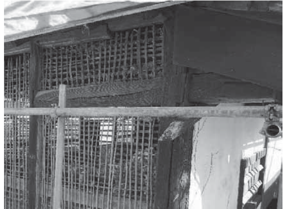
写真3-4 軸部：柱頭部（へー一通り）
