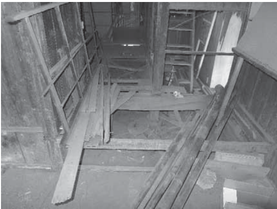
写真3-11 内装：床（板の間）
