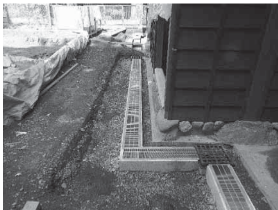
写真 4-89 雨落ち、グレーチング
