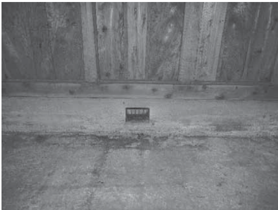
写真 3-72 コンクリート製の布基礎
