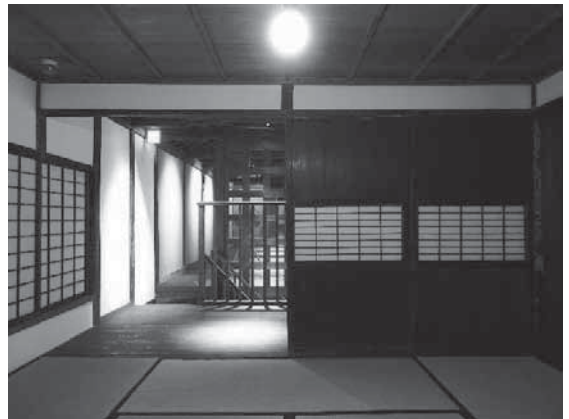
写真 4-73 板戸、障子の吊り込み (二階八畳)
