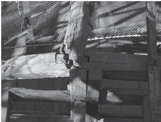
写真3-5 軸部：梁、軒桁（へー五通り）
