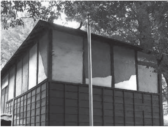
写真3-9 外壁：漆喰壁（西面、北面）
