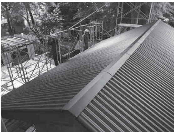
写真 4-112 波板葺き替え後
