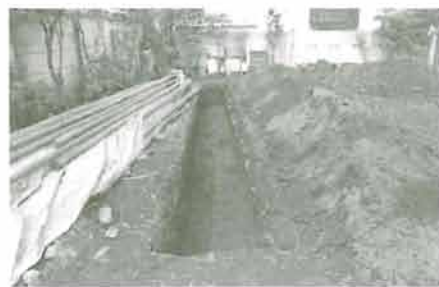
Cトレンチ全景（東から）
