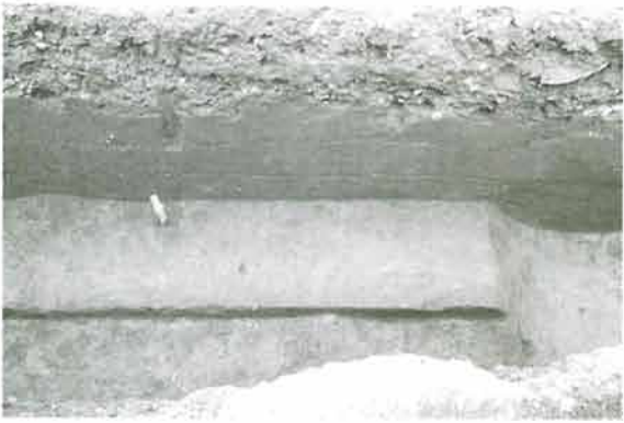
SF1道路硬質面断面 (南から)
