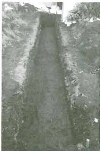
Bトレンチ全景（西から）
