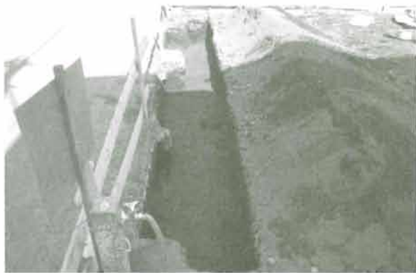
Aトレンチ全景 (西から)
