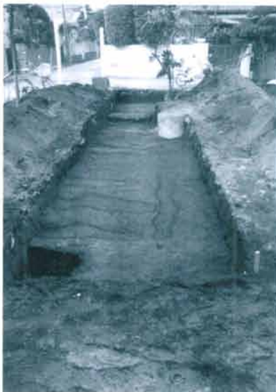
図1 Bトレンチ全景 (南から)
