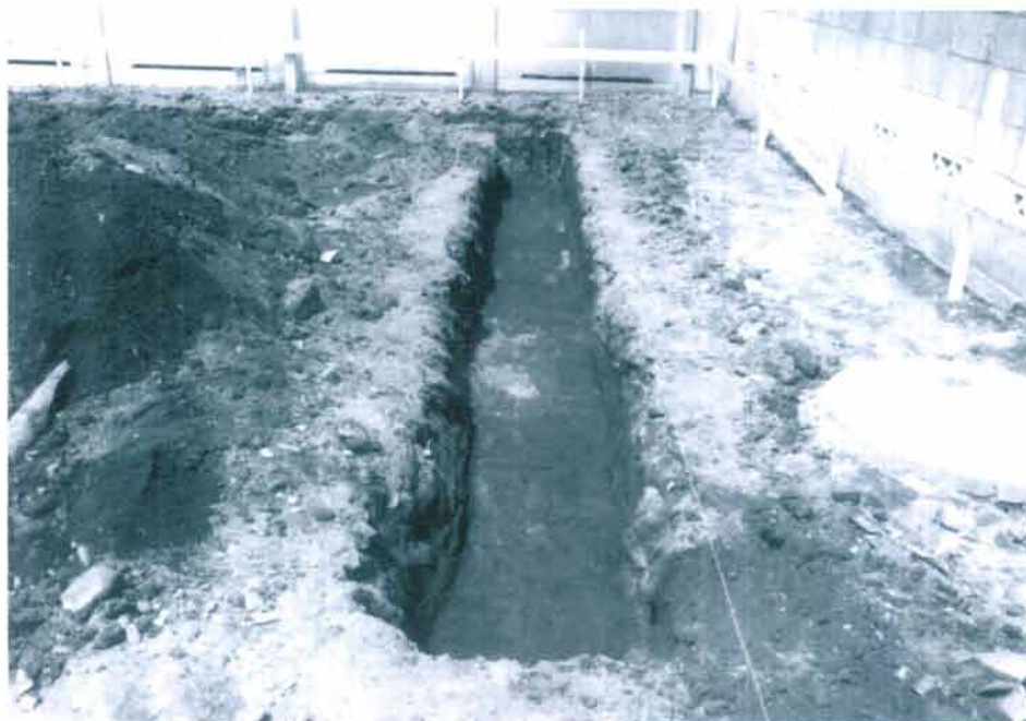
図 1 調査区全景(東から)
