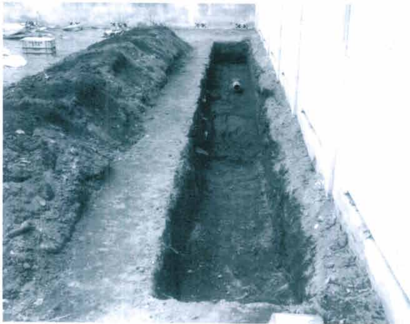
図 1 調査区全景(東から)
