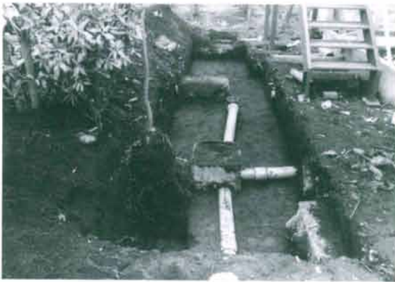
図1 調査区全景 (南から)
