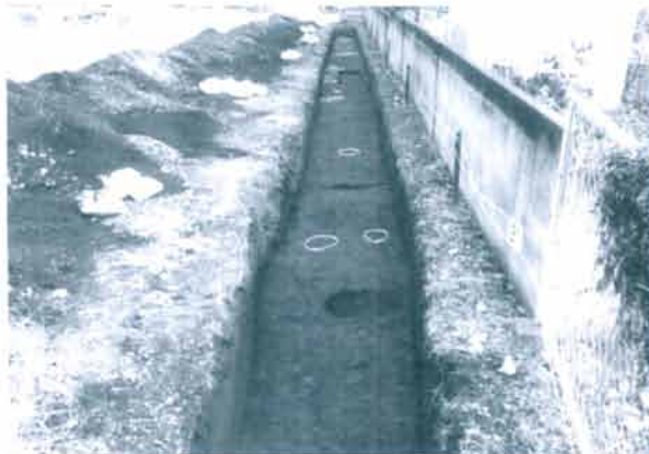
図 3 C トレンチ全景(西から)
