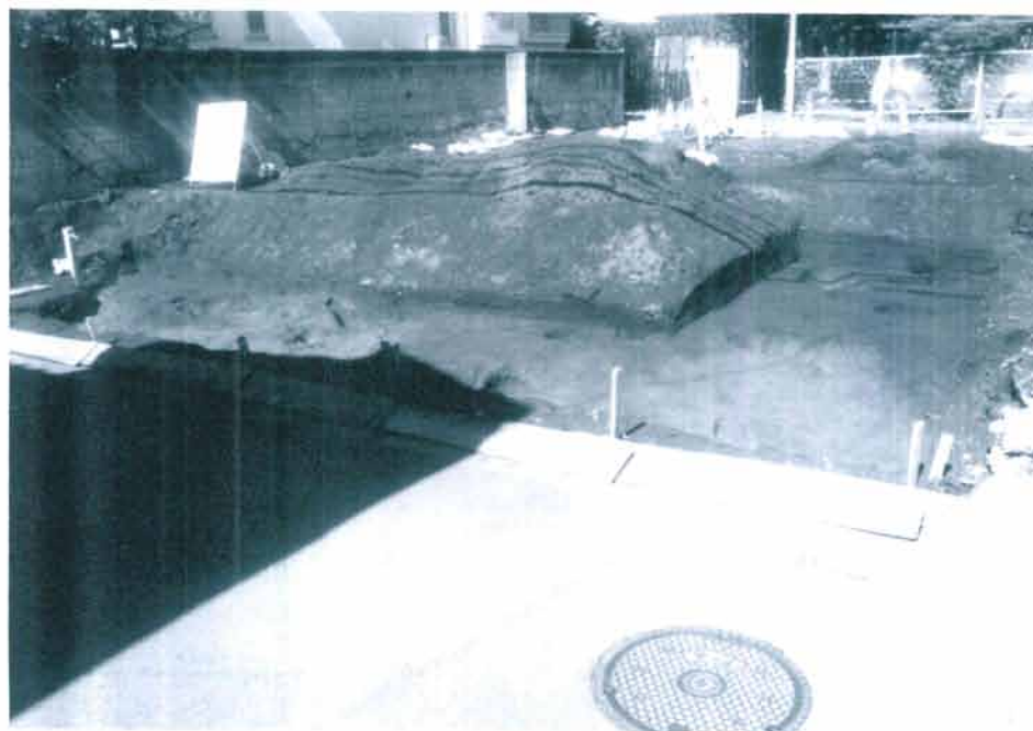
図 1 A トレンチ全景(南東から)
