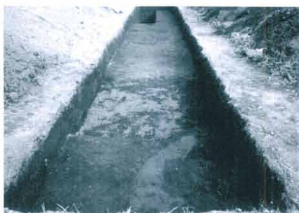
図 2 南トレンチ全景 (西から)
