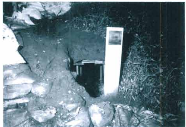
図 2 入口部全景 (西から)
