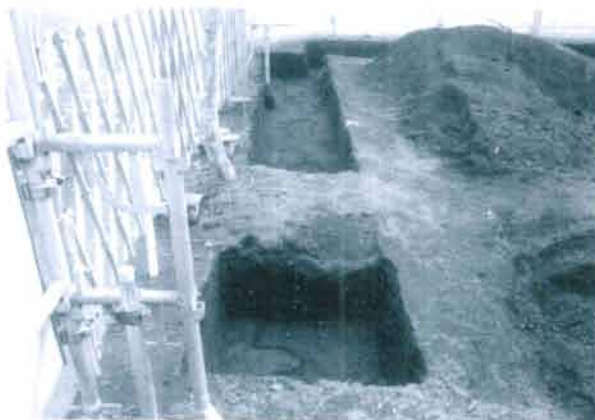
図 1 A トレンチ全景(北から)
