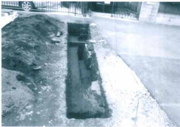
図 1 調査区全景(東から)
