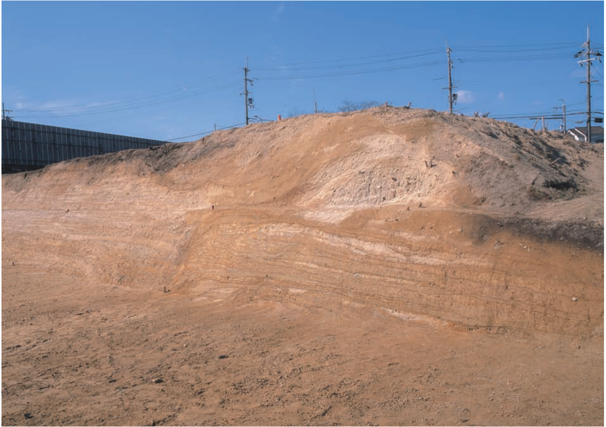
船橋川の堤防断面（北東から）
