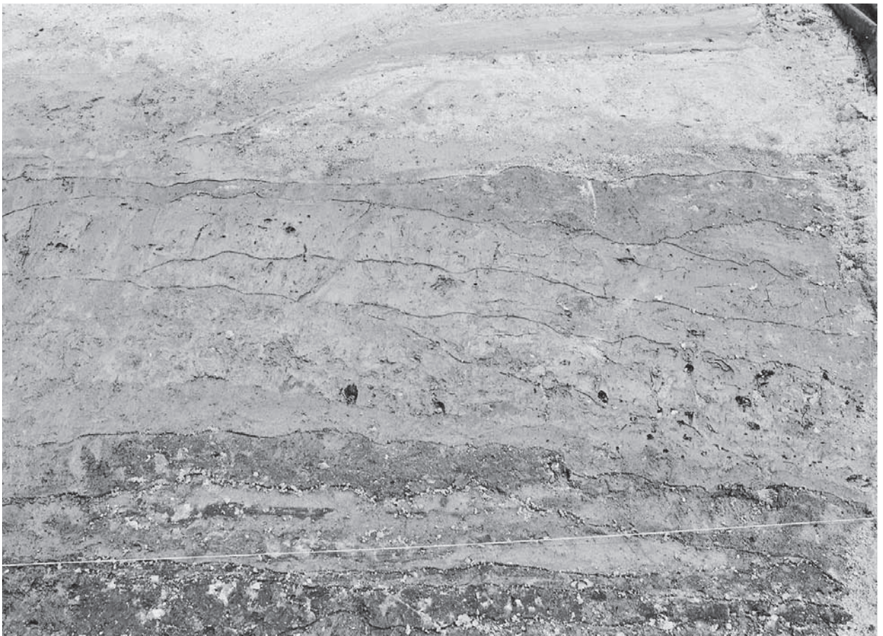
2.6-2区東壁 第4-1層～第4-3層（南西から）
