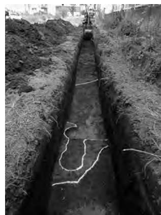
北トレンチの様子
