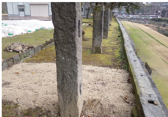
長塀基礎石と控石柱
