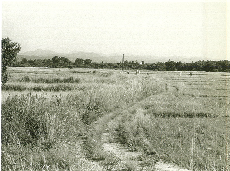
高城地区作業状況
