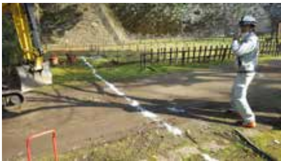
1 地点状況 南から
