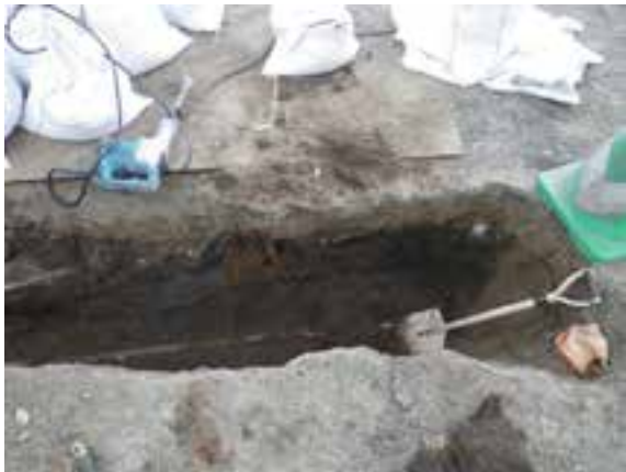
入れ替え工事
