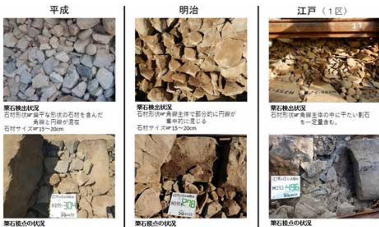
図3. 各期栗石検出状況（上）と築石接点の状況
