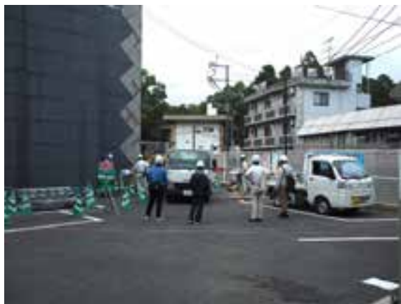
工事立会状況 (東から)
