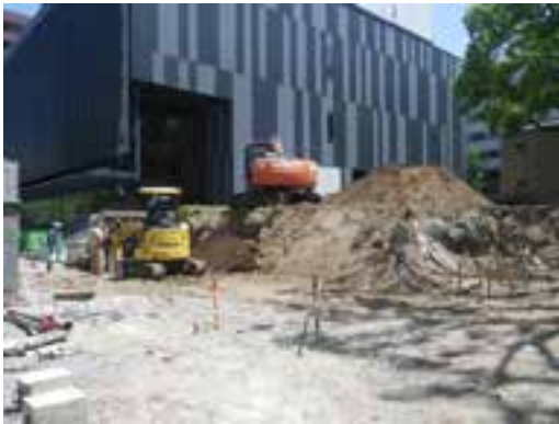
掘削状況 南西から
