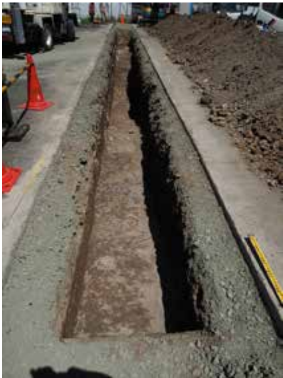
1 トレンチ 西から
