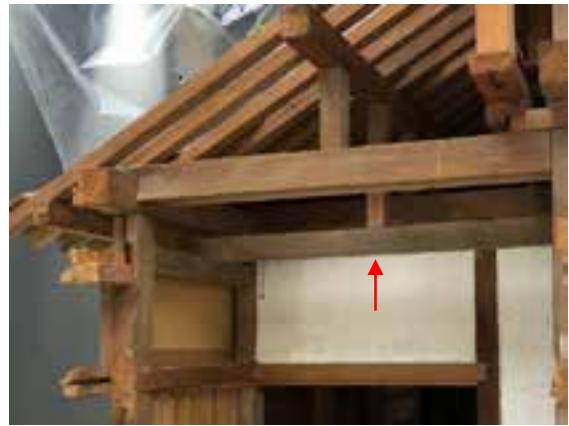
図10 腕木に立てられた小屋束(小天守1階西側)
