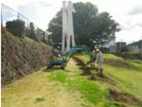
7 地点作業風景
