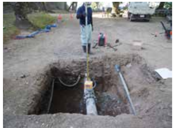
放水管露出状況
