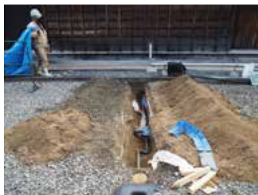
掘削状況（西から）
