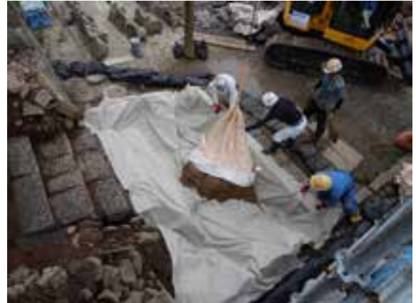
土木シートによる養生作業
