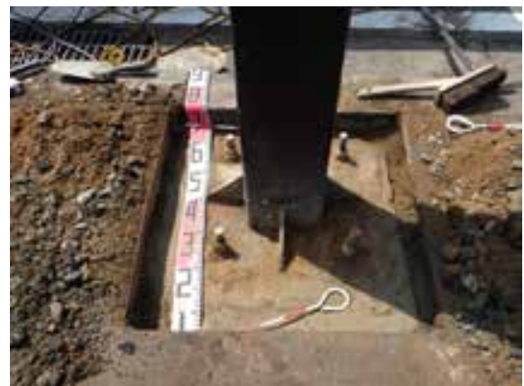
掘削状況 北から
