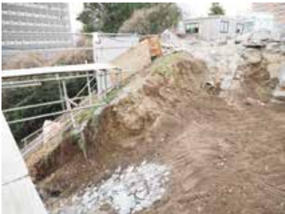
写真5 北東部分盛土の状況
