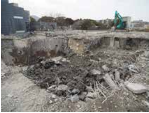
写真1 西側基礎撤去前
