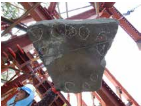
写真9. 江戸期修理箇所の築石接点
