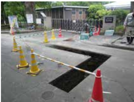
掘削地点 南東から
