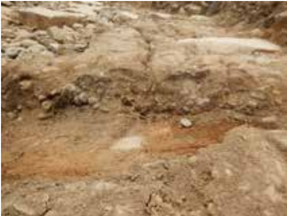
写真5. 1区地割れ断面
