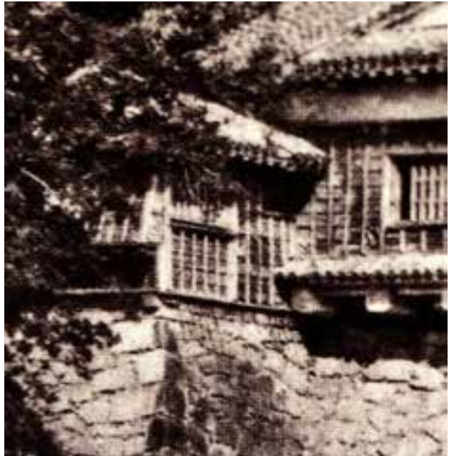
図 23 西側雪隠部分古写真
