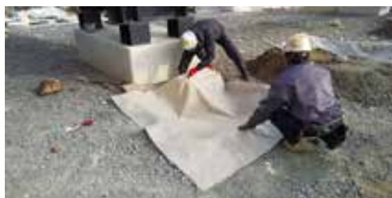
土木シートによる養生作業
