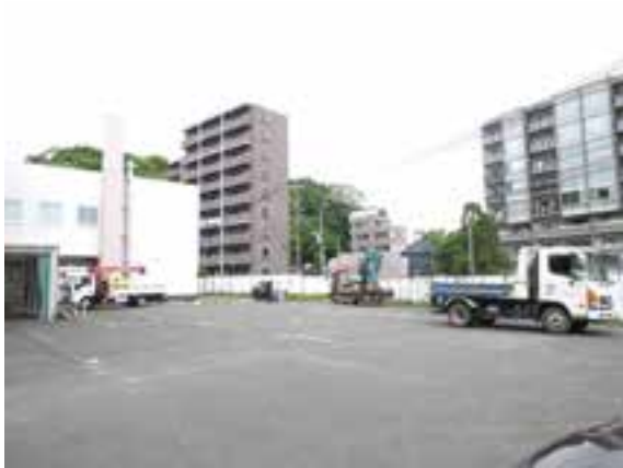
敷地増築部分 東から
