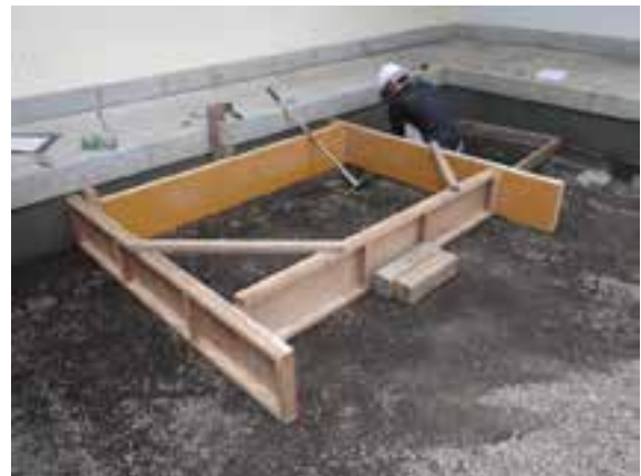
移設先基礎枠設置
