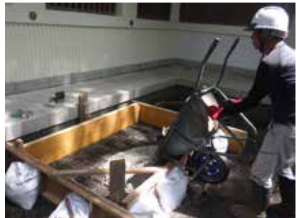
移設先コンクリート打設
