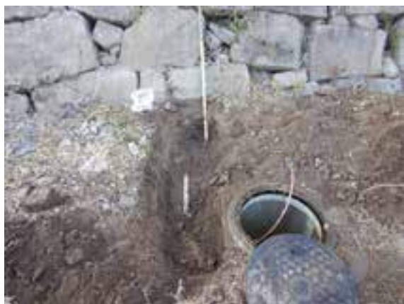
立会地点②掘削完了
