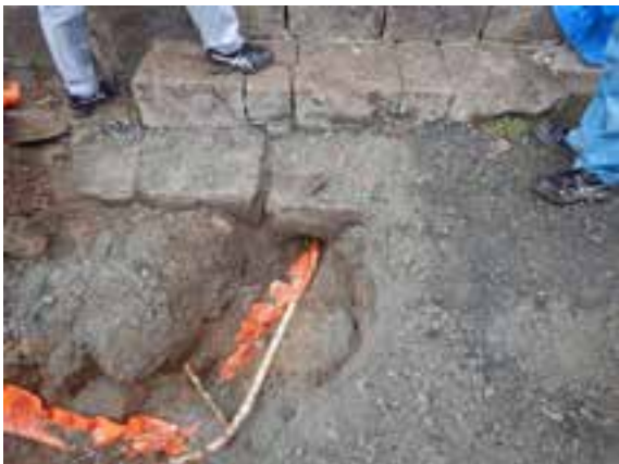
立会地点④掘削完了
