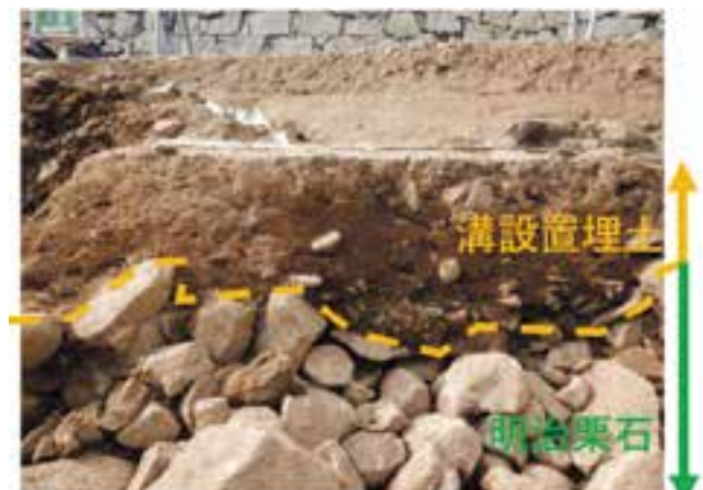
写真2. 3区溝設置状況
