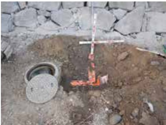
立会地点③掘削完了
