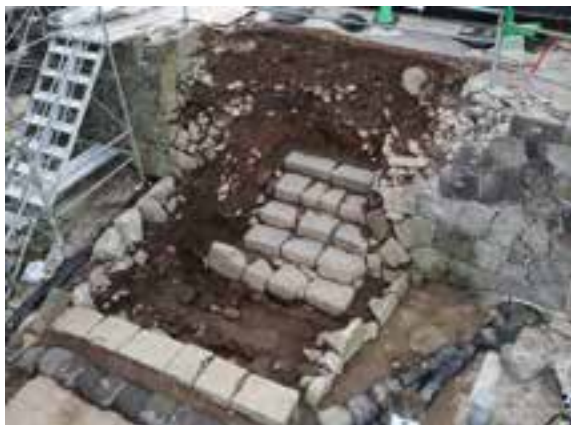
掘削完了状況（北壁）
