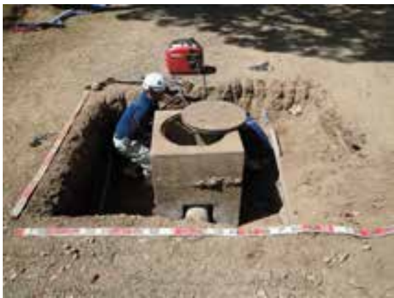
既存ボックス露出状況
