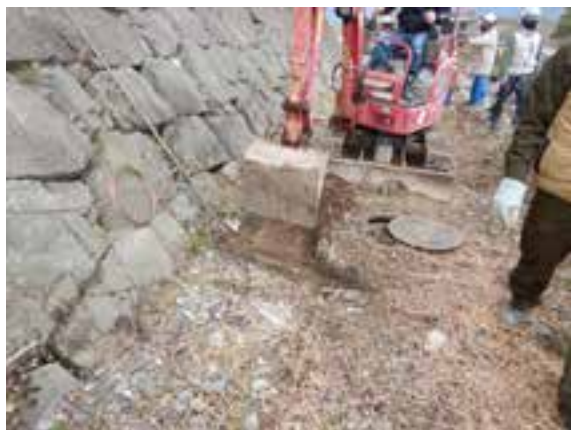
立会地点②掘削作業
