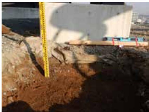
掘削完了状況（北壁）
