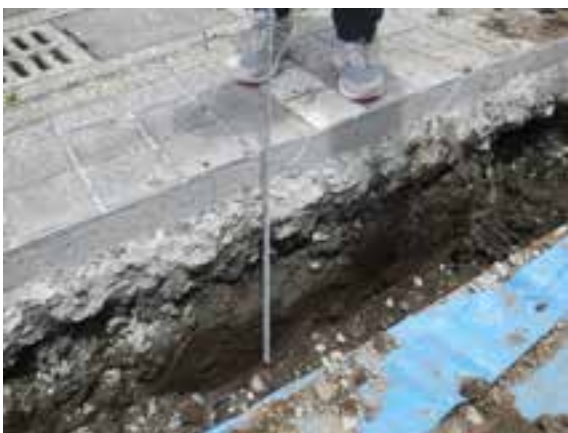
b地点掘削状況 南から
