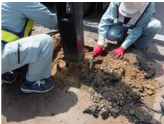
掘削作業 北西から
