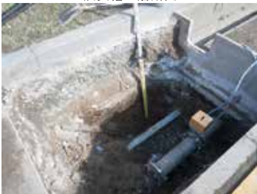
本丸御殿北側掘削状況 南から
