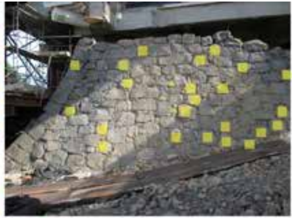
熊本城石垣2期（大天守台北面）
