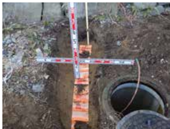
立会地点②山砂敷設
