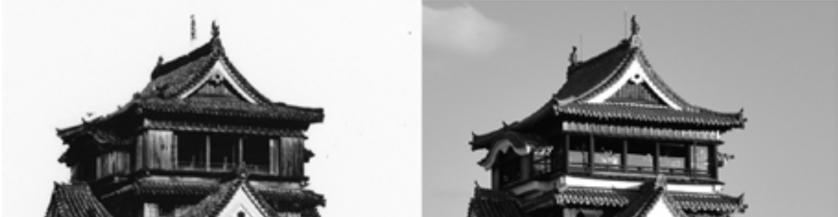
図 17 大天守最上階古写真・再建天守閣比較
