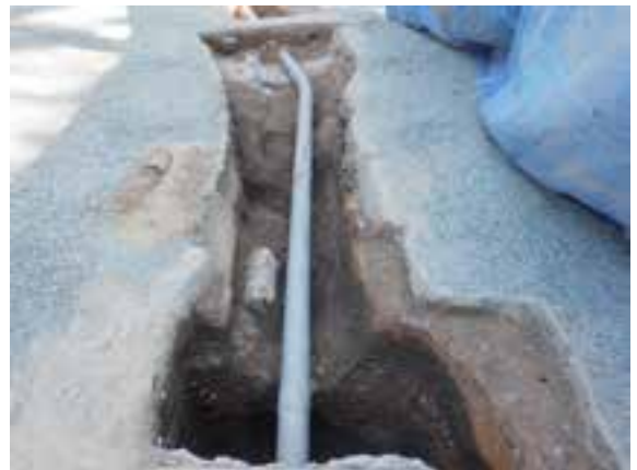
3トレンチ 西から
