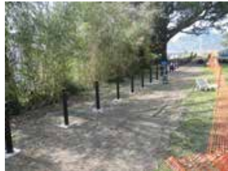
8 地点設置状況
