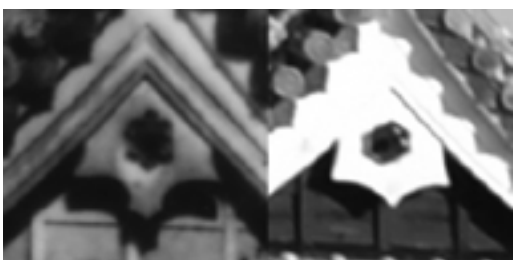
图 30 小天守最上階懸魚比較(左・古写真/右・再建)
