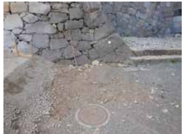
立会地点④埋め戻し完了
