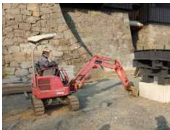
掘削作業状況
