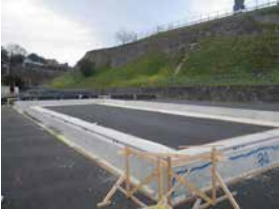
建物基礎工事
