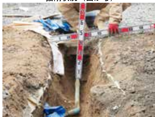
掘削状況（西側）
