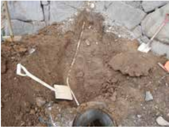
立会地点①掘削完了
