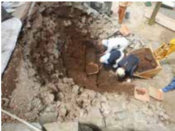
掘削作業状況
