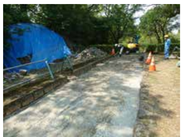
埋め戻し 南から
