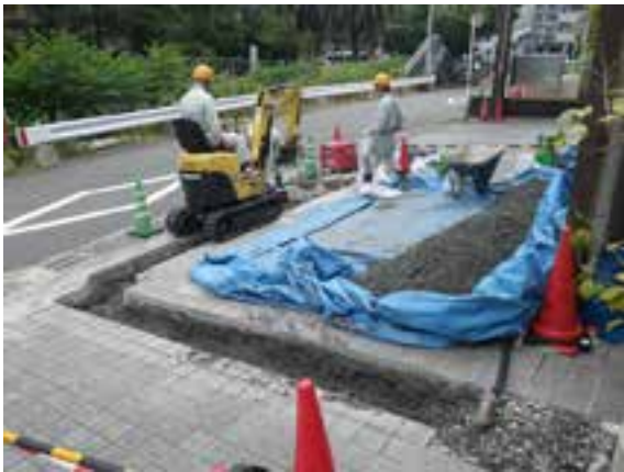
掘削地点 南西から
