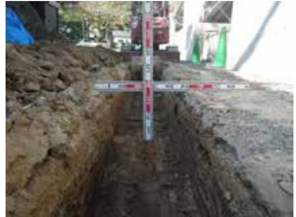
掘削完了 東から
