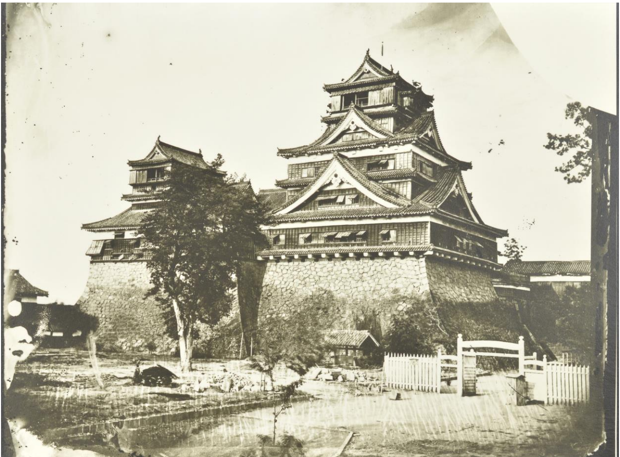
写真3 数寄屋丸から大小天守を望む (2) (富重写真所蔵)・(s-3)
