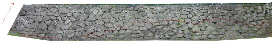
図4 熊本城明治22年被災箇所修復石垣
