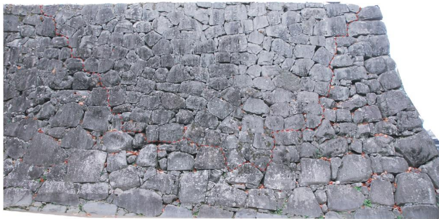
図3 熊本城明治22年被災箇所修復石垣
