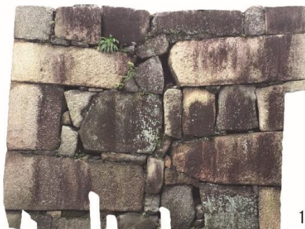
図11 名古屋城明治24年被災箇所修復石垣【2-a類】横目地が通る整層積みで新補石材を用いた石垣
