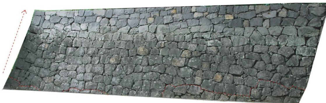
図5 熊本城明治22年被災箇所修復石垣
