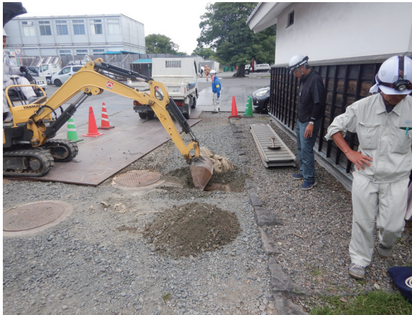
掘削状況（南から）
