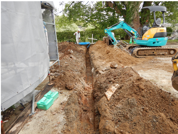
地点 2- V 周辺掘削状況 遠景（西から）
