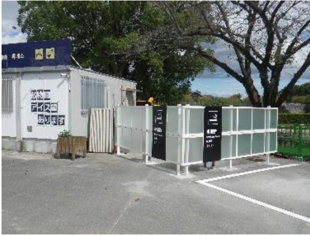
設置状況（南西から）
