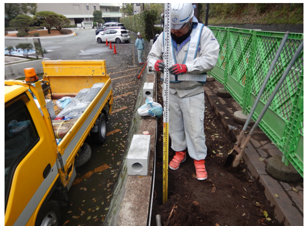
支柱設置に伴う掘削箇所（北から）
