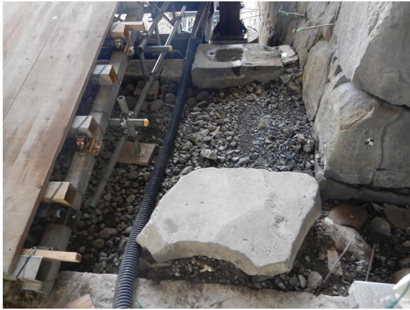
南側礎石掘削前
