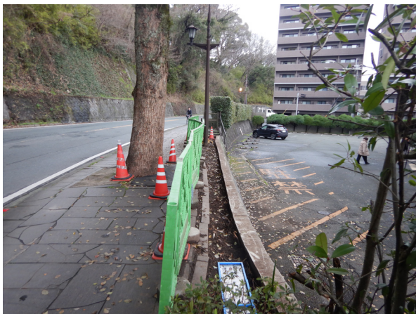
工事箇所遠景（南から）
