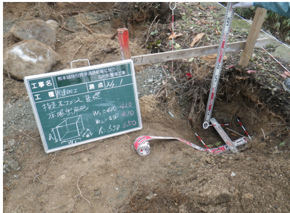
擬木フェンス基礎掘削状況
