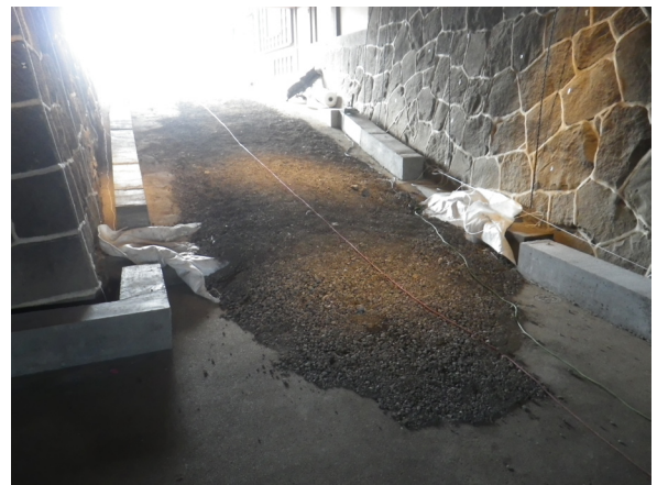
間り通路施工状況（北から）
