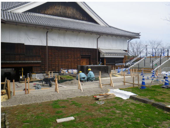
大御台所部分施工状況（南西から）
