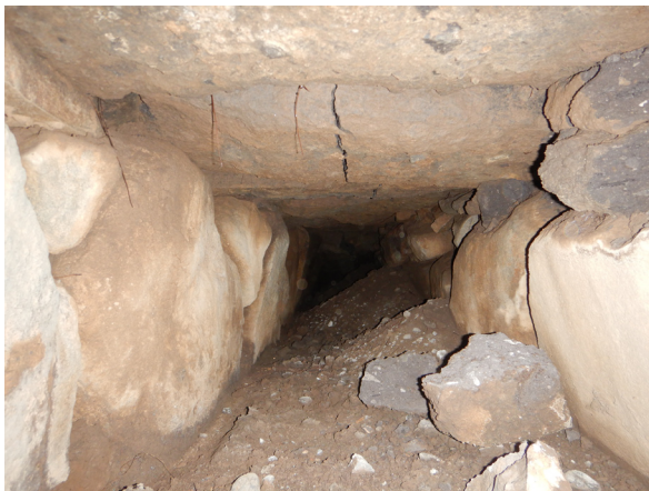
水路内部状況 北から
