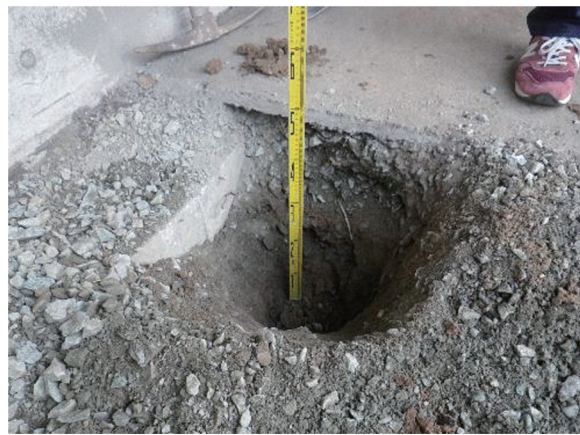
地点2 フェンス基礎A 掘削状況
