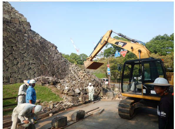
H8 面 石材回収・ナンバリング作業風景（南西から）
