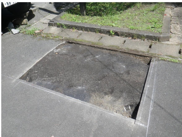
精算機 掘削状況 (南から)
