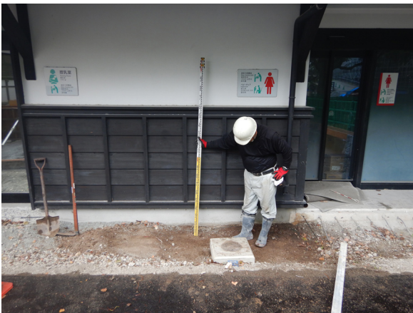
すき取り完了状況 遠景（東から）
