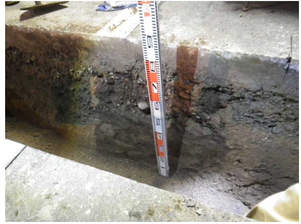
1 地点 土層写真
