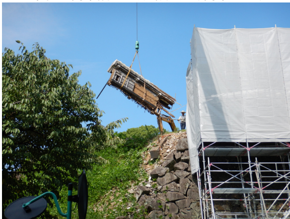
倒壊・崩落塀 回収工事風景（東から）
