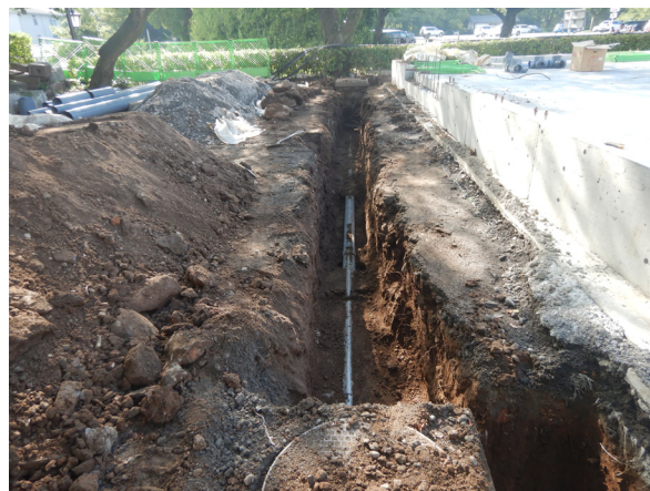
南側工事地点南 掘削箇所 遠景 西から
