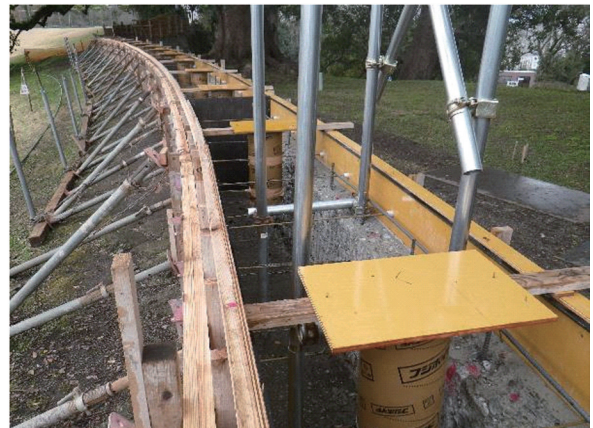
フェンス基礎工事状況
