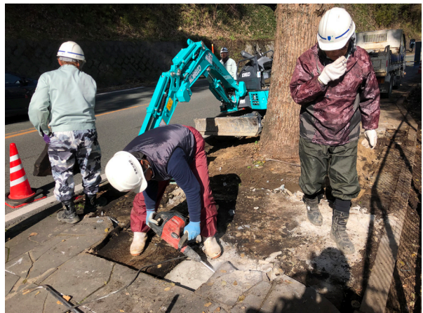
樹木周辺石敷撤去状況
