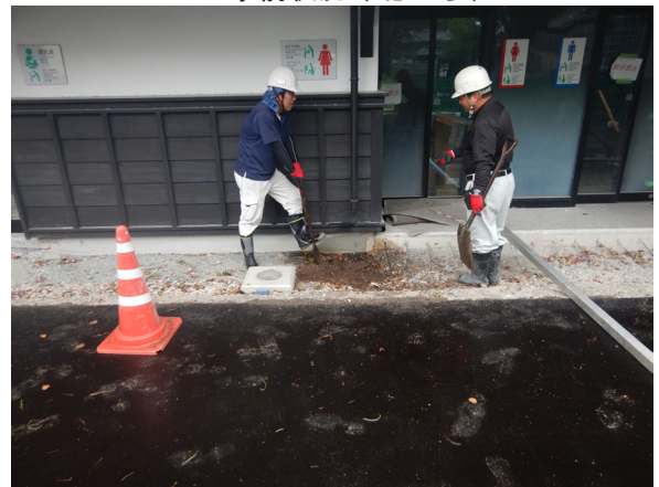
工事状況（東から）
