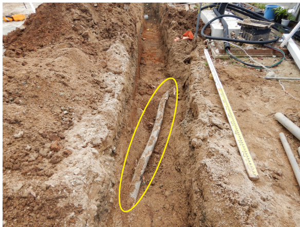
既設配管検出状況 (南から)
