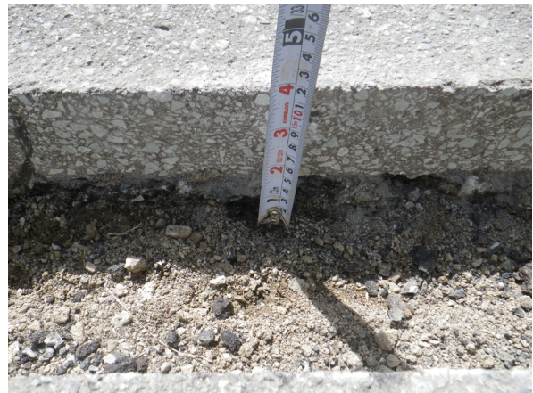
掘削状況 (南から)
