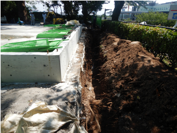
南側工事地点西 掘削箇所 遠景 (北から)
