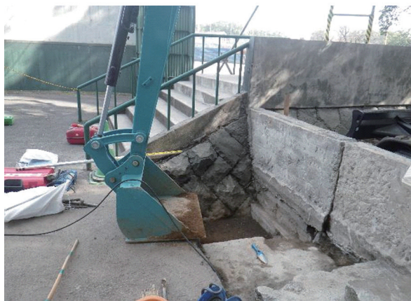
集水枡工事掘削状況
