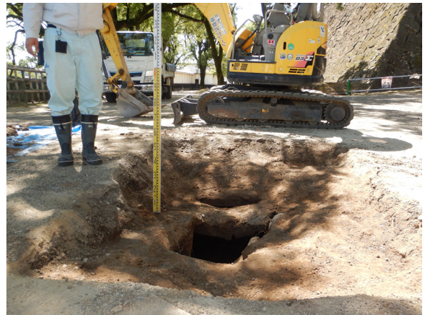
土層断面 北から
