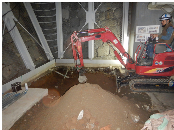
エレベーターピット掘削作業状況
