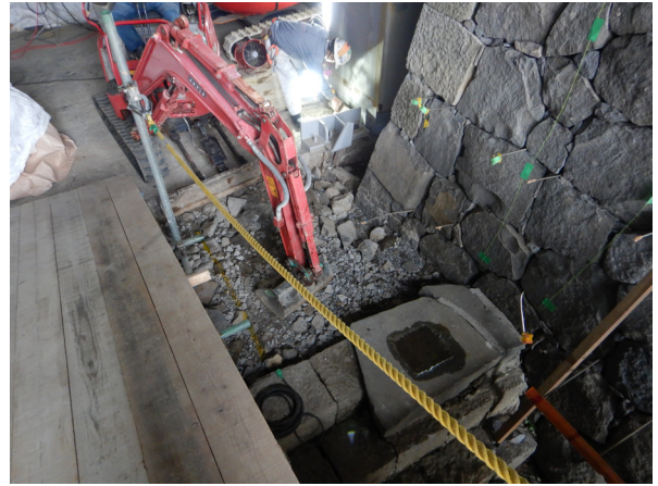
北側礎石掘削作業状況
