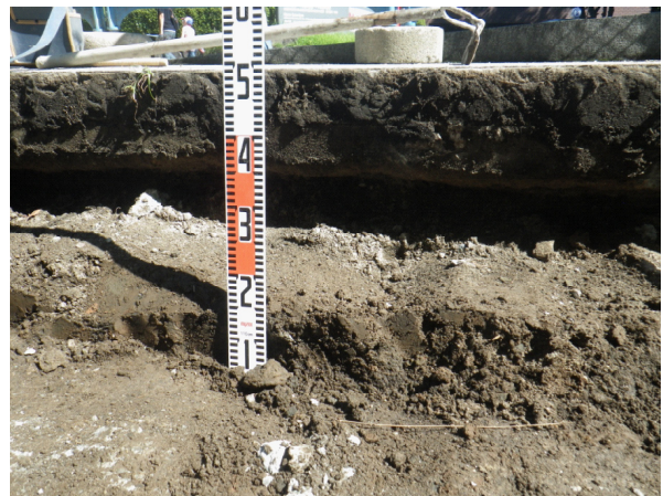
現地状況（南から）
