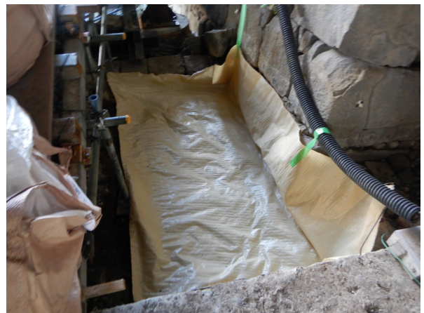
南側礎石石垣養生作業状況
