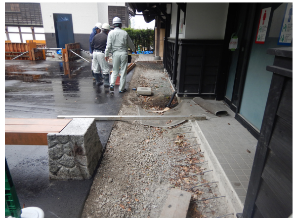
工事前状況（北から）
