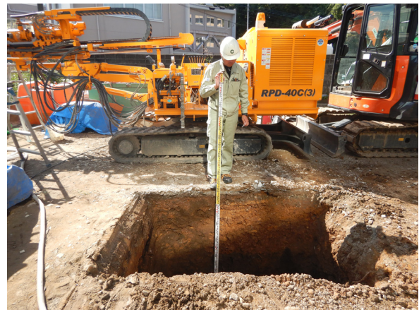
掘削状況（東から）
