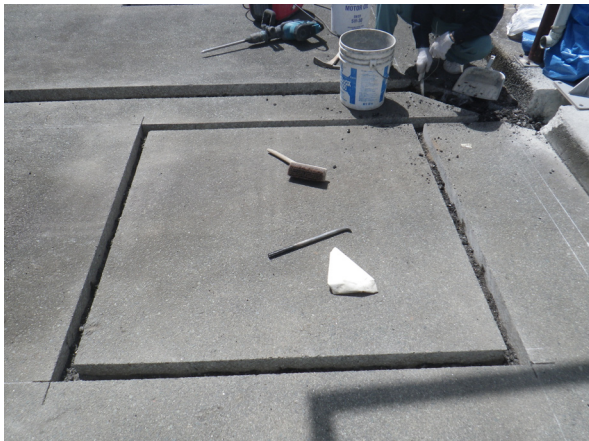
車両検知器 掘削状況 (南から)
