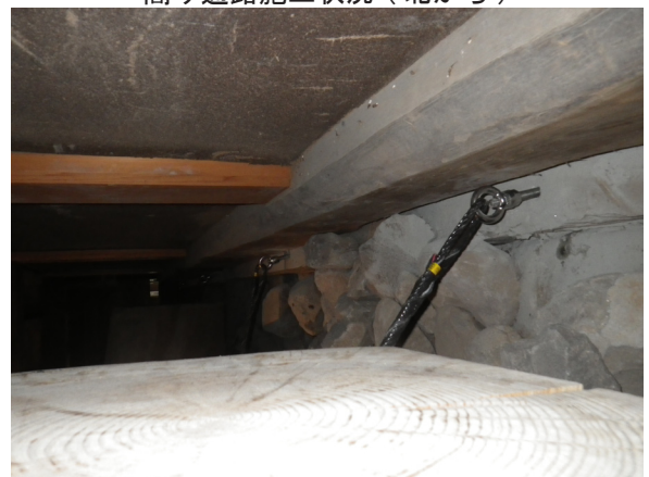
樹脂製ネットワイヤーアンカー設置状況
