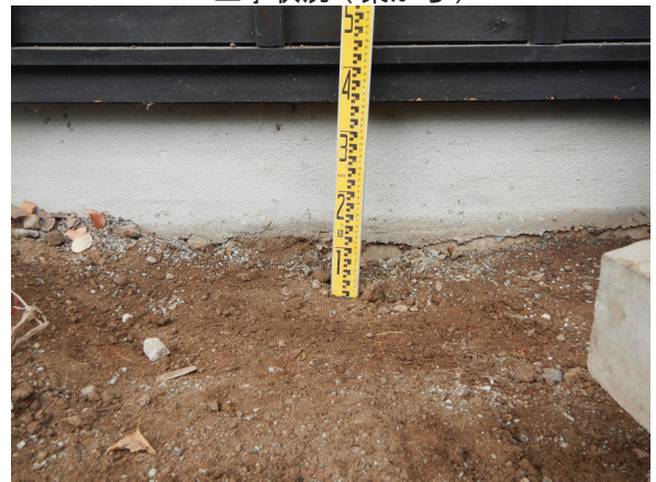
すき取り完了状況 近景（東から）
