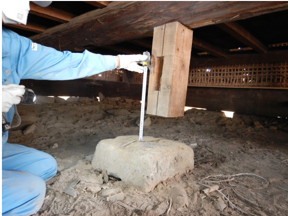
礎石No.1(西から)
