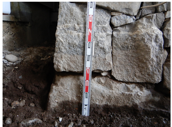
北側礎石掘削後 H508 検出状況
