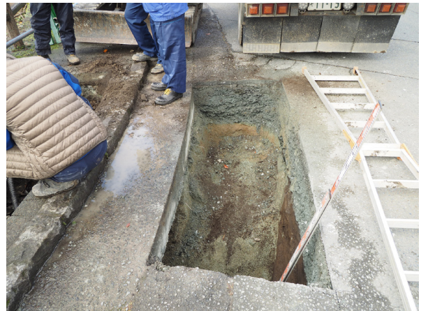
1地点 掘削状況
