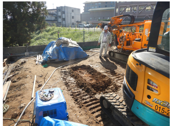
工事箇所遠景（北から）
