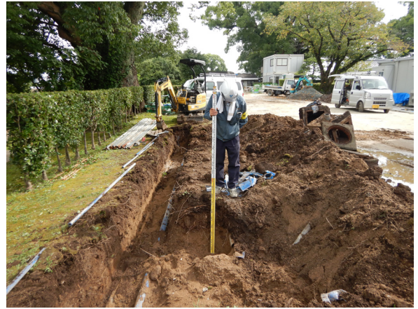
地点 2- III 掘削状況（北から）
