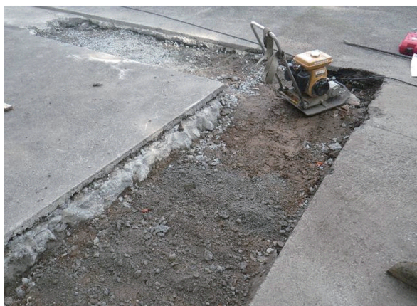
側溝工事掘削状況
