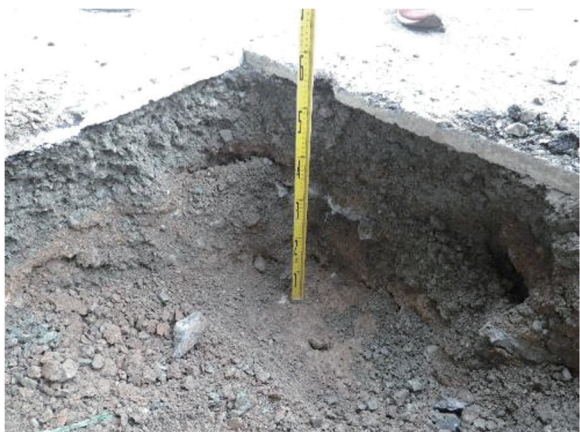
地点2 フェンス基礎B 掘削状況
