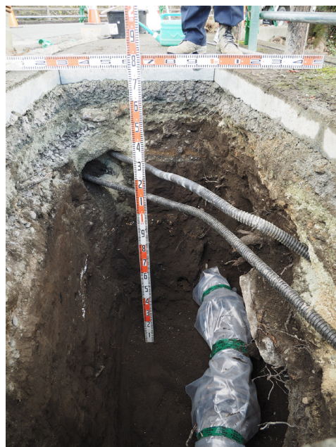
2地点 掘削状況（西から）
