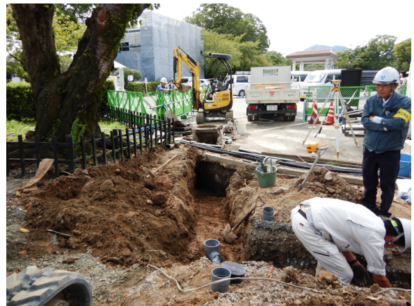
地点 2- VIII・IX 周辺掘削状況 遠景 (東から)
