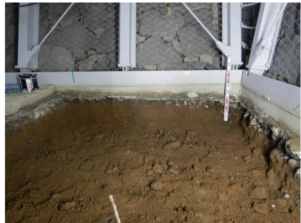
エレベーターピット掘削後
