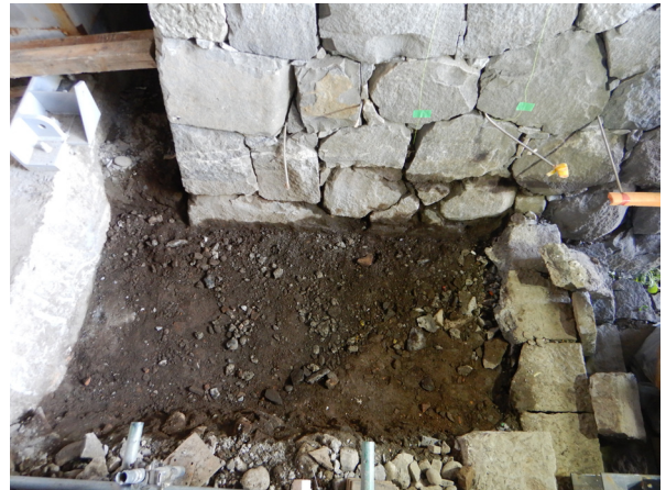
北側礎石掘削後
