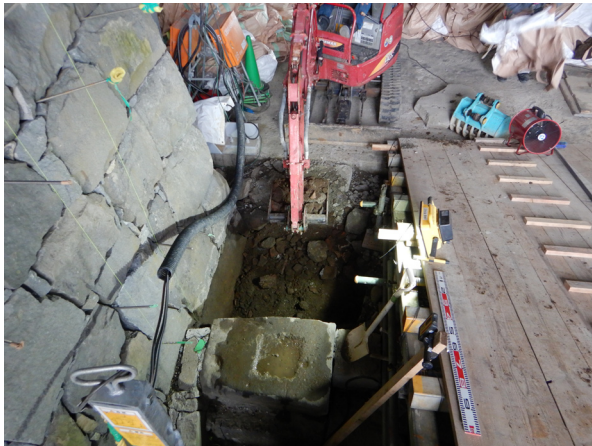
南側礎石掘削作業状況
