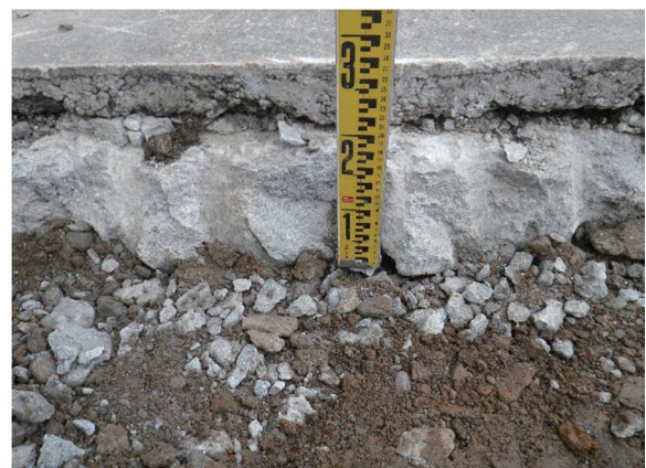
側溝掘削土層断面
