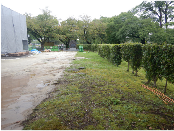
東側工事掘削前状況（南から）
