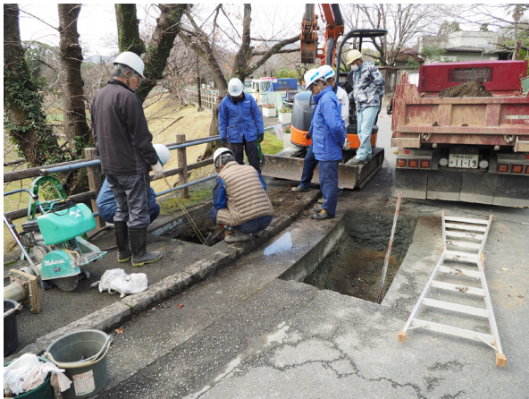
掘削状況（東から）
