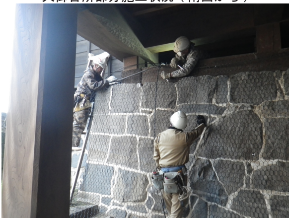
樹脂製ネット設置工事（西から）
