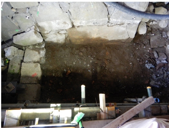
南側礎石掘削後
