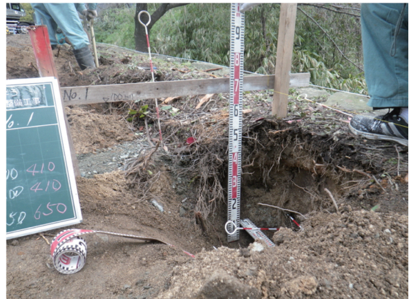
擬木フェンス基礎掘削土層断面
