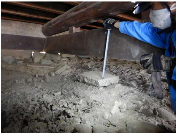
礎石No.2(西から)
