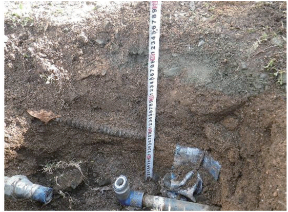
地点1 土層断面(西から)
