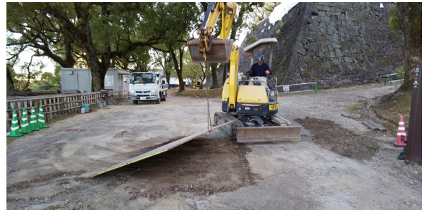
埋め戻し後鉄板養生作業
