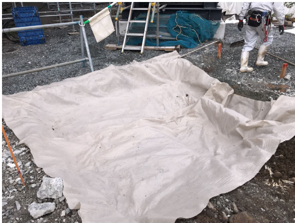
土木シートによる養生作業
