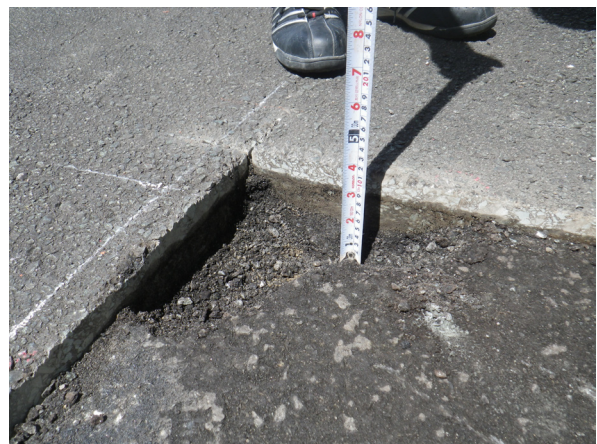
掘削状況 (南から)
