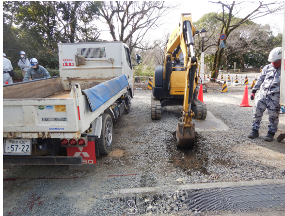
地点Ⅱ・Ⅲ掘削前周辺状況（北から）
