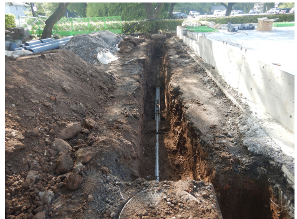
南側工事地点南 掘削箇所 遠景 (東から)
