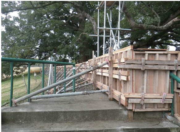
フェンス基礎工事 (南西から)
