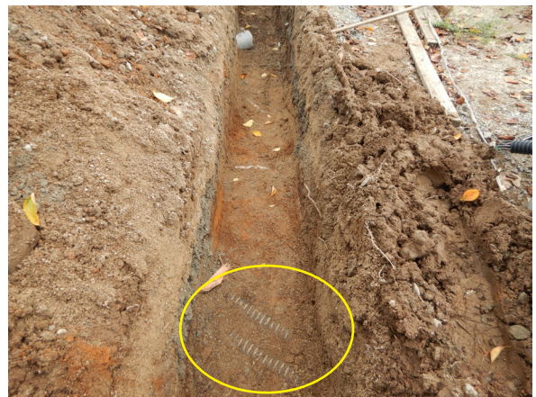
既設配管検出状況 (南から)
