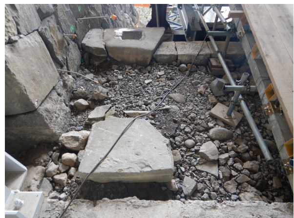
北側礎石掘削前
