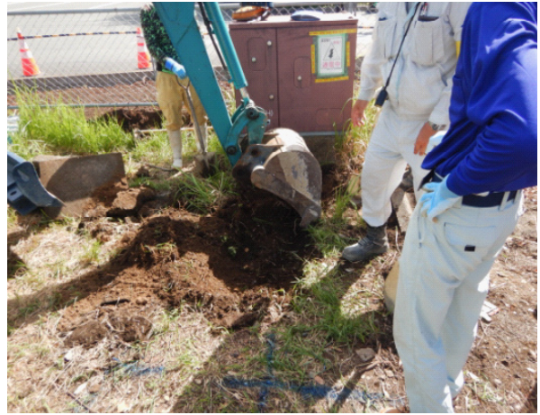
掘削作業状況（西から）
