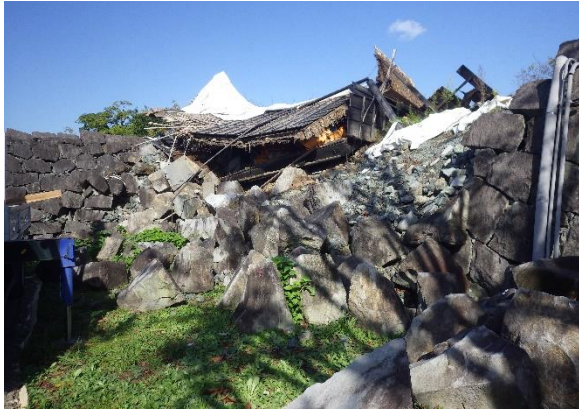
奉行丸 H33・34 被災状況 (南東から)
