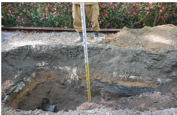
旧3番柵撤去状況(北から)
