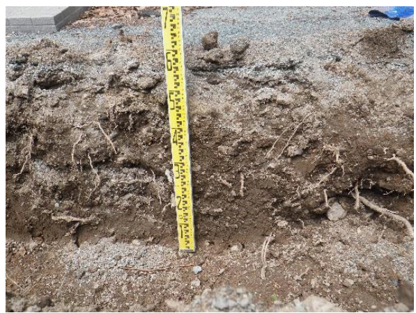
1地点土層断面 (東から)
