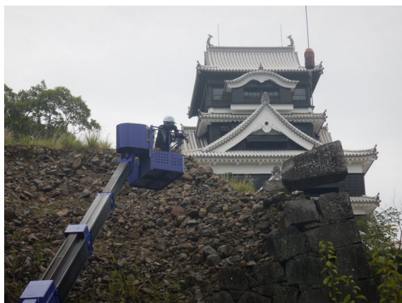
危険石材解体実施状況
