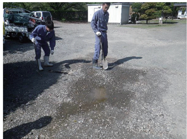
現地状況 掘削前(東から)
