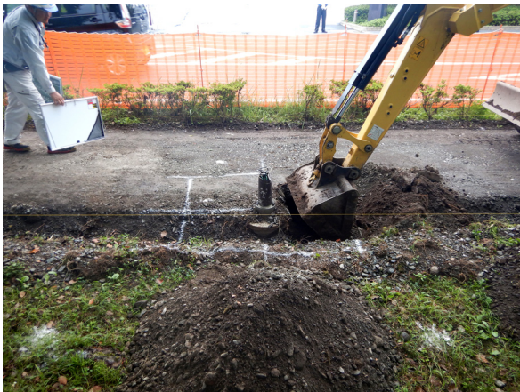
4地点掘削作業（南から）
