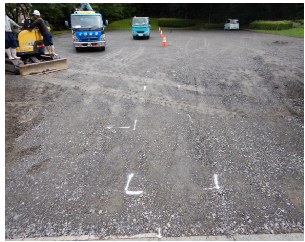
地点2 掘削前状況（東から）
