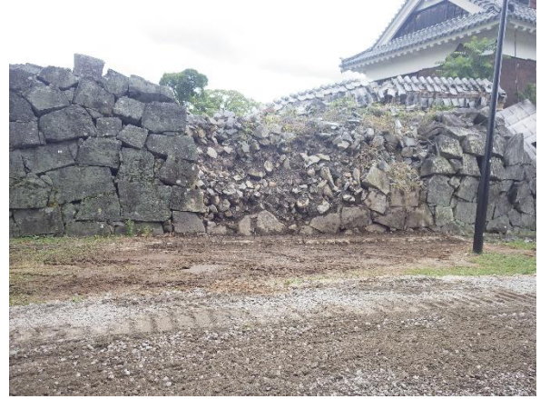
西出丸 H81 崩落石材回収後(東から)
