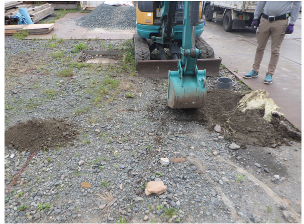
御裏五階櫓前掘削状況
