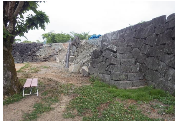
奉行丸 H34・35 崩落石材回収後 (南東から)
