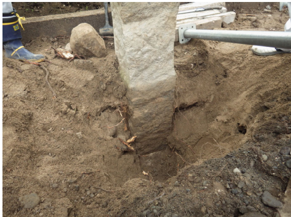
工事③施工状況 控柱周囲の掘削
