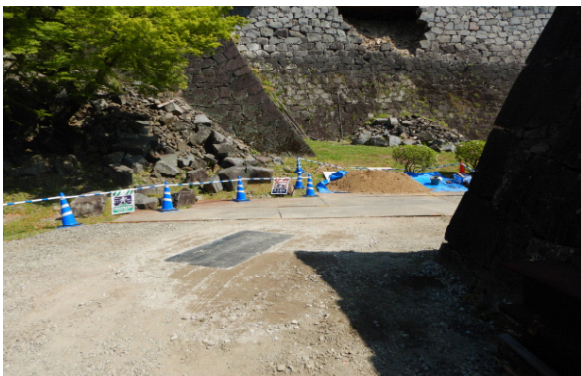
新規6番柵施工 完工状況 遠景（南から）
