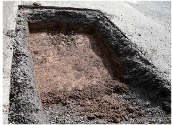
3 トレンチ (西から)
