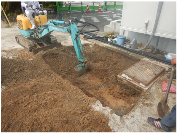
地点 1 掘削作業中 (北東から)
