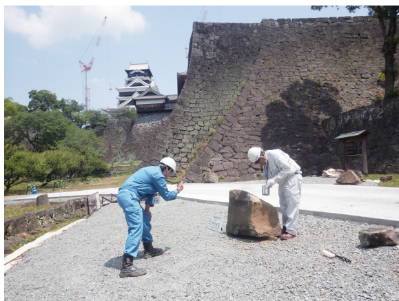
回収石材記録作業実施状況
