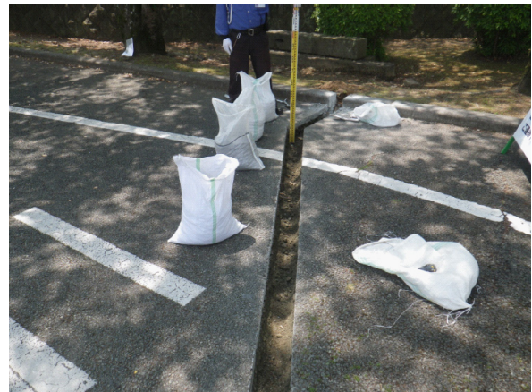
地点1 掘削状況(北から)
