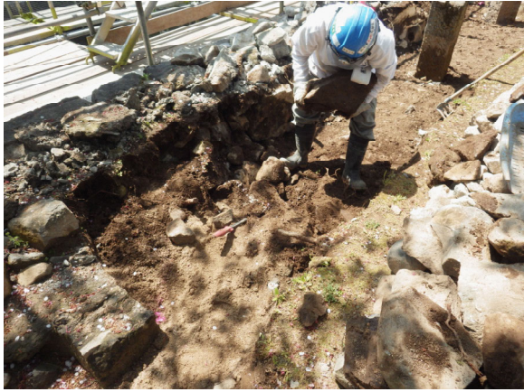
工事①施工状況 掘方整形 栗石などの掘削
