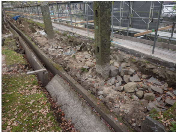
工事④施工状況 解体終了後（北東から）
