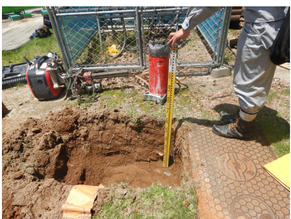
地点 2 完掘状況 (東から)
