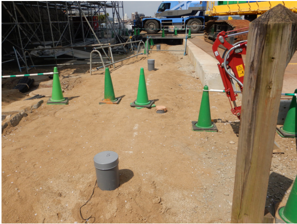
大天守前配管設置状況
