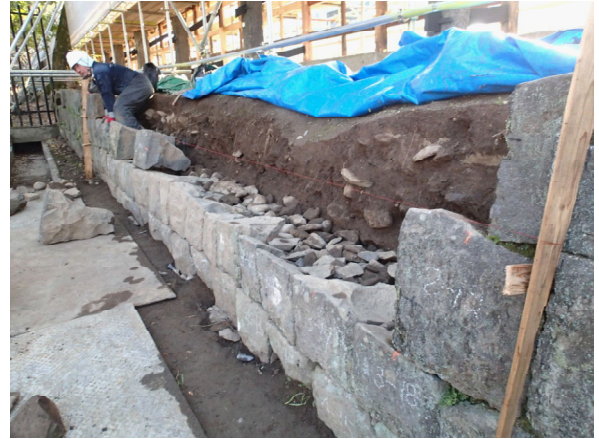
↑ 工事④施工状況 石積作業状況
