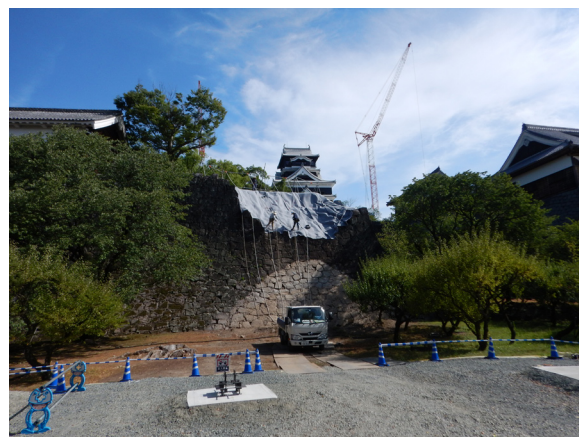
安全対策工事实施状況
