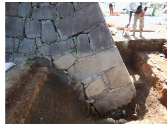
石垣立面（西から）
