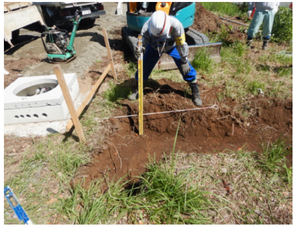
完掘状況（南から）
