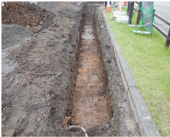
地点1 完掘状況（南から）
