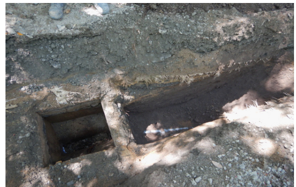
旧2番柵検出状況(北から)
