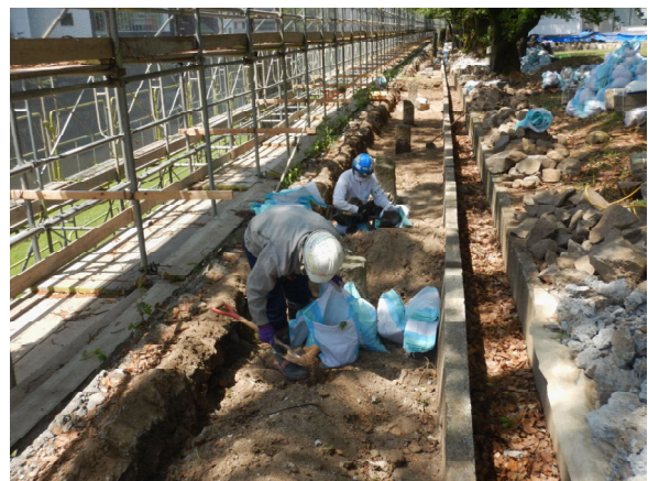
工事①施工状況 掘方最終整形
