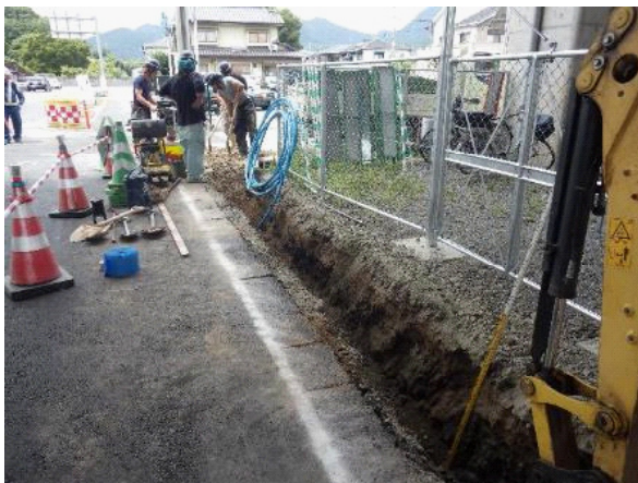
掘削状況（東から）（史跡外）
