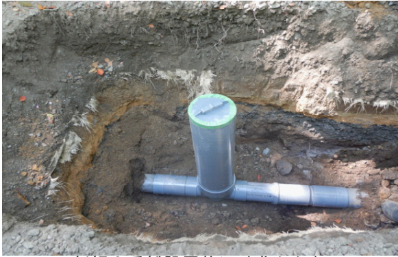
新規3番柵設置状況（北から）
