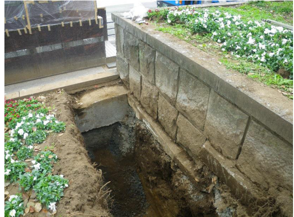
1 トレンチ 北壁土層堆積状況（東から）
