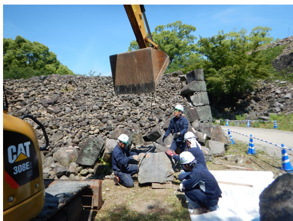
崩落石材回収作業実施状況
