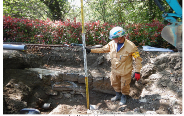
旧4番柵撤去状況（北から）
