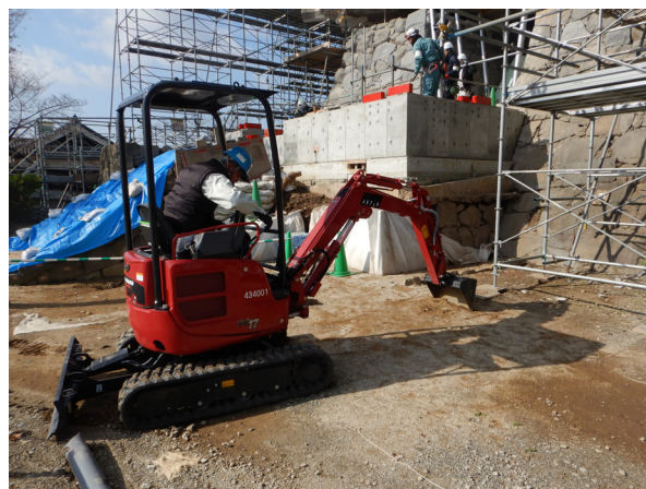
大天守附櫓前掘削状況
