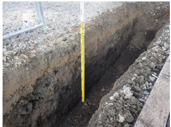
掘削状況（南から）（史跡内）
