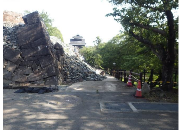
西大手門 H3 崩落石材回収後 (北から)
