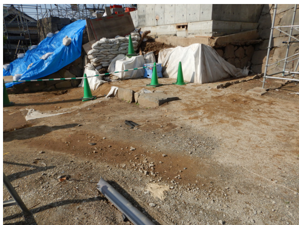
大天守附櫓前掘削前状況
