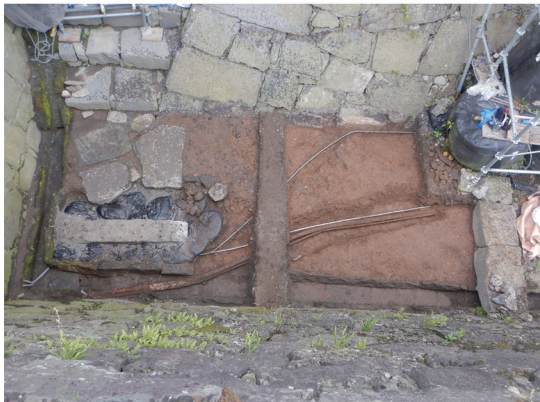
電線検出状況
