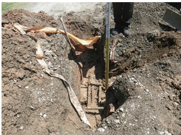
掘削状況 (西から)
