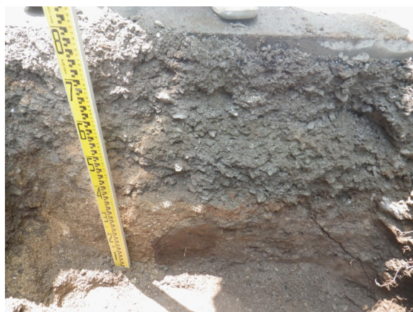
土層断面（南から）
