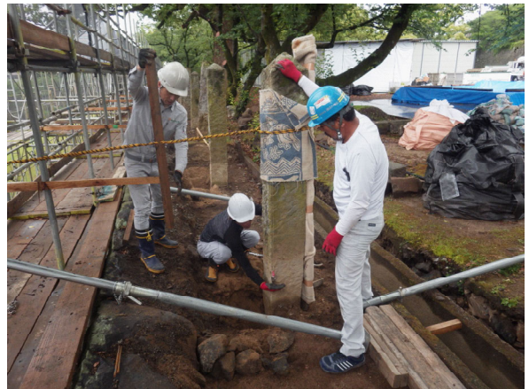
工事③施工状況 立て起こし作業
