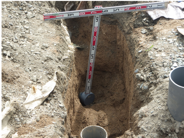
御裏五階櫓前掘削後
