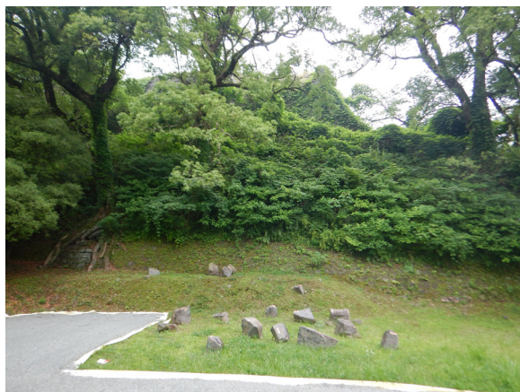
数寄屋丸 H308 崩落石材 (西から)
