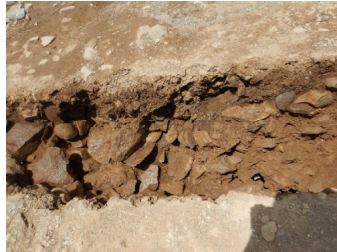
地割れ部分壁面（東から）
