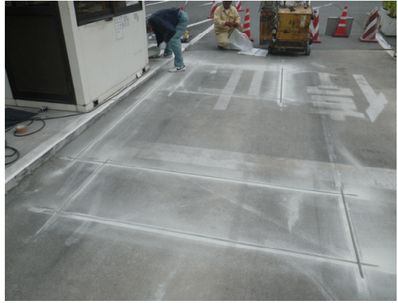
掘削状況（南から）
