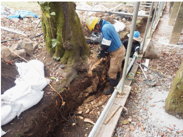
工事⑥施工状況 樹根の切断と掘削
