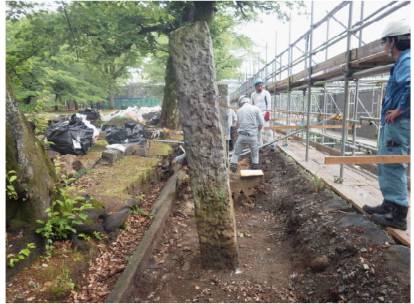
工事③施工状況 立て起こし作業中の柱と被災した柱
