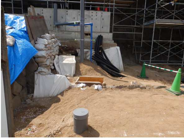
大天守附櫓前配管設置状況
