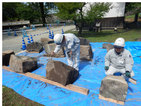
石材回収ナンバリング実施状況
