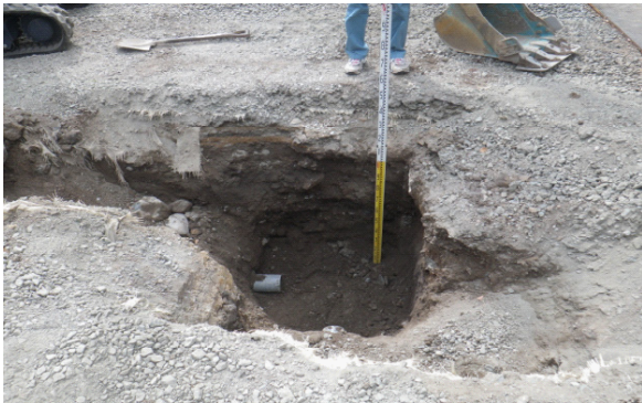
旧6番柵撤去状況（西から）
