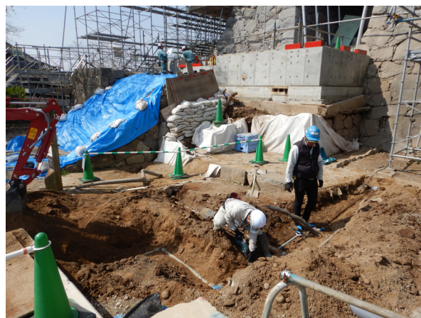
大天守附櫓前配管撤去作業
