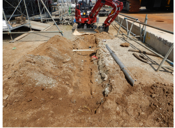
大天守前掘削状況
