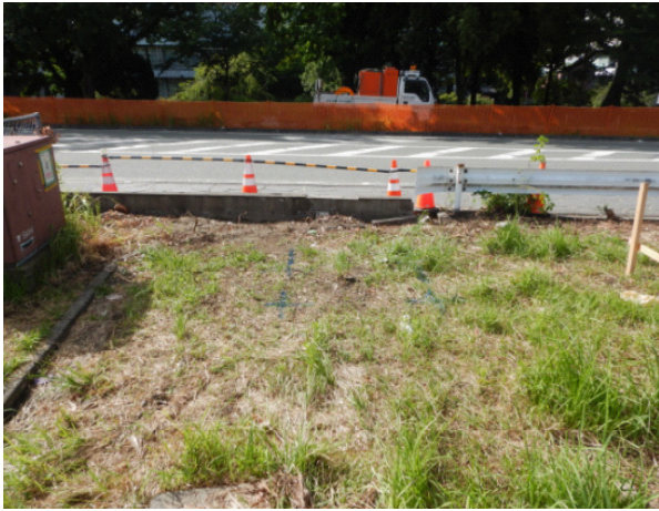
工事立会地点（北から）
