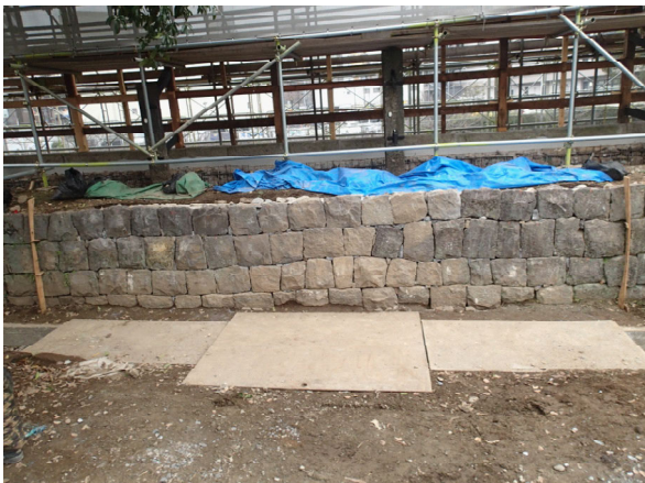
工事④施工状況 工事完了（北から）
