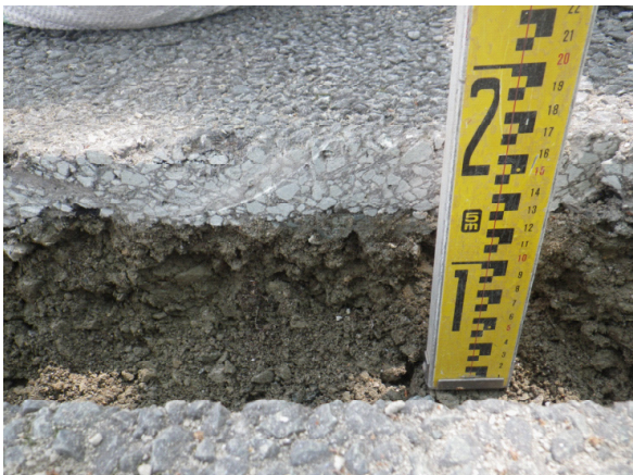
地点1 掘削断面(西から)
