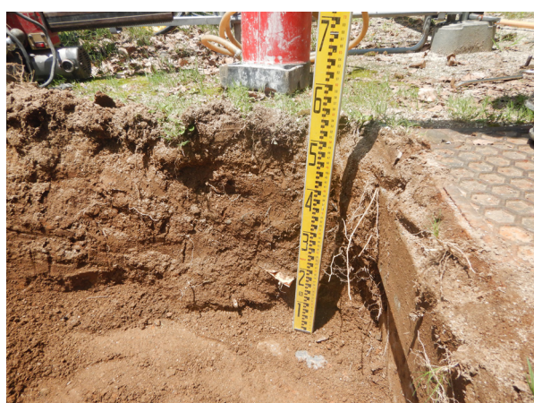
地点 2 土層堆積状況
