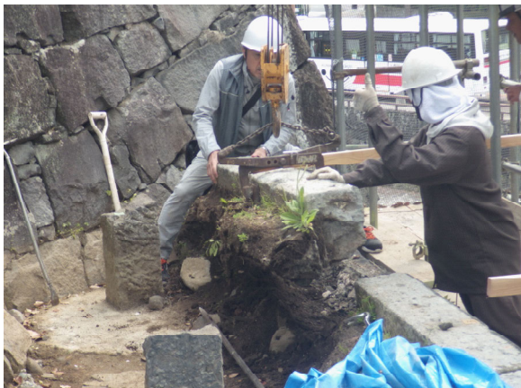
工事②施工状況 基礎石取り外し
