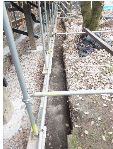
← 工事⑥施工前状況 東端部（東から）
