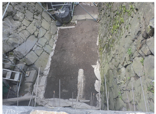
埋め戻し状況
