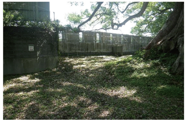
調査前風景 D地点（南から）
