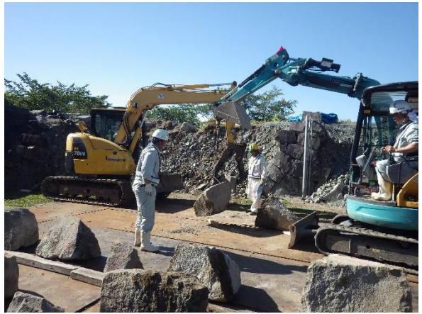
崩落石材回収状況
