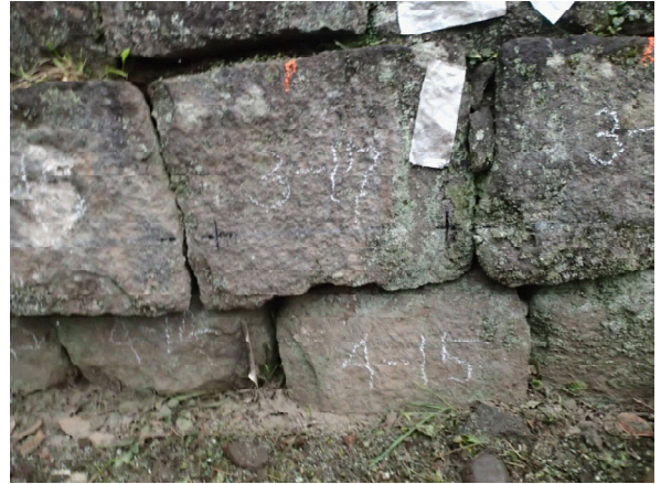
工事⑤施工状況 ナンバリングと墨付
