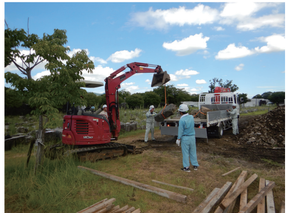
石材仮置き作業状況
