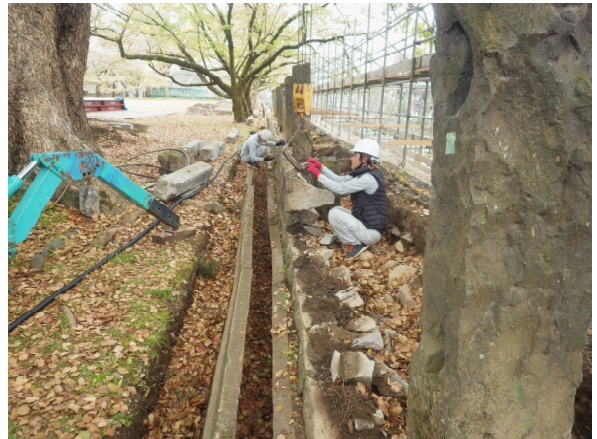
工事④施工状況 解体
