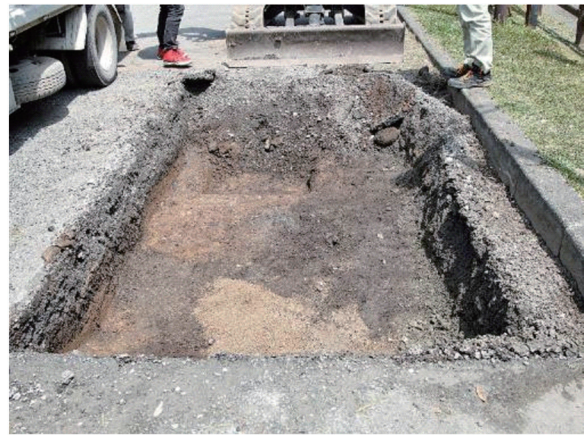
1トレンチ (南から)
