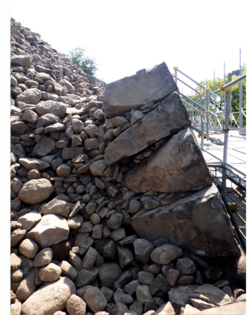
江戸期当初（五階櫓台構築時）の築石と裏込め
