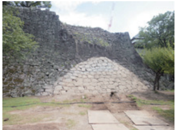
数寄屋丸 H323（東側）崩落石材回収後（南西から）
