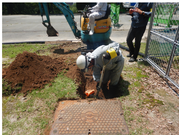
地点 2 掘削作業中 (北から)
