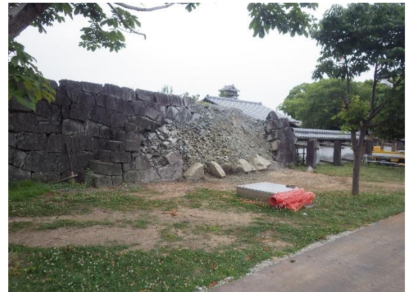
奉行丸 H38 崩落石材回収後 (南西から)
