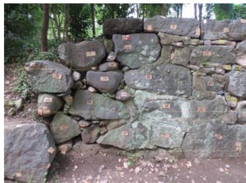
写真 28 積直し後拡大②（南東より）
