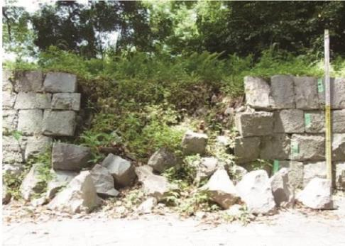
P1 地震による石積崩落部分 南から
