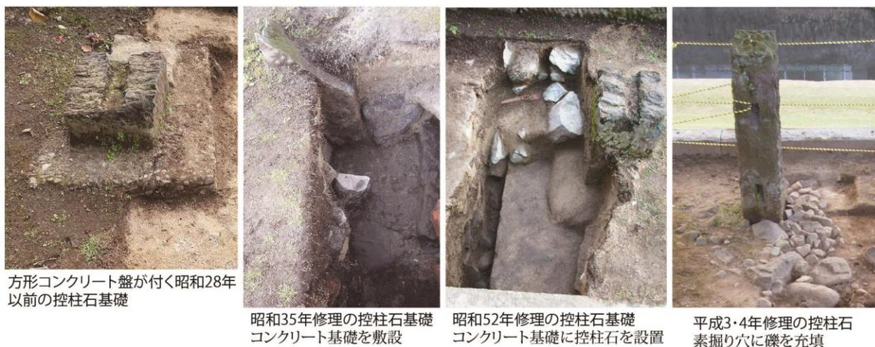
図7 長塀の控柱石基礎の種類
