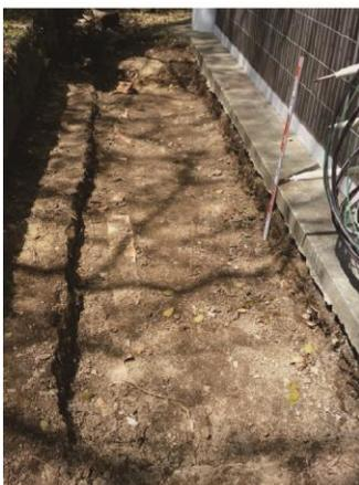
掘削後全景・基底部に低圧ケーブル埋設
