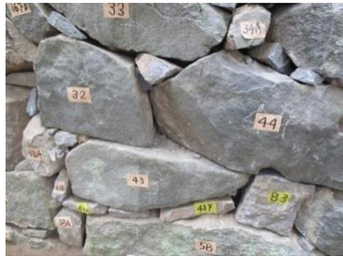
写真 22 積直し後の逆石 No. 43（南東より）
