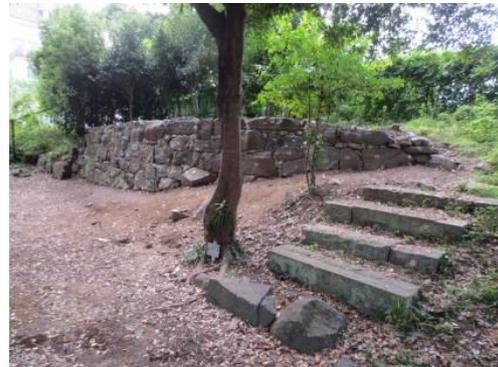
写真 26 積直し後全景②（北東より）
