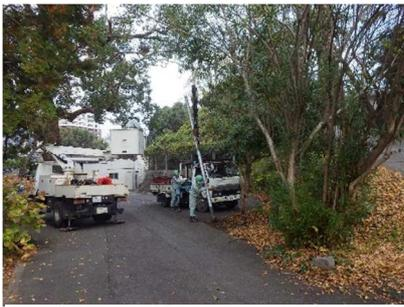
(5) 工事風景 電柱撤去
