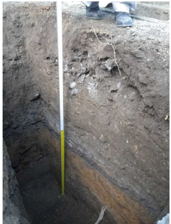
銅板設置部分掘削状況
