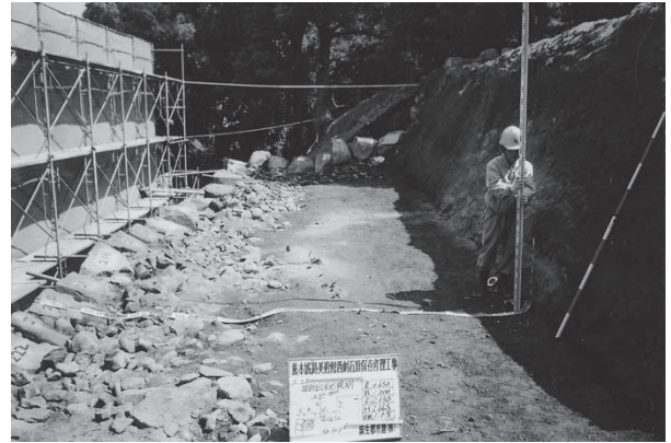
掘削完了検測 B 面
