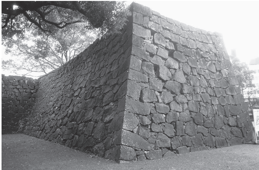
着工前 CD面 隅角部
