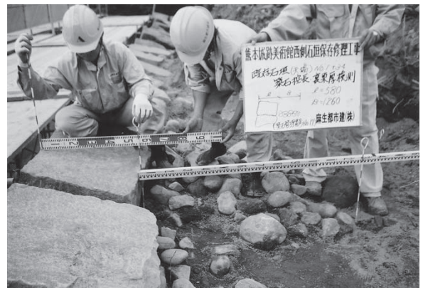
築石検測状況B面
