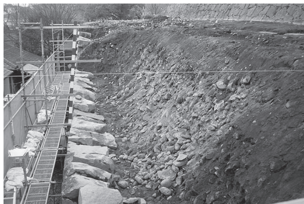
解体完了 L 面
