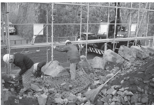
解体状況 C 面
