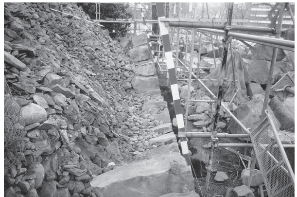
解体状況 B 面 東
