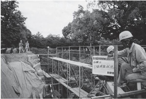
丁張設置検査状況 C 面
