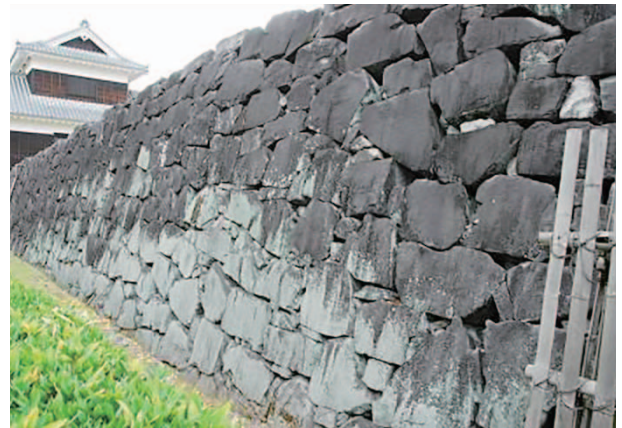
西出丸北（災害復旧）
