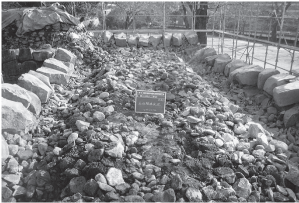
解体状況全景 東側 1
