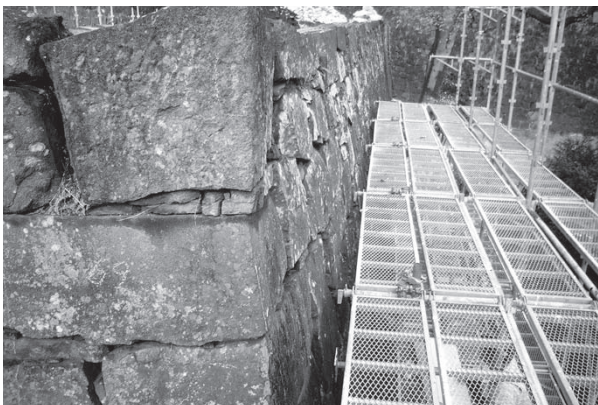
着工前天端 A面
