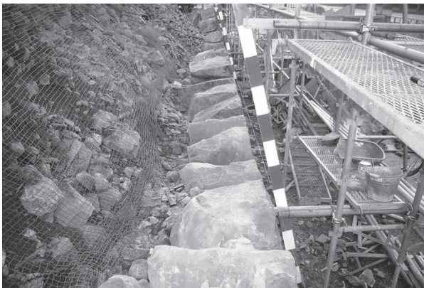
解体状況 B 面
