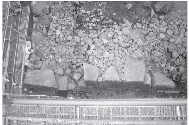
解体完了 CD隅部
