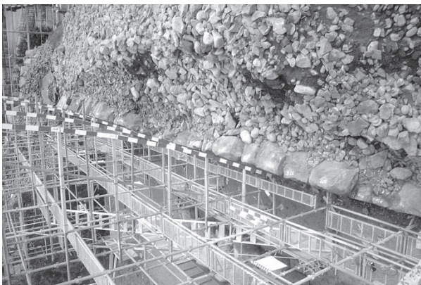
D面 遣り方設置
