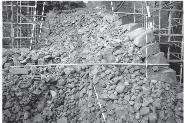
解体状況 A E 面
