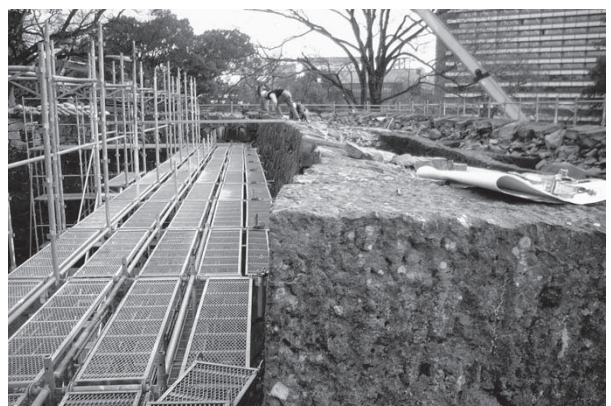
着工前天端 D面
