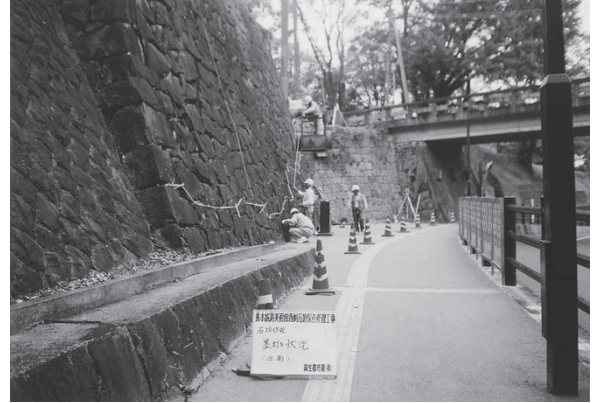
墨打ち状況B面
