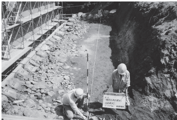
掘削完了検測 B 面
