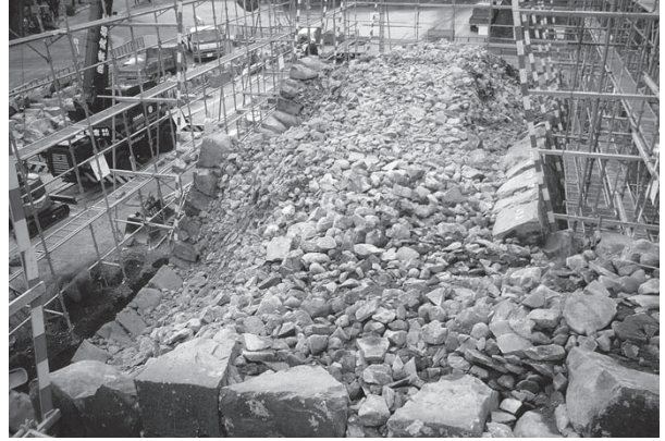
解体状況全景 西から
