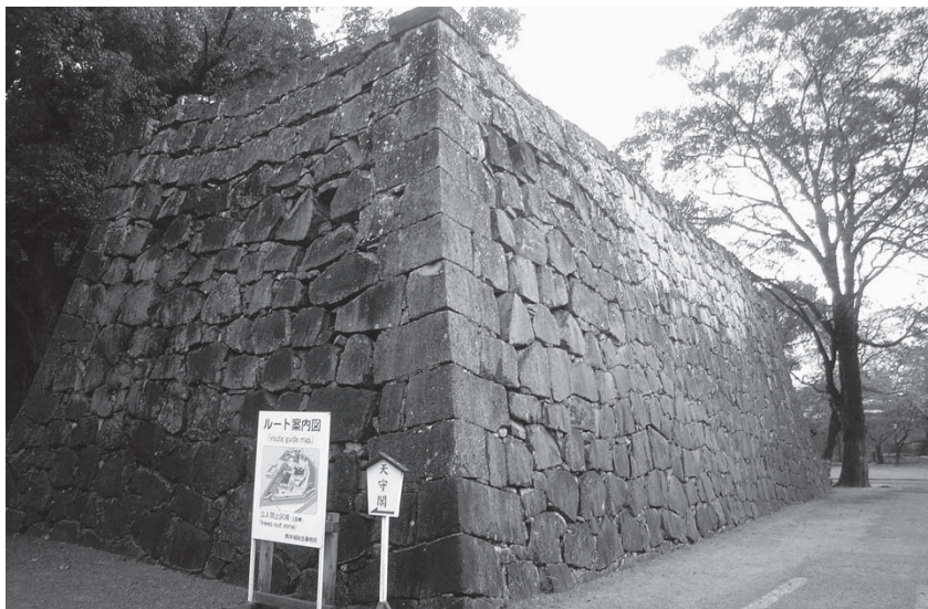
着工前 BC面隅角部
