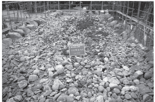
解体状況全景 西側
