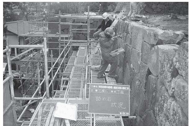
詰石、間詰め状況
