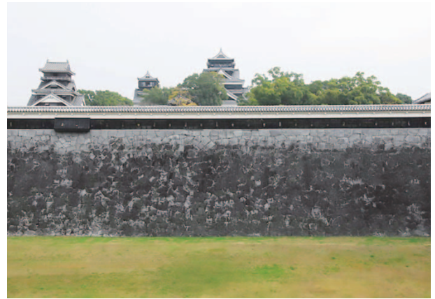
西出丸<戌亥櫓～西大手門>
