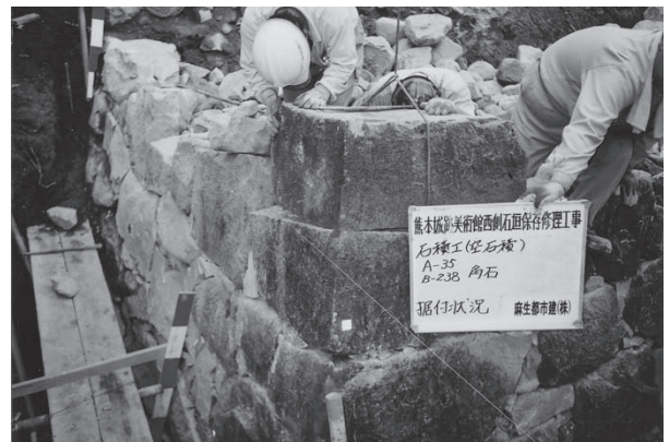
角石据付状況 A B 隅部
