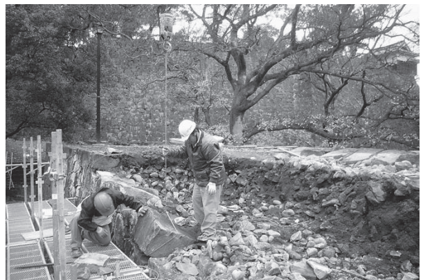
解体状況 E 面
