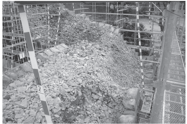
解体状況全景 東側 2
