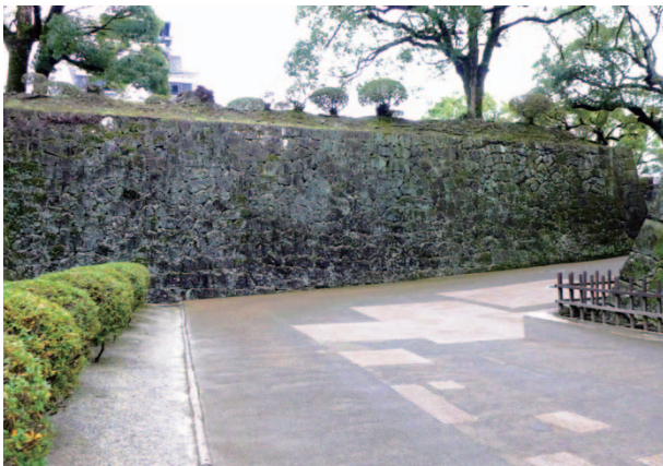
頼当御門突当石垣（金峰山地震による崩壊後の復旧）
