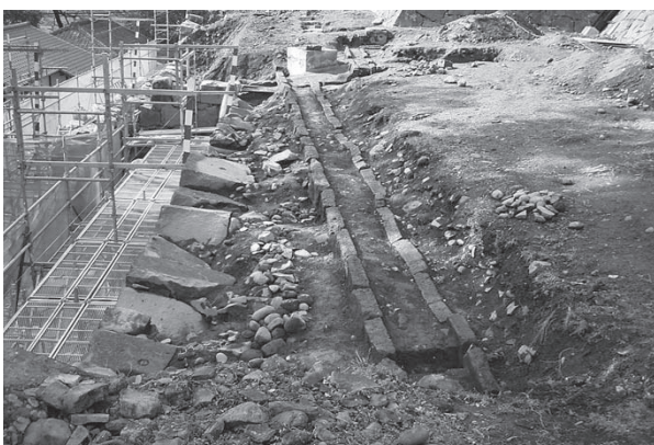
解体完了L面
