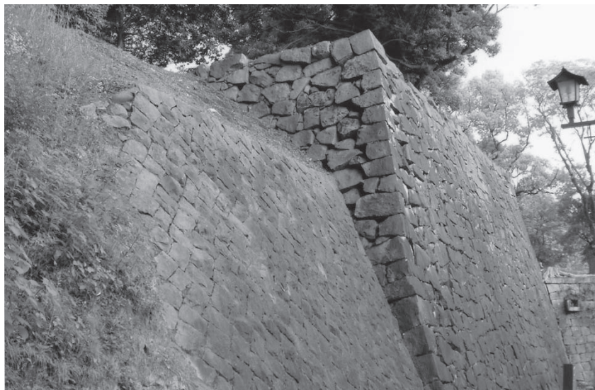
A面着工前
