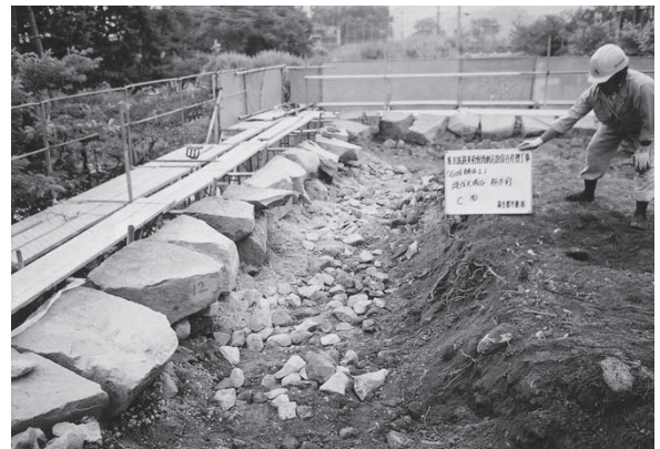
天端掘削状況A B面
