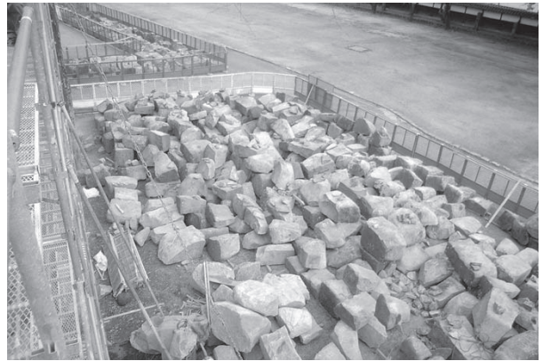
築石仮置き状況 2
