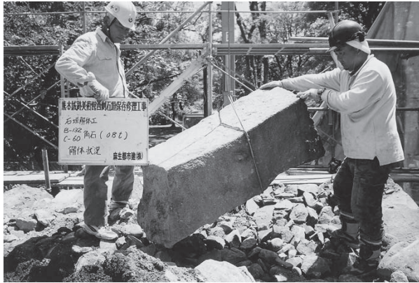
角石解体状況 B C 面
