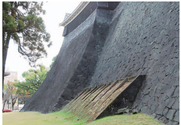
五間櫓下石垣補強の施工現況（昭和34年施工）
