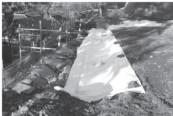
吸出し防止シート敷設 J 面
