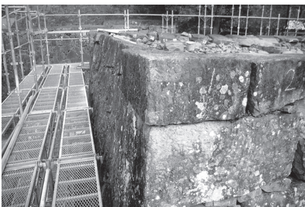
着工前天端 C面
