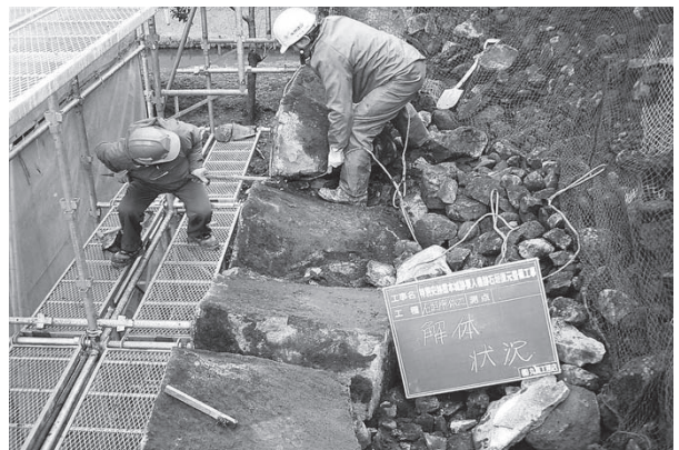
解体状況L面
