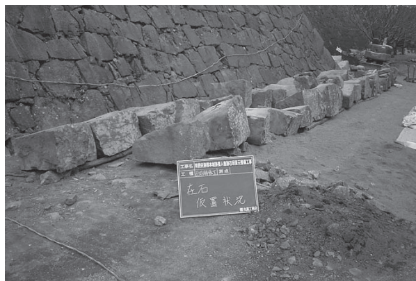
築石仮置き状況
