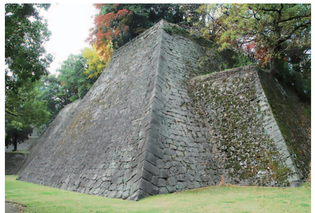
櫓方三階櫓台、北東面
