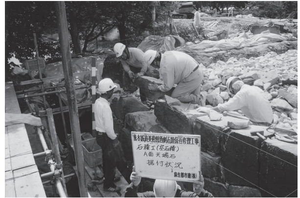
天端石据付A面
