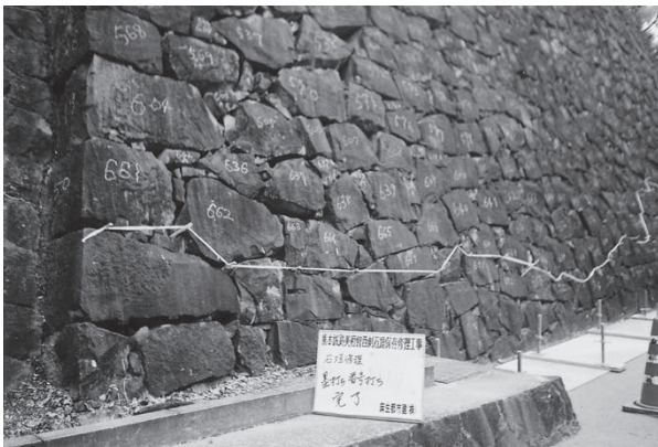
番号打ち状況B面
