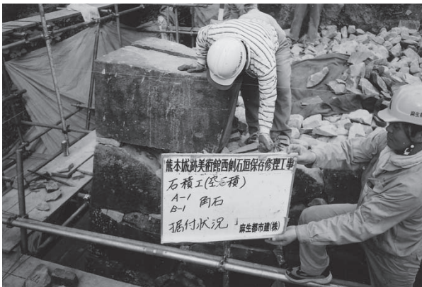
角石天端石据付A B面
