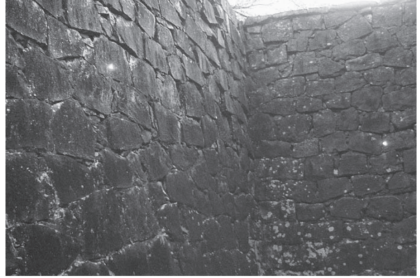
着工前 DE面 入隅部
