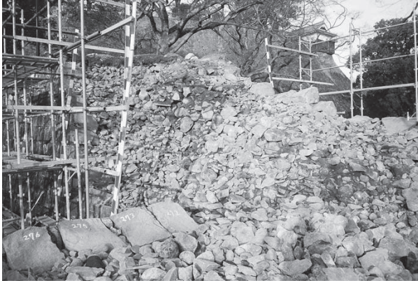
解体完了 DE入隅部
