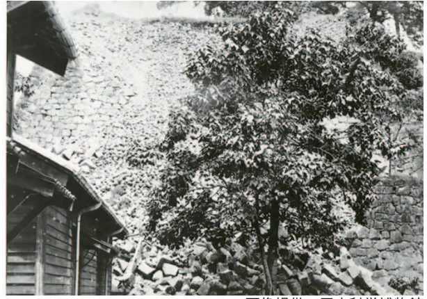
画像提供：国立科学博物館 旧熊本城飯田丸 第六師団火薬庫上石垣崩壊之景
