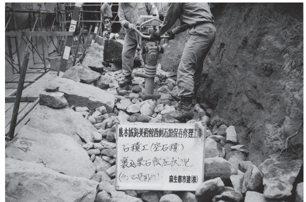
裏込栗石転圧状況 B 面
