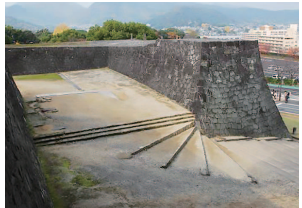
二の丸御門（通路整備）
