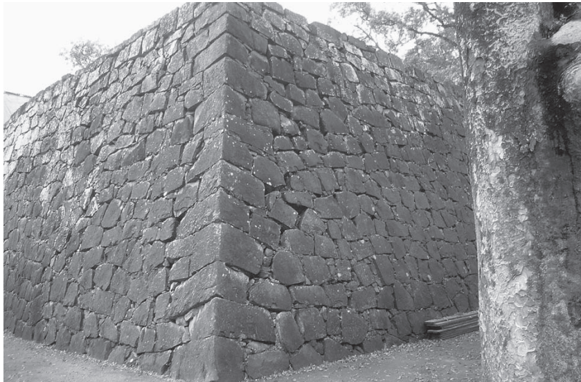
着工前 AB隅角部
