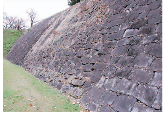
棒庵坂、南法面
