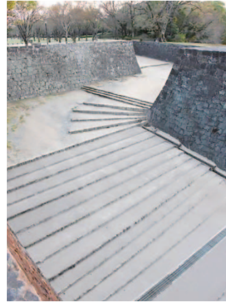
二の丸御門 (通路整備)
