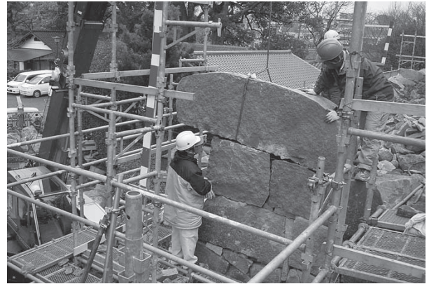
角石仮据え状況 K L 面隅
