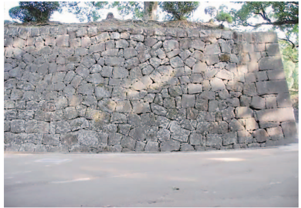
数奇屋丸櫓門東側（金峰山地震による崩壊後の復旧）
