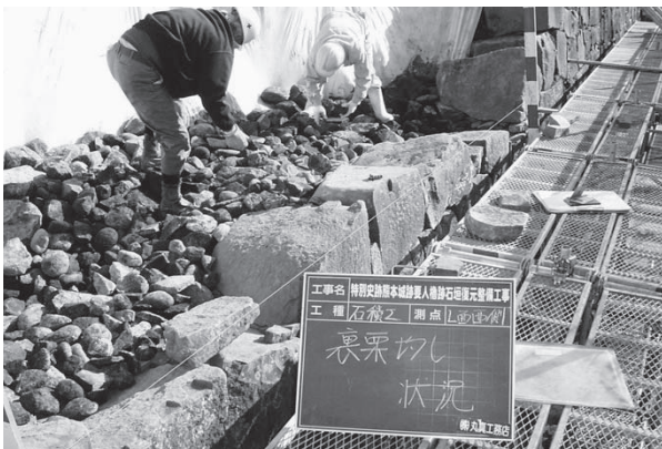
裏込栗石敷均し状況
