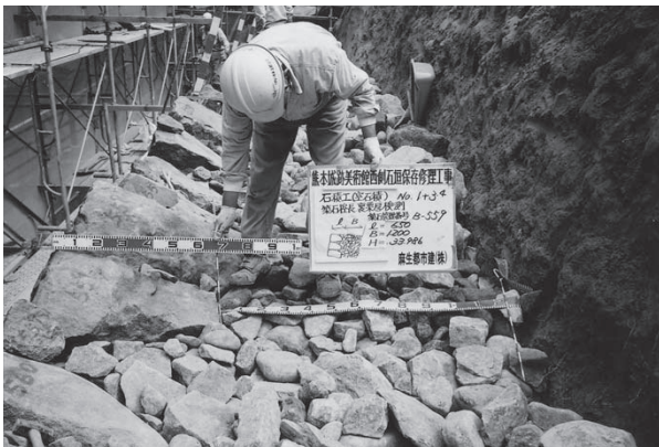
築石及び裏込栗石検測 B 面
