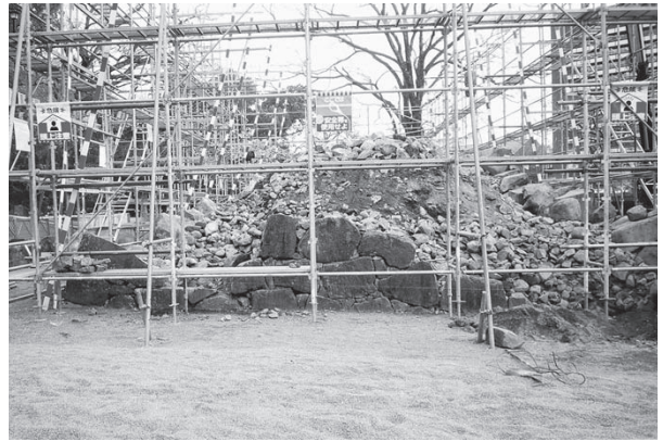
解体完了 C面1
