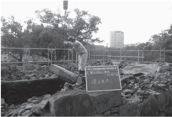
解体状況、建物礎石
