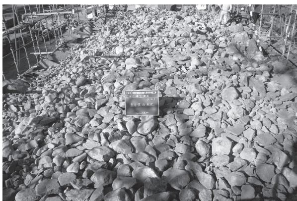
裏込栗石敷込全景
