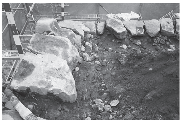
解体完了K L面出隅部
