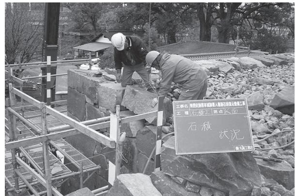
復築状況 K 面天端
