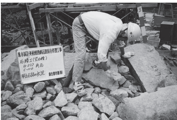
胴込栗石充填状況 B C 面
