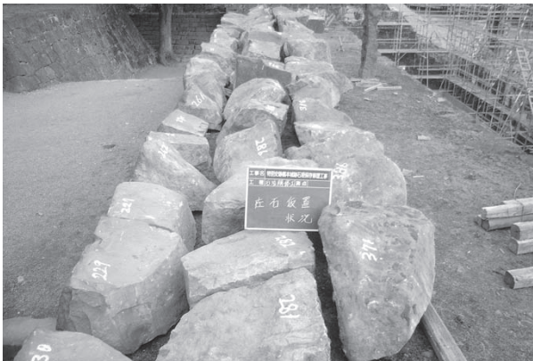
築石仮置き状況 3
