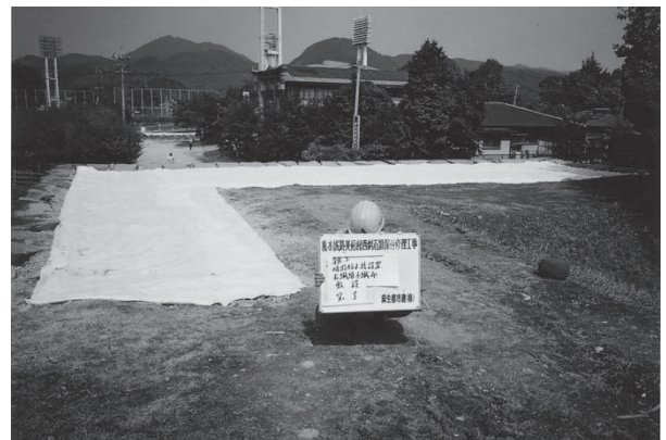
吸出し防止シート敷設A B面
