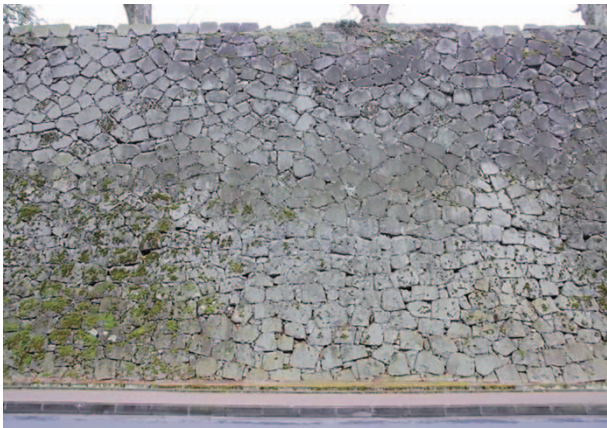
百間石垣西側（金峰山地震による崩壊後の復旧）
