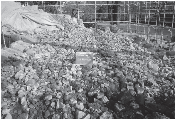
解体状況全景 東側 3
