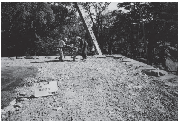
砕石転圧状況A B面
