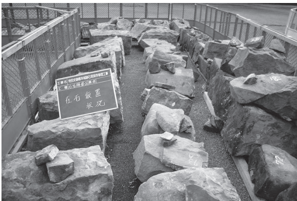
築石仮置き状況
