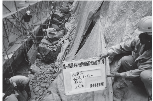
鉛板設置状況 B 面
