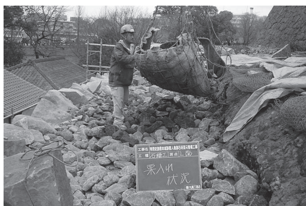
裏込栗石搬入状況
