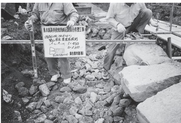
築石検測状況C面
