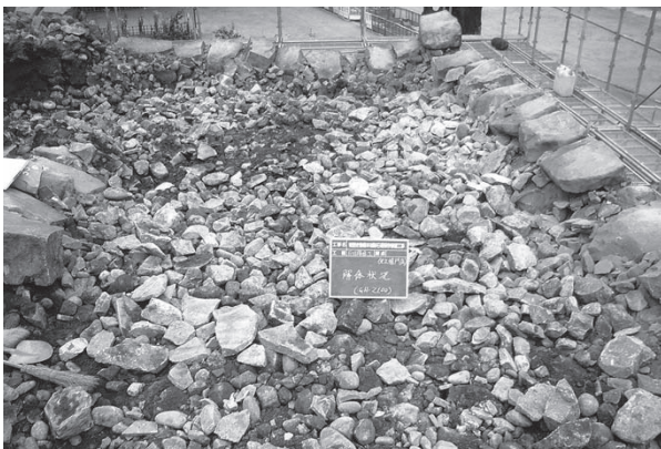
解体状況 A B 面隅部
