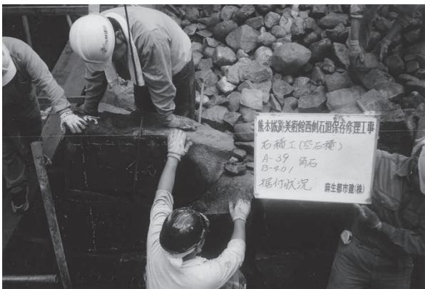
角石据付状況 A B 隅部
