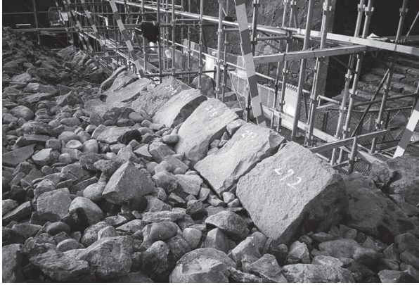
解体状況 D面
