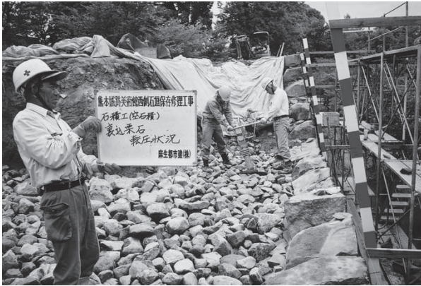
裏込栗石転圧状況C面
