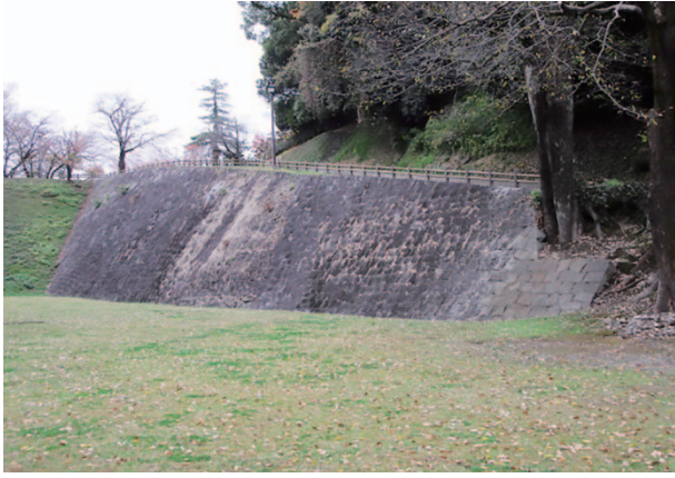
棒庵坂、南法面
