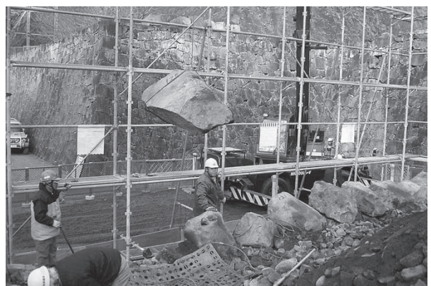
解体状況 C 面
