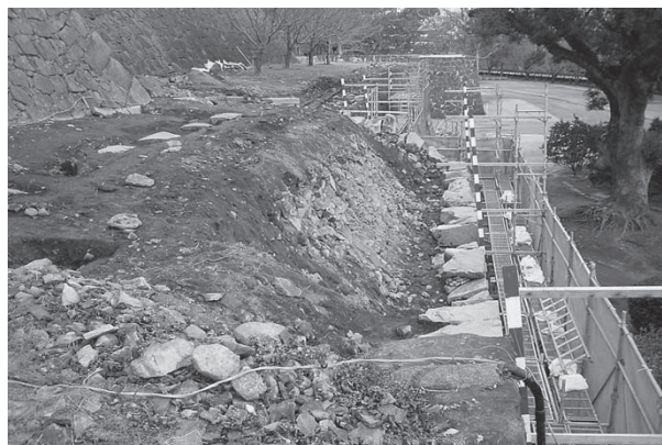
解体完了 遣り方設置
