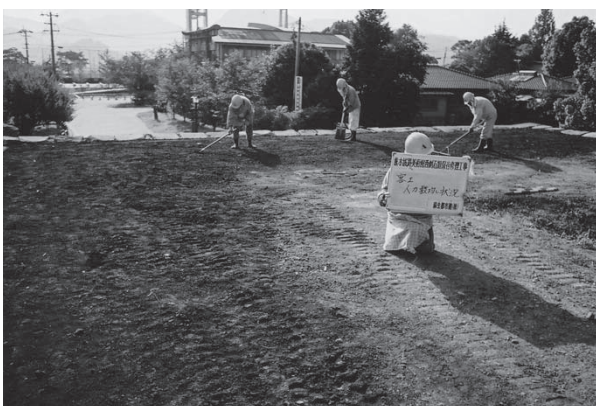
覆土敷均し状況A B面
