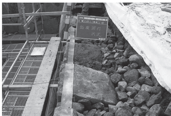
鉛板敷き込み L 面
