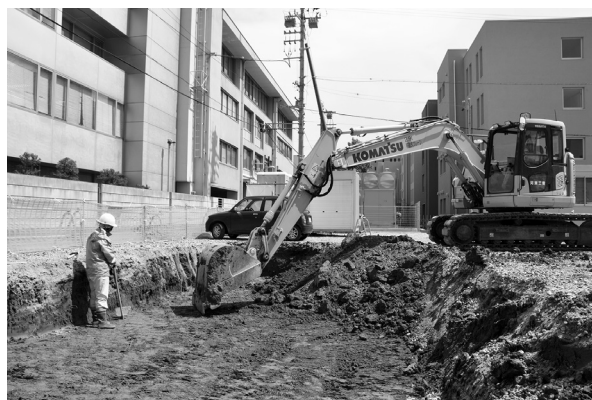
重機表土剥ぎ
