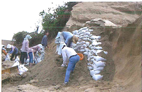
写真8 2005年9月 台風により崩落した砂丘の復旧作業
