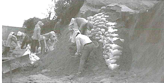
写真8 2005年9月 台風により崩落した砂丘の復旧作業
