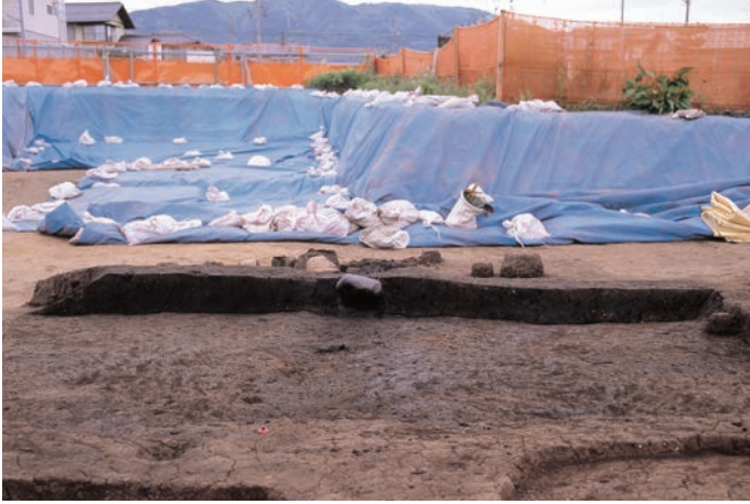
SB72 断面 (南から)
