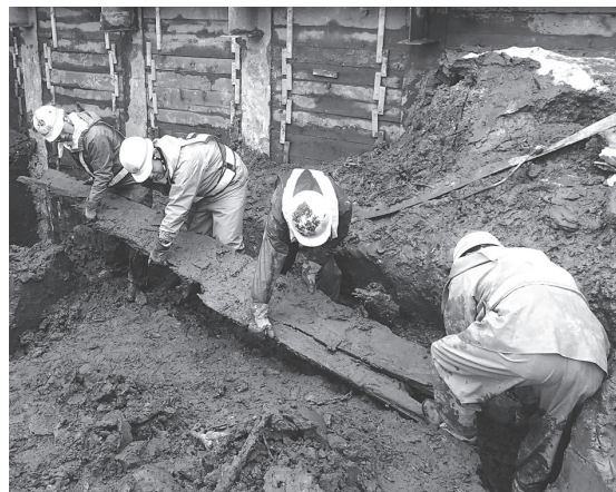
横矢板 (93) 取り上げ状況
