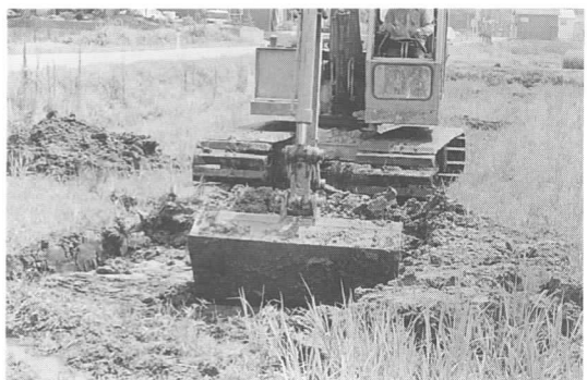
重機での発掘（水田部分）
