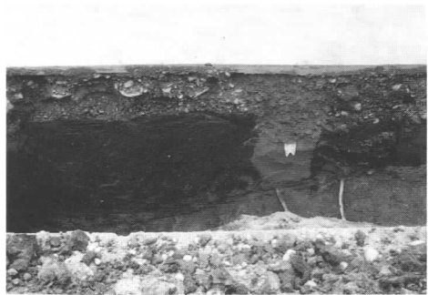
堀・西側土層断面
