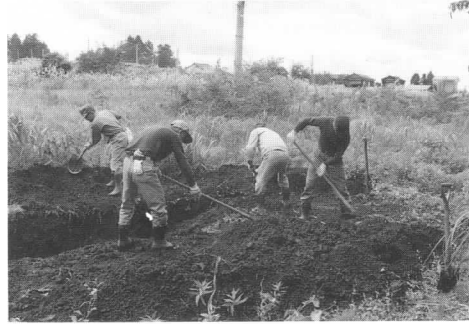
4 埋め戻し作業（48T、西側から）
