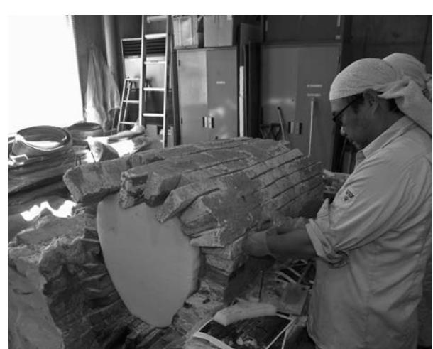
fig.143 上半部煉瓦組み上げ作業
