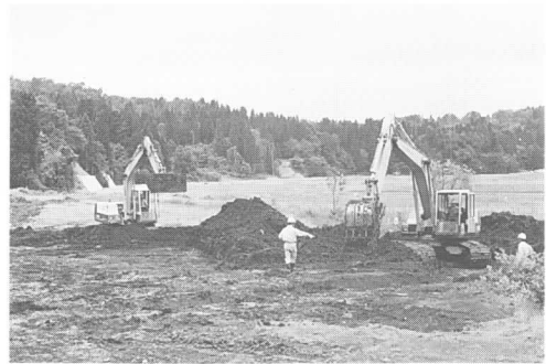
④表土除去作業状況（西地区、南東側から）
