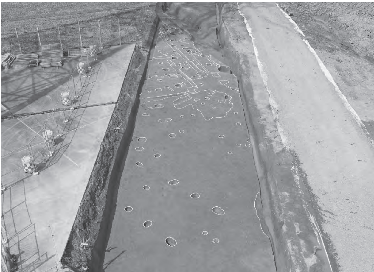
P6区全景 [南西から：手前が掘立柱建物 3 (独立棟持柱建物)]
