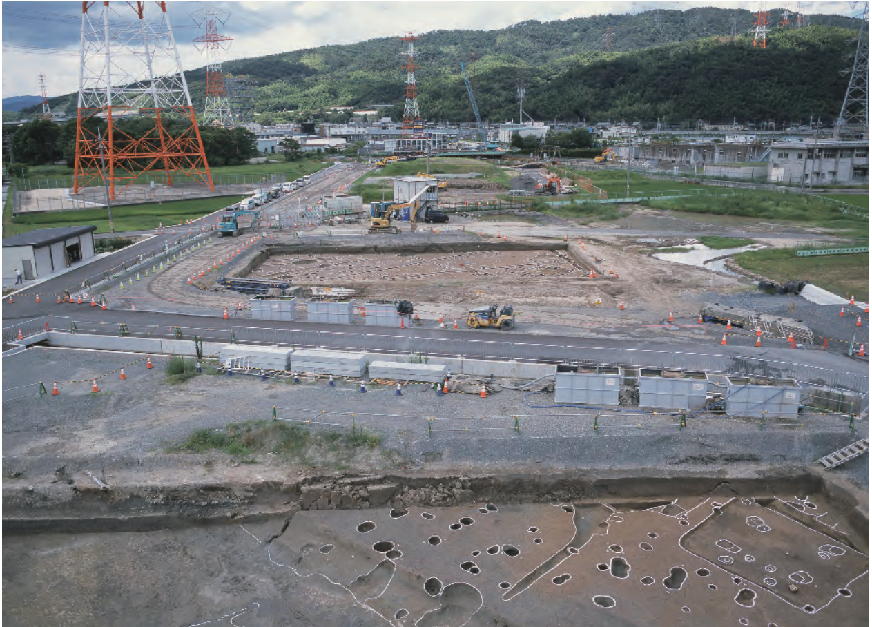
上牧遺跡の発掘調査と並行しておこなわれる高速道路建設事業 [P2区(手前)・P3区(奥) 南東から]
