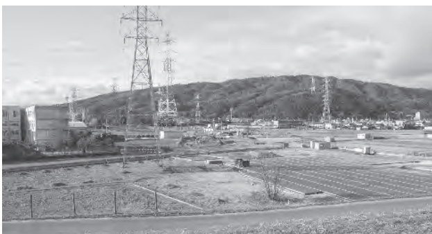
調査地遠景 [南東・淀川堤防から (平成 29 年 12 月 14 日撮影)]
