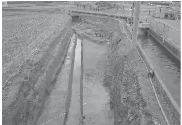
D-1区全景 [北西から：手前は粘土採掘土坑、奥に現水路と並行する近世水路]
