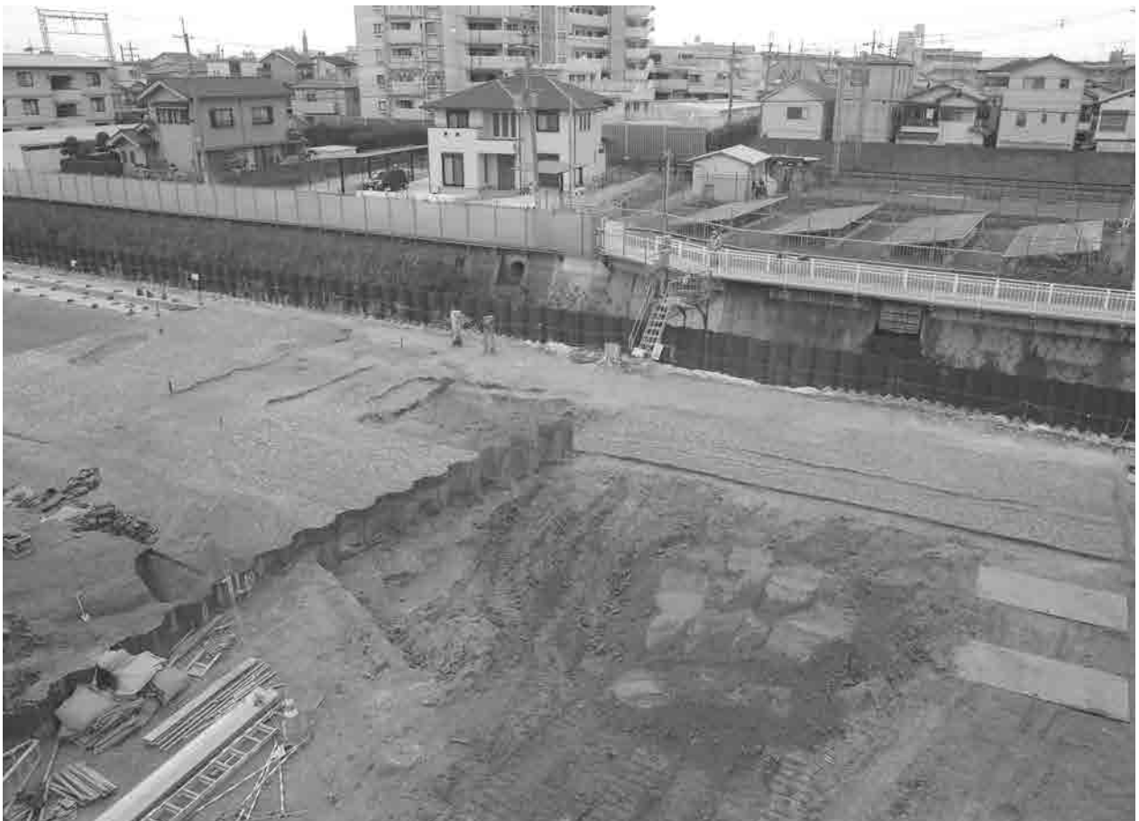
2. 2区第6a面全景（北東から）
