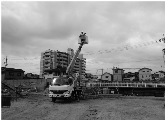
写真5 高所作業車による写真撮影
