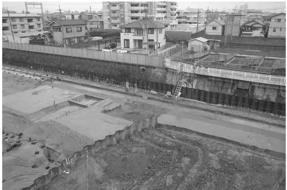
2. 2区第7-1 a面全景 (北東から)
