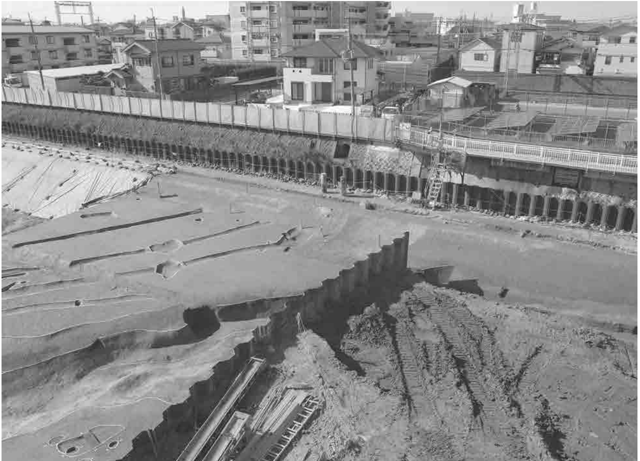
1. 2区第12a面全景（北東から）
