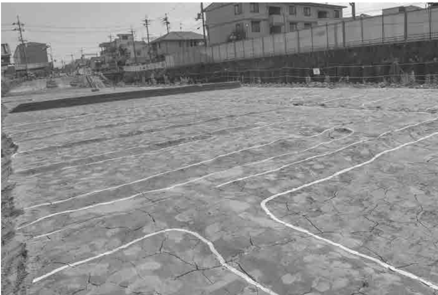
2. 1区第6a面近景 (北東から)
