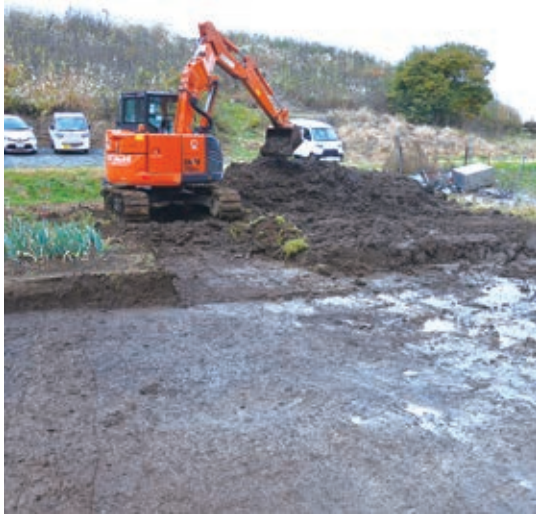
重機による表土除去作業
