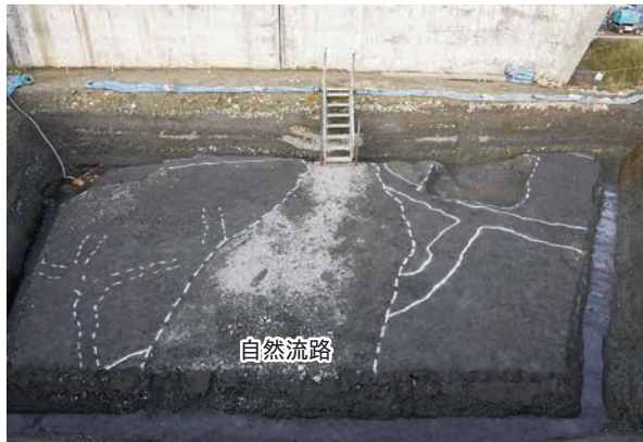
● 南区下層畦畔（南東から）
